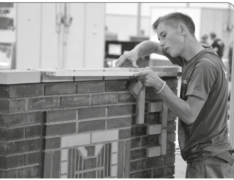
Dolgozni csak pontosan... – Hefkó János kőműves ellenőrzi munkáját
