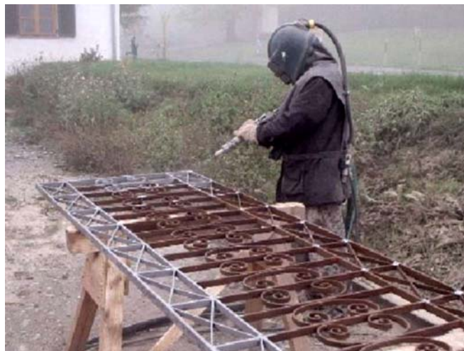
38. ábra. Kerítéselem tisztítása védőfelszerelésben 29
