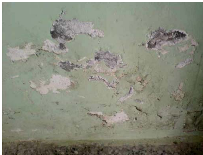
17. ábra. Megkopott olajlábazat
