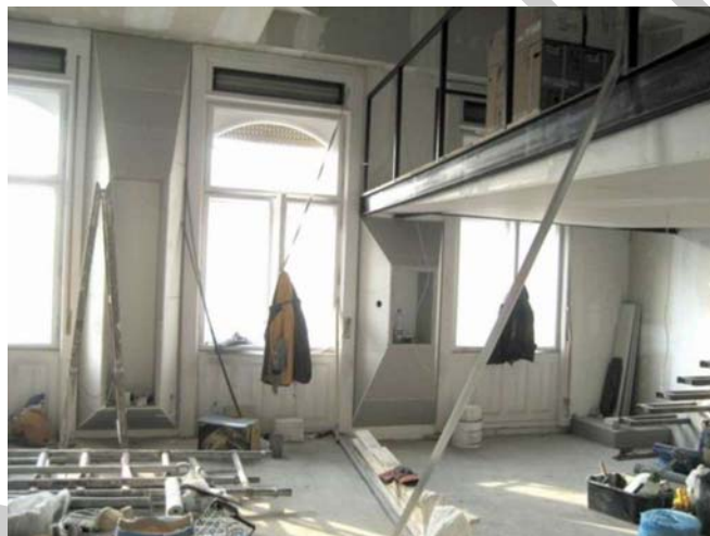
2. ábra. Felújítás alatt álló helyiség 2
