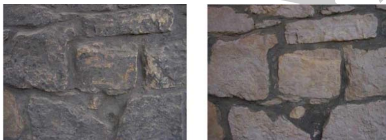
32. ábra. Festett kőfelület tisztítás előtt – és utána 24
