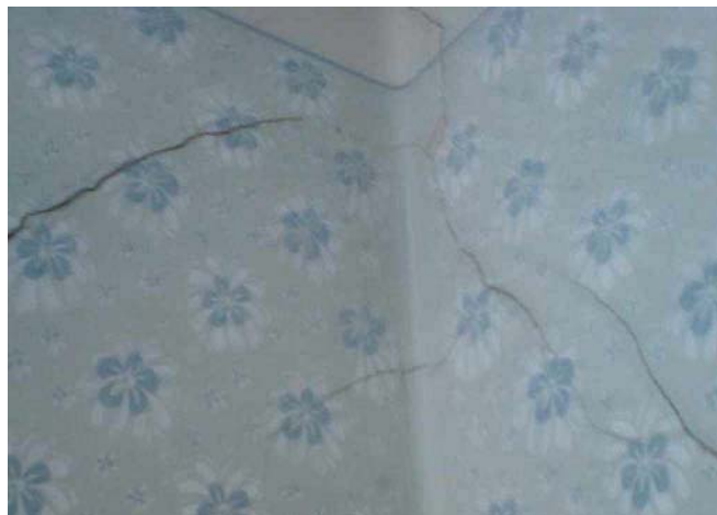
14. ábra. Megrepedezett fal
