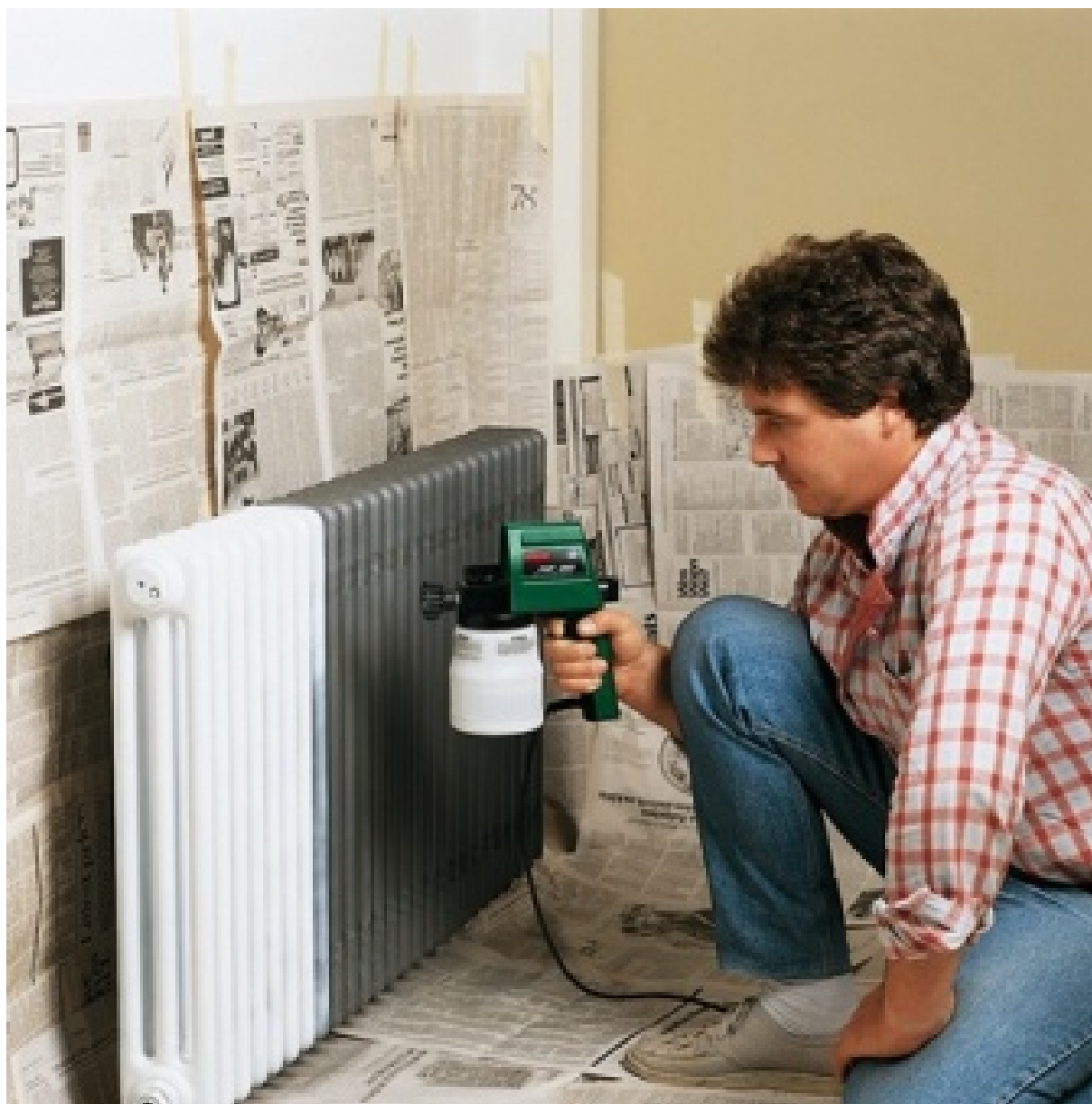
11. ábra. Elektromágneses festékszóró pisztoly alkalmazása 11
