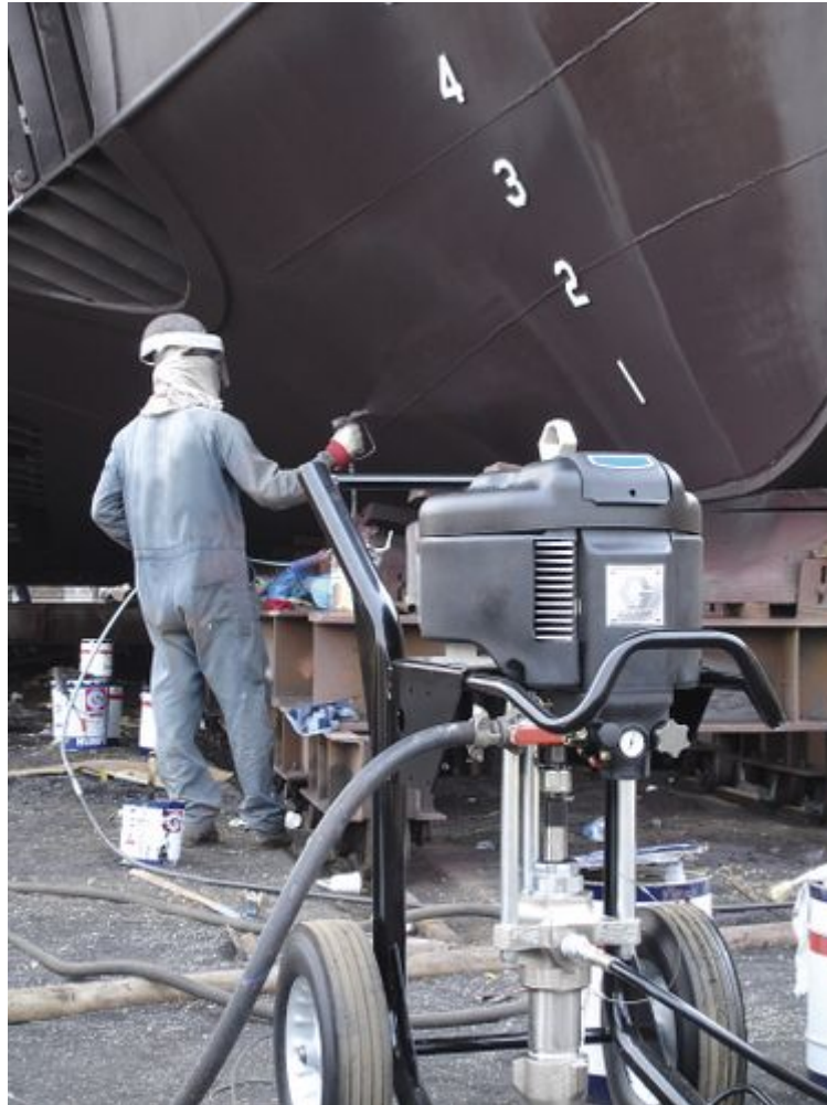
8. ábra. Airless nagynyomású festékszóró berendezés 8
