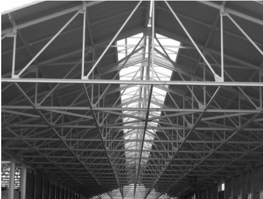
7. ábra. Kevésbé tagolt fémszerkezet
