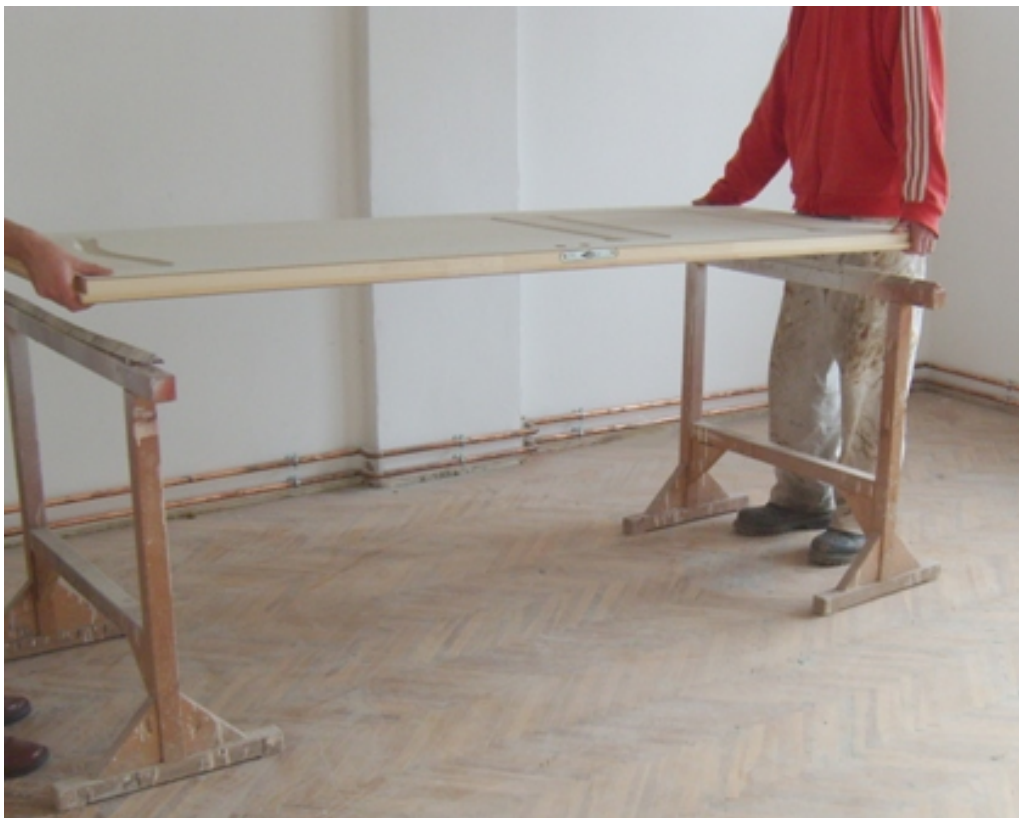
15. ábra. Ajtólap fordítása
