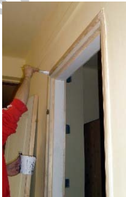
9. ábra. Ajtótok mázolásának második lépése
