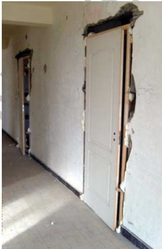
1. ábra. Új ajtó beépítése
