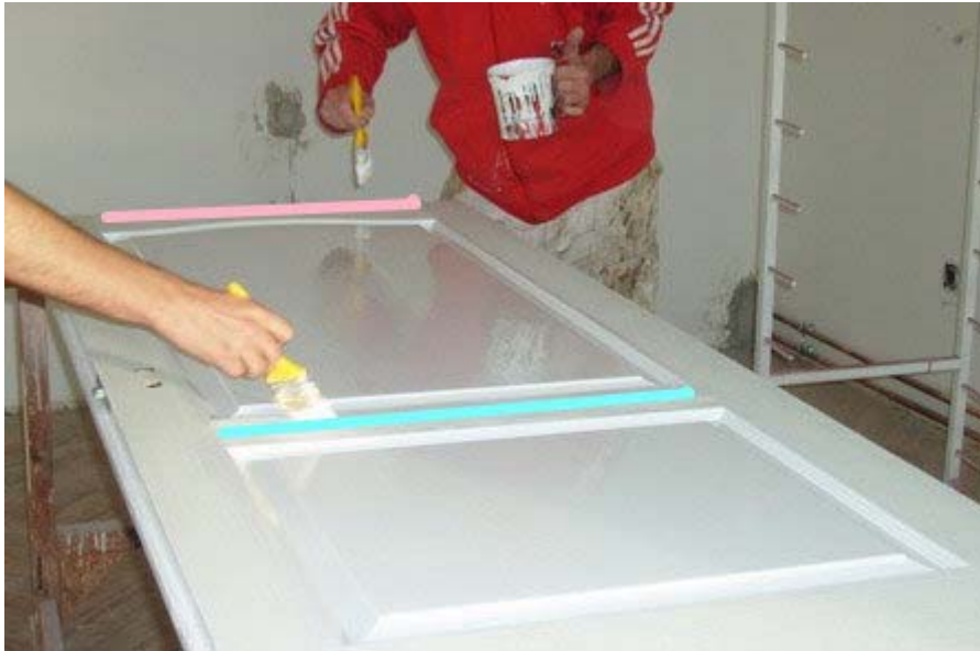
18. ábra. Az ajtólap mázolását a függőleges részekkel fejezzük be.
