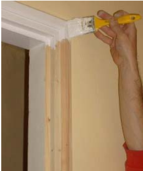
12. ábra. Ajtótok mázolásának ötödik lépése
