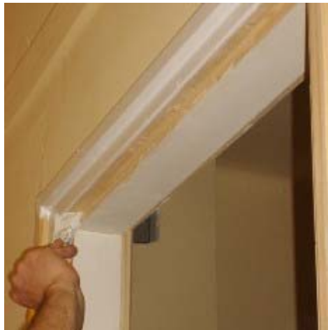
10. ábra. Ajtótok mázolásának harmadik lépése
