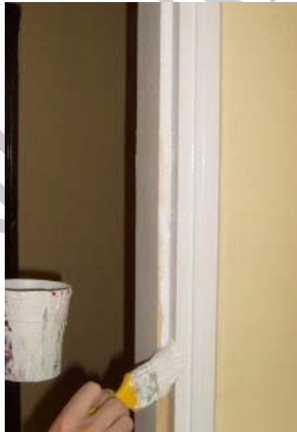
13. ábra. Ajtótok mázolásának utolsó, hatodik lépése
