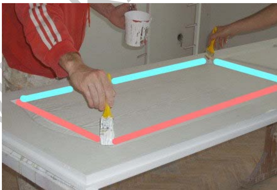
17. ábra. A betétek mázolása után a vízszintes osztások következnek
