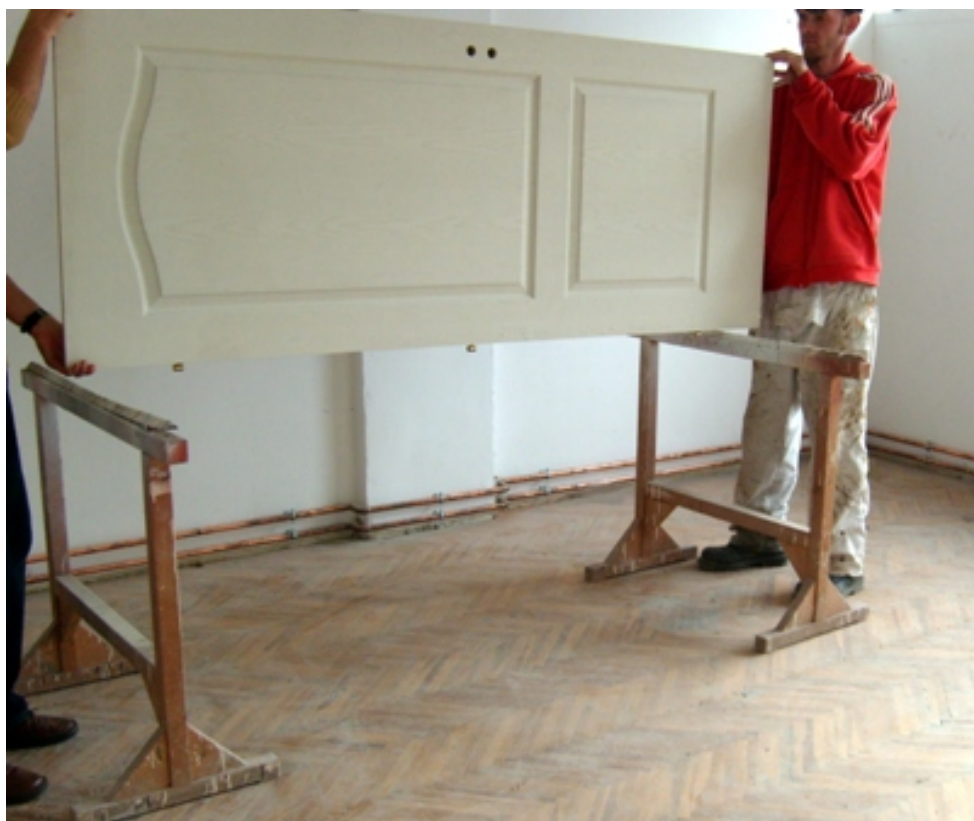
16. ábra. Betétes ajtólap mázolása párban, első lépések
