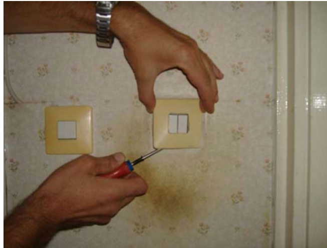
12. ábra. Kapcsolófedél eltávolítása
