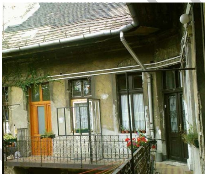
1. ábra. A felújítandó lakás bejárata 1
