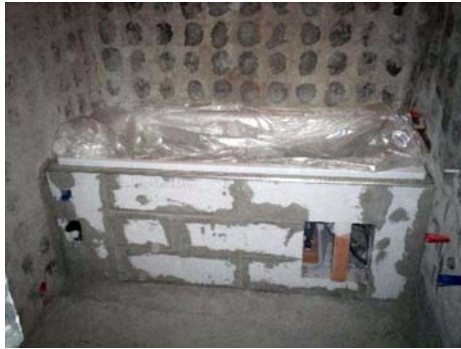
18. ábra. Új fürdőkád beépítése 12
