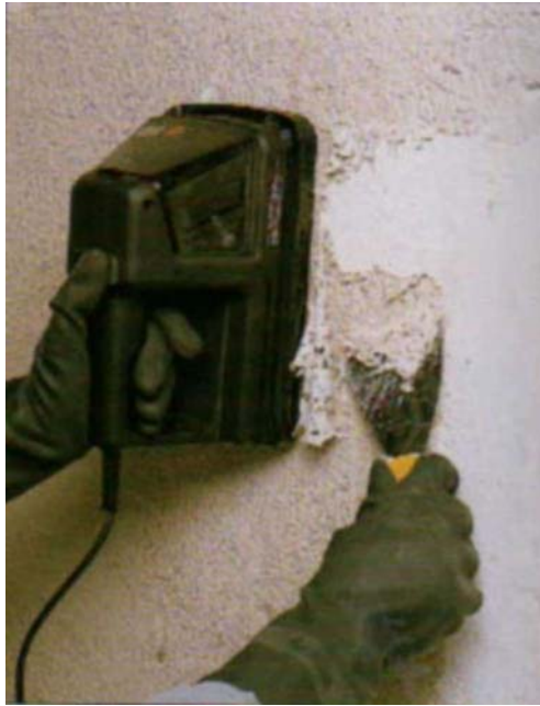
34. ábra. Gőzöléssel történő eltávolítás
