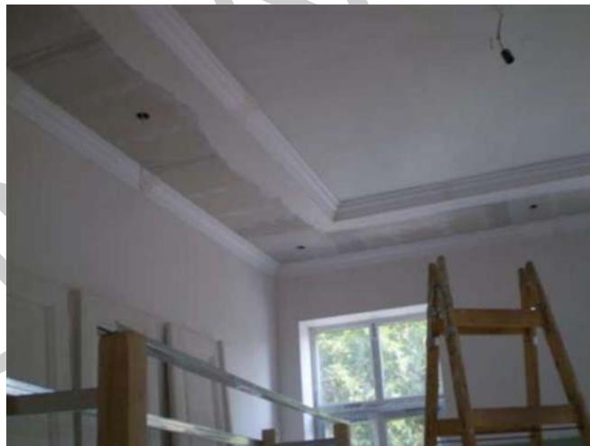
32. ábra. Mennyezet felújítás 17
