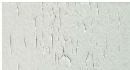
9. ábra Repedezett felület 4
