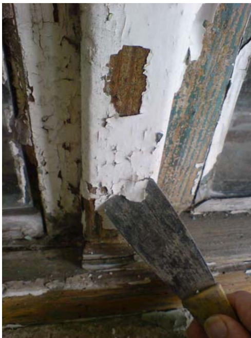
17. ábra. Megrepedezett festékréteg eltávolítása
