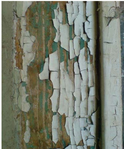
4. ábra. Repedezett festékréteg
