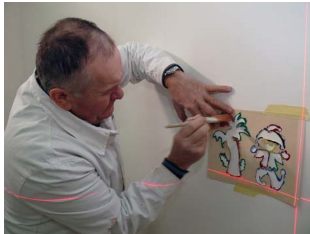
18. ábra. Ecsettel történő papíralapú minta kifestése tupfolással, ragasztószalaggal rögzítve.
