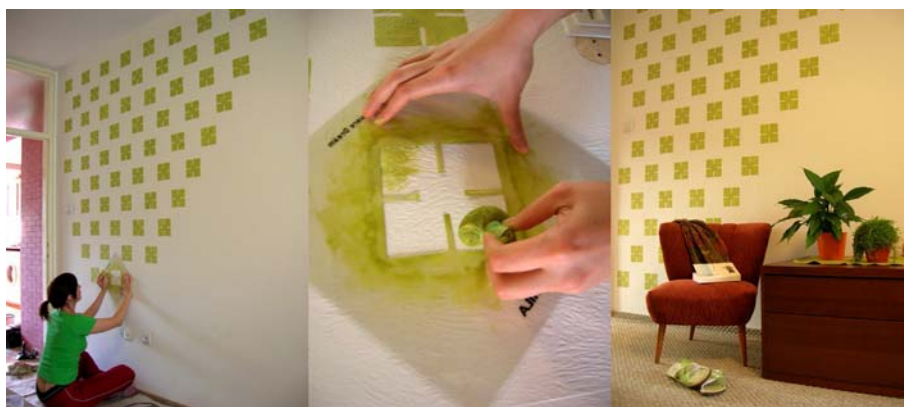
21. ábra. Ismétlődő-terülő, végtelen minta, amelynél láthatóan rendkívül fontos a pontos kitűzés, jelölés. 3
