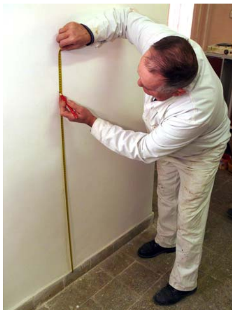
14. ábra. Mérés, jelölés a készre festett falon. 2
