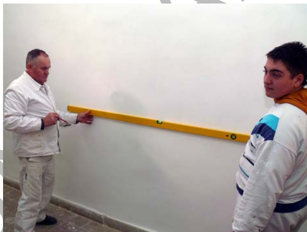
15. ábra. Vízszint beállítása.
