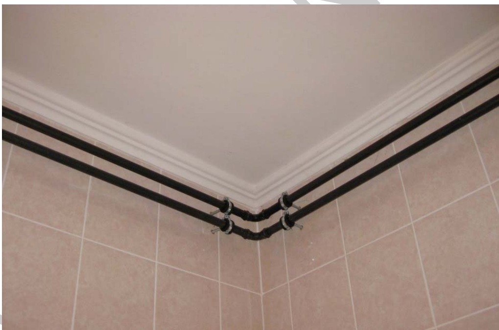
14. ábra. Vizes helyiség mennyezet festése gombaölő szer tartalmú, diszperziós falfestékkel 14
