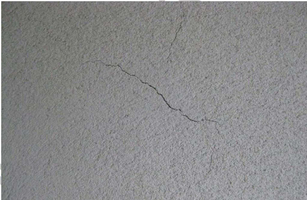
1. ábra. Vakolatrepedés 1
