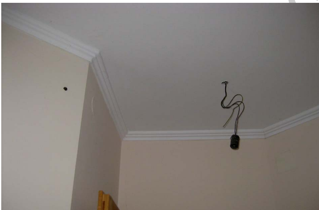
13. ábra. Falfestés belső térben diszperziós falfestéssel 13
