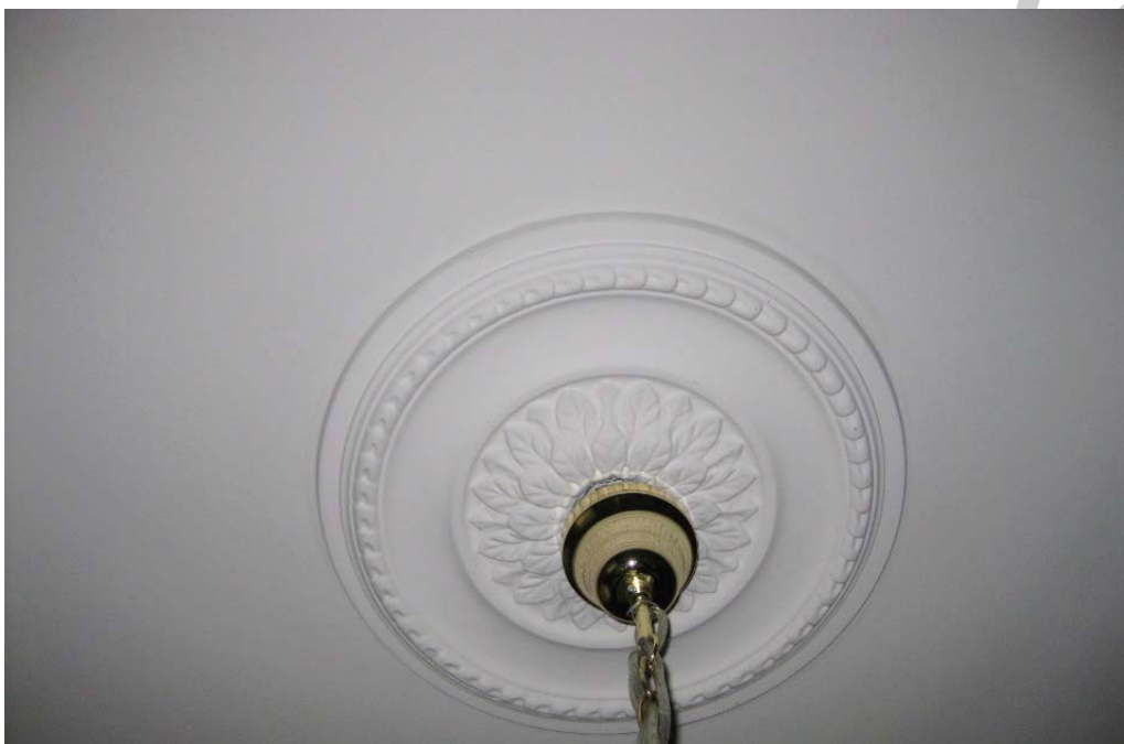
15. ábra. Mennyezetfestés diszperziós belső téri falfestékkel 15
