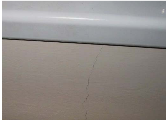
2. ábra. Vakolatrepedés 2
