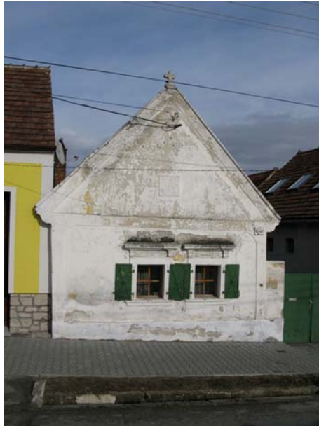
4. Ábra. Fertőrákos, Győr-Moson-Sopron megye – a homlokzaton, az oromfalon látható a mészfesték kopása, de egyelőre vakolatleválás nem látható.
