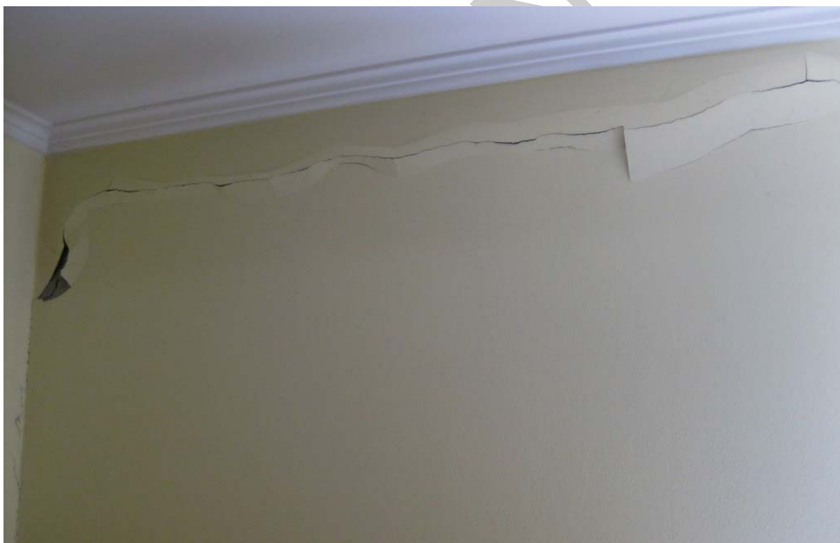
1. ábra. Vakolatrepedés 1
