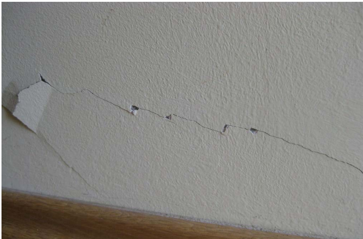
8. ábra. Vakolatrepedések 8
