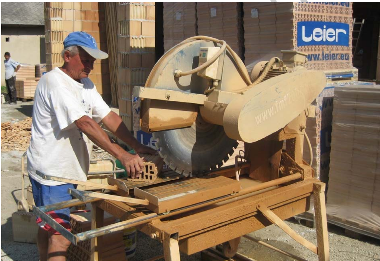
2. ábra. Téglafalépítéshez téglavágógéppel
