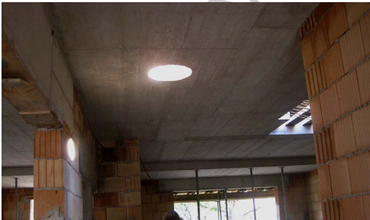
4. ábra. Monolit vasbeton mennyezet, vakolás előtt 4
