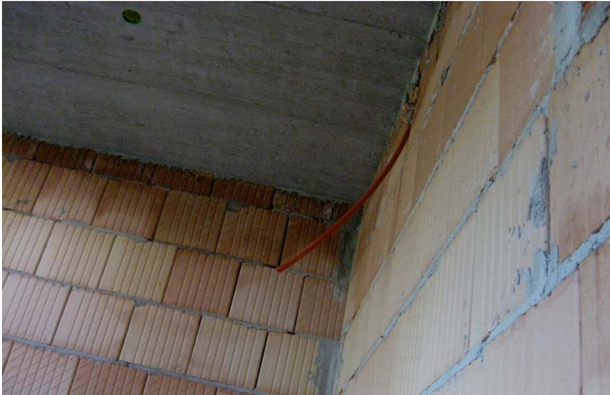
3. ábra. Téglafal és monolit vasbeton födém, vakolás előtt 3
