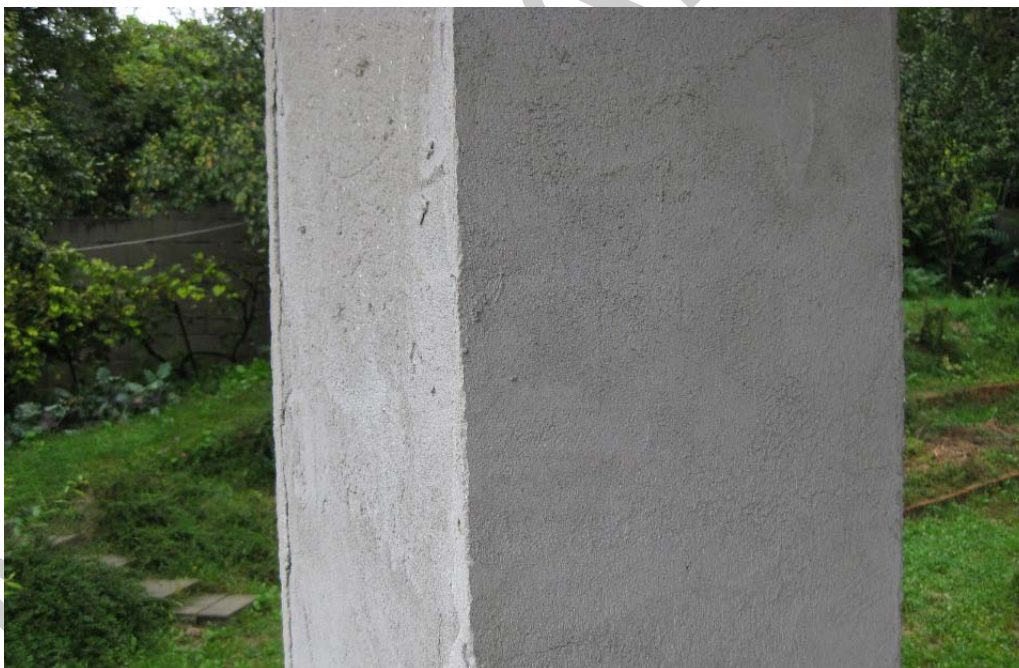
2. ábra. Vakolt terasz pillér 2
