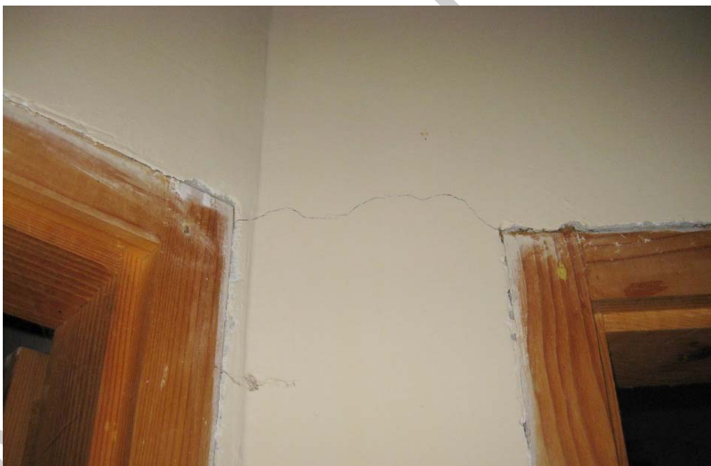
8. ábra. Vakolatrepedés 8
