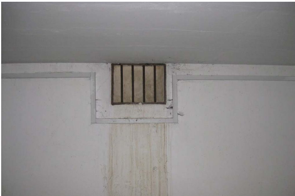
10. ábra. Beázás okozta fal penészesedés 10
