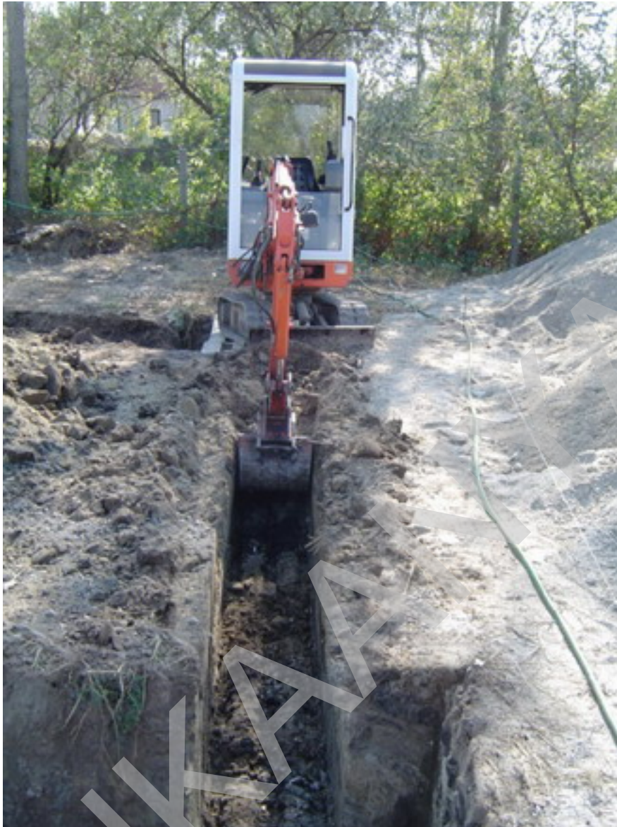
9. kép. Épület alapjának „kimarkolása” 8
