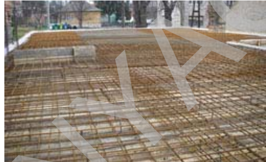
5. -6. kép. Egyedi vasalással tervezett monolit vasbeton födém és zsaluzata és vasalása 5
