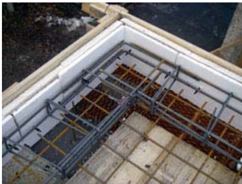
8. kép. A koszorúvasalás valamint a kettős (HERATEKTA + NIKECELL) hőszigetelés látszik a koszorún 7
