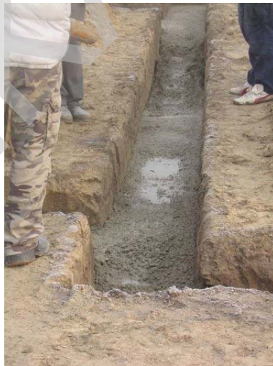
7. kép. Sávalap betonozása 6
