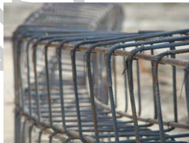
1. ábra Előszerezelt betonacél
