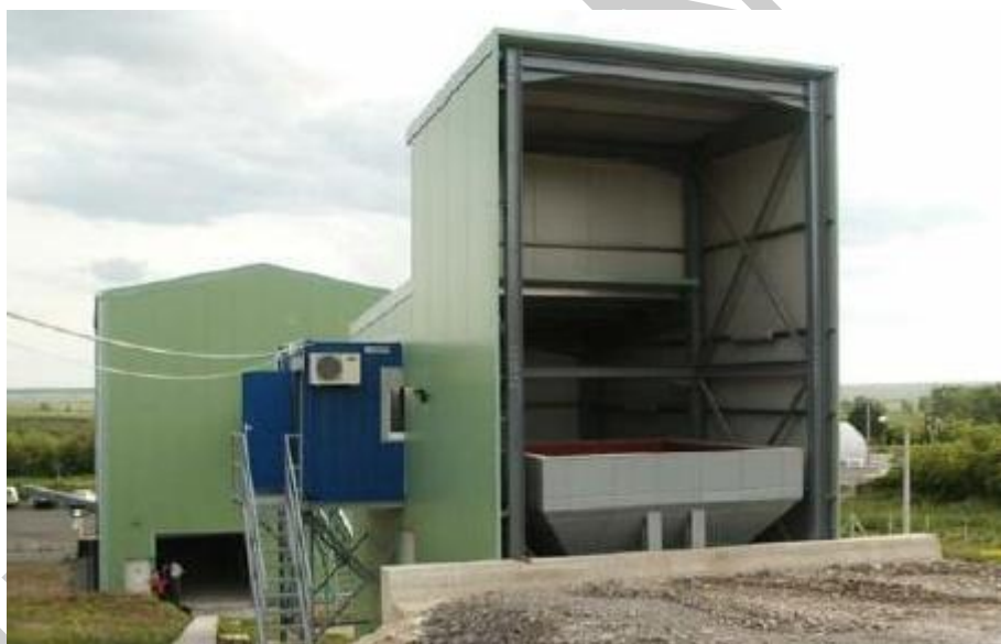
4. ábra. Az építési törmeléket fogadó garat 2
