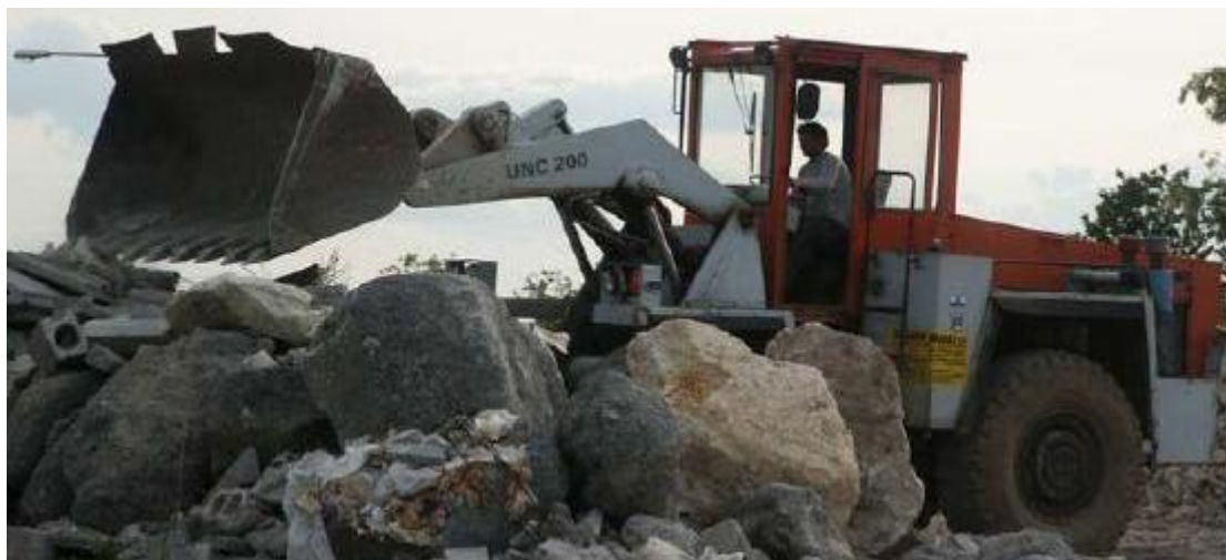
3. ábra. Nagy teljesítményű markológép a nagydarabos építési törmelék mozgatásához 1
