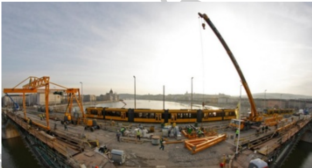
1. ábra. Kivitelezés közterületen (Margit-híd felújítása) 1
