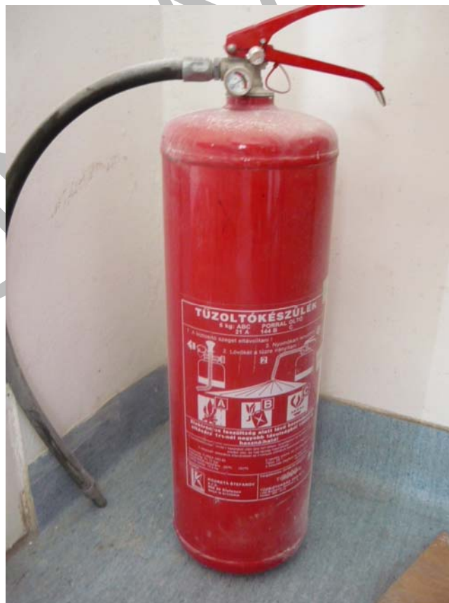
24. ábra. Poroltó készülék a raktárban, könnyen elérhető helyen
