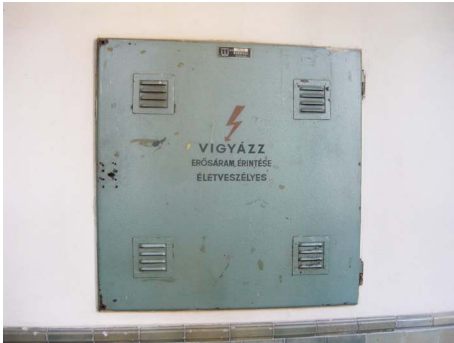
23. ábra. Kapcsolószekrény a raktár folyosóján, szabadon, könnyen megközelíthető helyen
