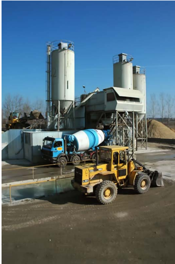
18. ábra. Betonüzem cementsilókkal, keverőegységgel és a frissbeton szállításához adagolóberendezéssel 7
