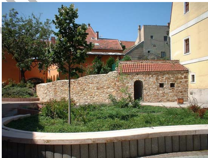
7. ábra. Új építésű durva felületű kőfal műemléki környezetben
