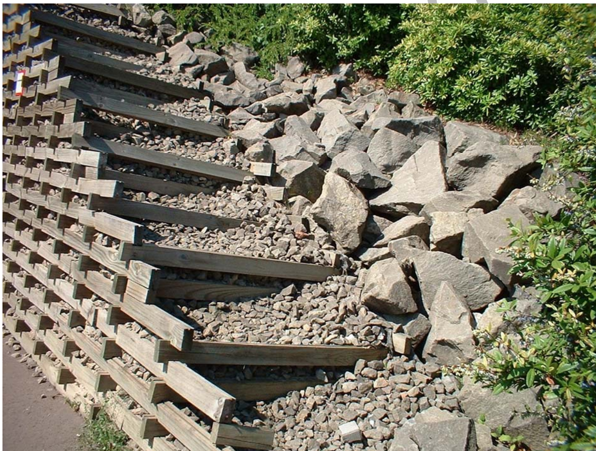
2. ábra. Támfalként működő kőből és gerendákból álló szerkezet
