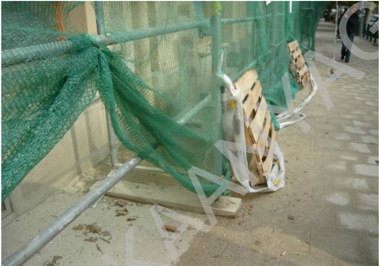
4. ábra Járda használata állványzat építésére, illetve tárolásra
