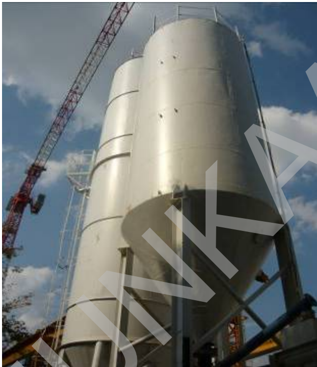
10. ábra Cementsiló nagyberuházás (metróépítés) helyszínén
