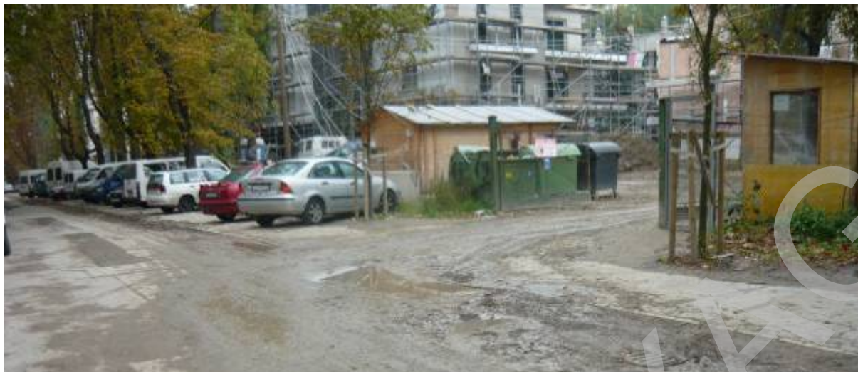
3. ábra Lakóparkhoz vezető út, építés közbeni állapotban
