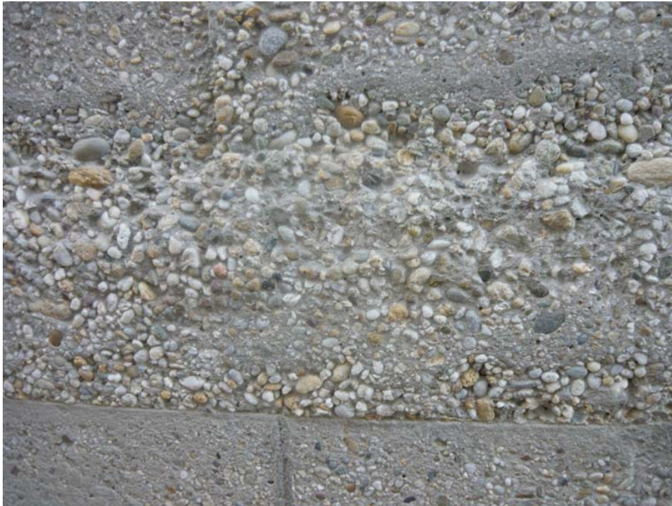
4. ábra. Durva szemcsés betonfelület
