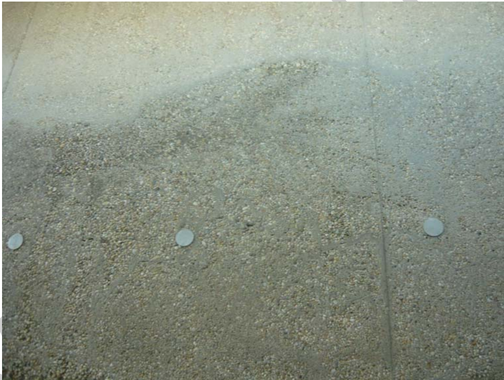
18. ábra. Elszíneződés utókezelési hiányosságokra visszavezethetően
