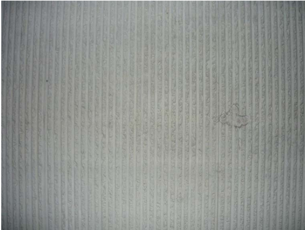
15. ábra. Strukturált betonfelület
