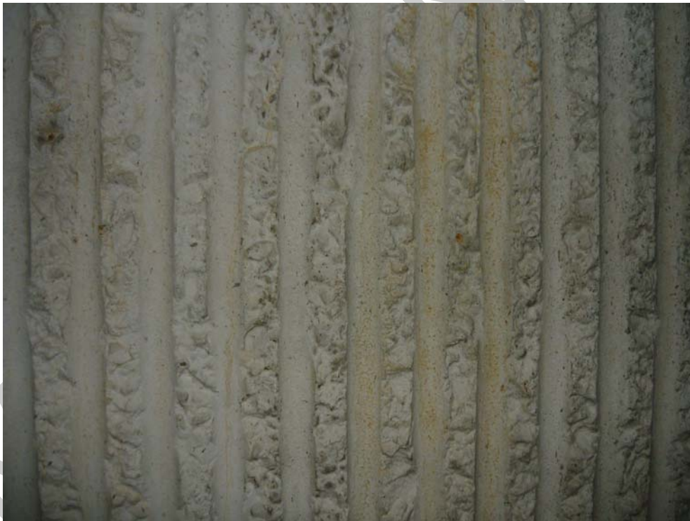
16. ábra. Olajfoltos tagolt látszóbeton-felület
