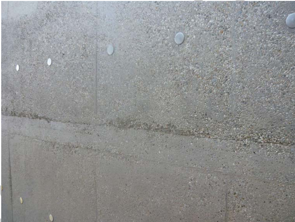
17. ábra. Felületi egyenetlenségek a zsalutáblák illesztésénél
