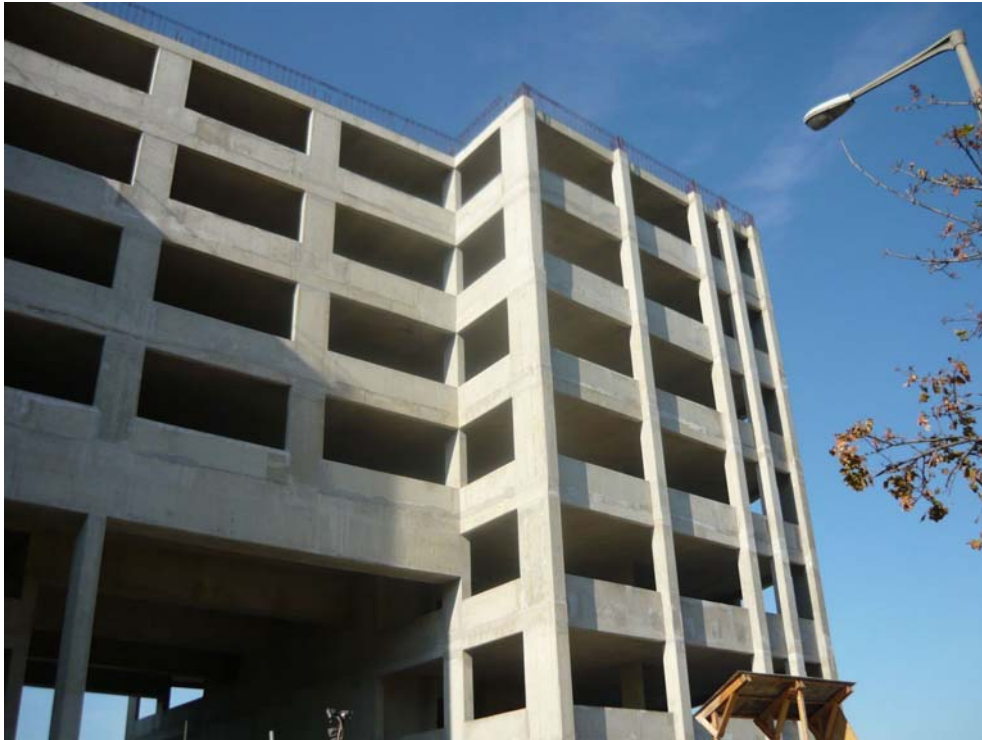
12. ábra. Vasbetonvázás irodaépület, a nyílászárók elhelyezése és külső burkolat készítése előtt
