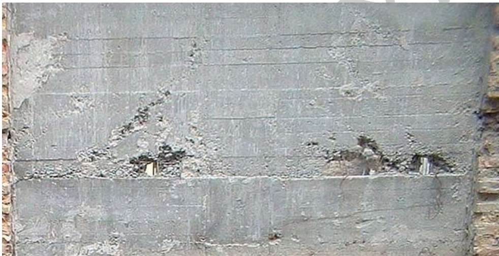
1. ábra. Kizsaluzott fészkes szerkezet
