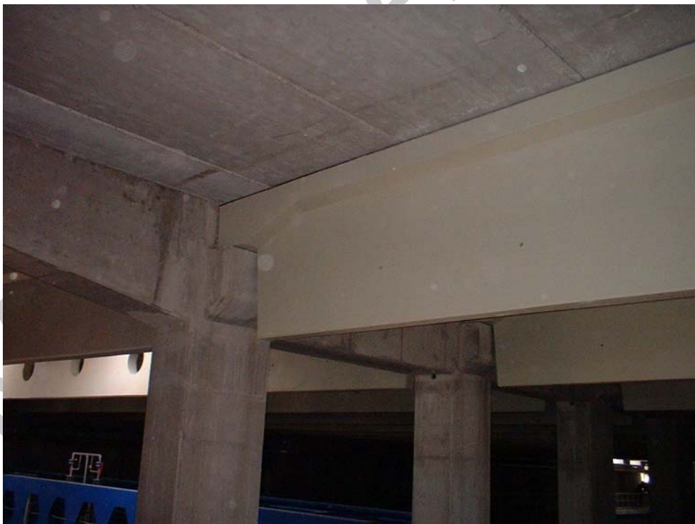
13. ábra. Helyszínen készült, általános igényeket kielégítő vasbeton pillérek, valamint üzemben, fémsablonban gyártott vasbetongerendák felületi megjelenése
