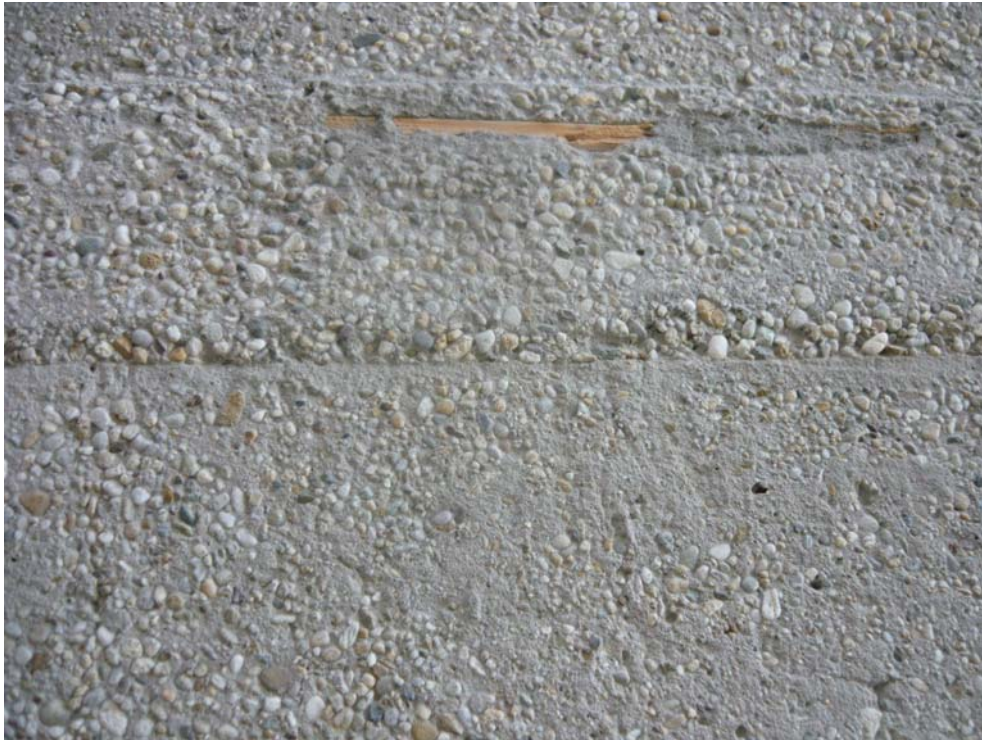
7. ábra. Nagyobb szennyeződés, hulladékdarab a beton felületén
