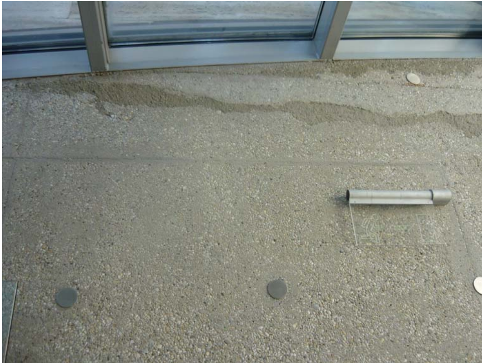
3. ábra. Látszóbeton jelentős színeltéréssel
