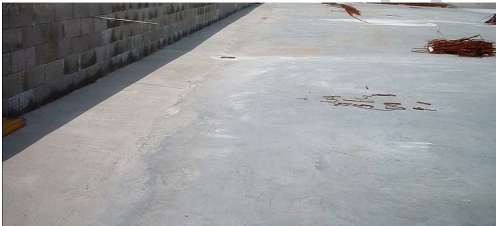
5. ábra. Tetőfödémén betonozott, lejtést adó réteg
