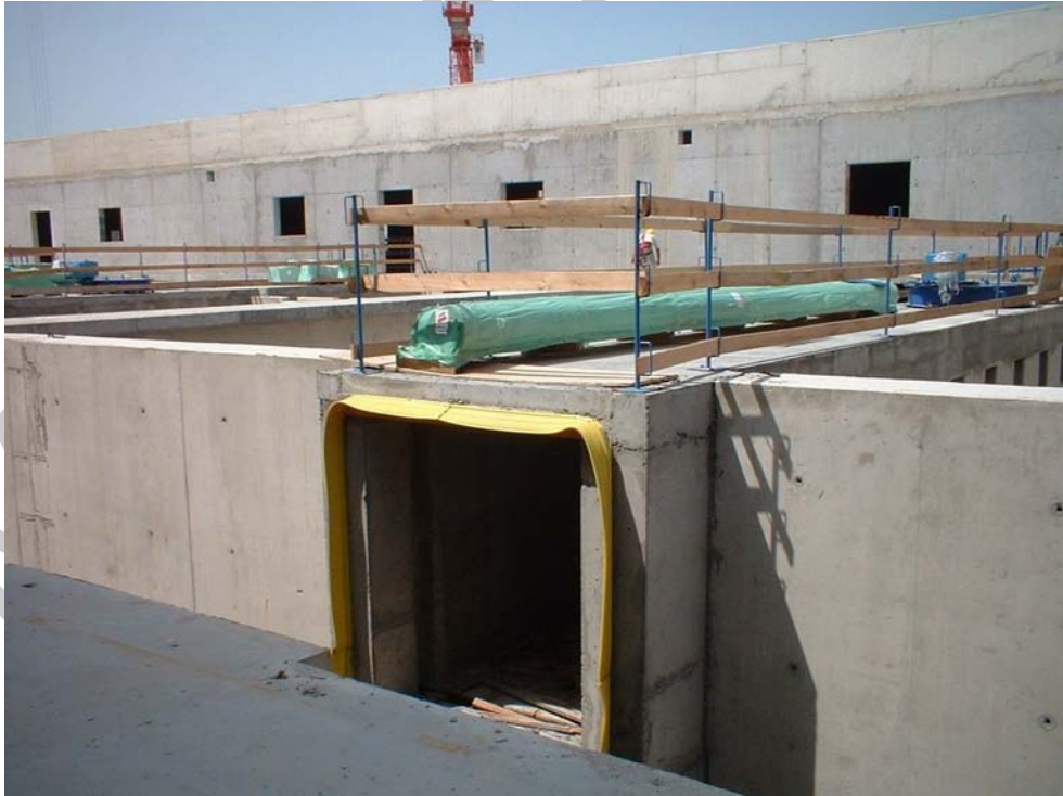
3. ábra. Szerkezetbe beépített munkahézag-szalag
