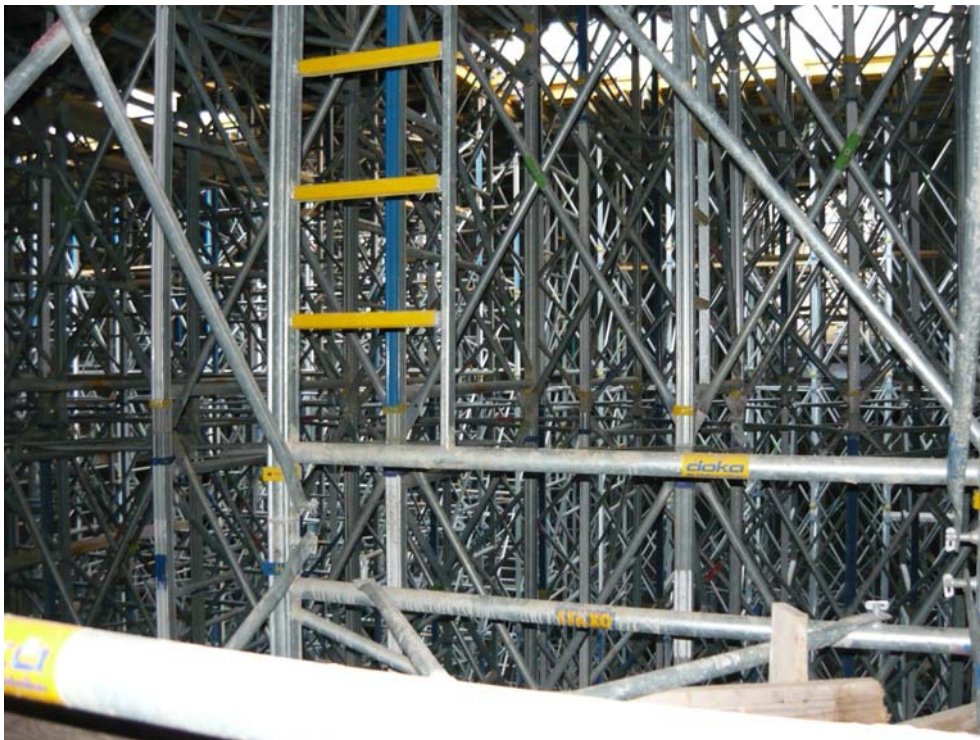
13. ábra. Állványerdő, nagy teherbírású födémmező betonozásához előkészítve
