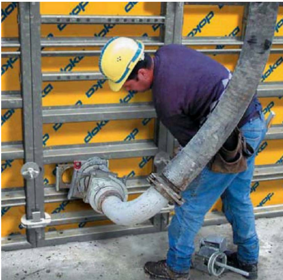
14. ábra. Falzsaluzathoz csatlakoztatott betonpumpa öntömörödő beton alkalmazásához 4
