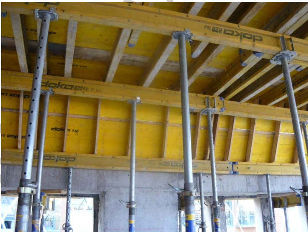
12. ábra. Egy "koporsófödém" zsaluzata a függőleges földémtámaszokkal és a támaszok tetején lévő fejjel, amelynek villás kiképzése a fatartót közrefogja, így rögzíti annak pontos helyét
