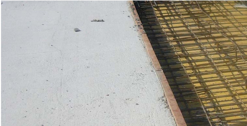
3. ábra. Betonozott és betonozás előtti födémmező
