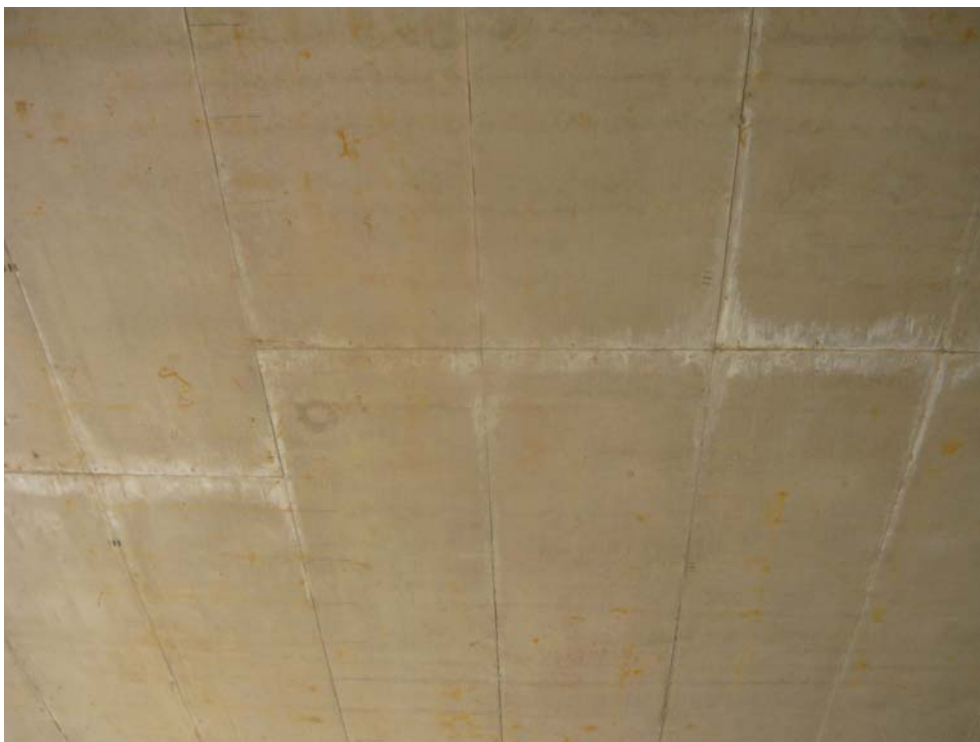
4. ábra. Gondosan kezelt és illesztett zsalutáblákkal készített vasbeton födém alsó felülete
