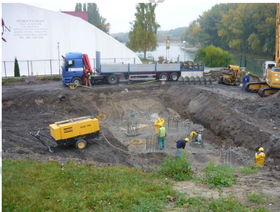
2. ábra. Vasbeton cölöpökből kiálló vasalások, a cölöpöket összefogó cölöprács betonozása előtt
