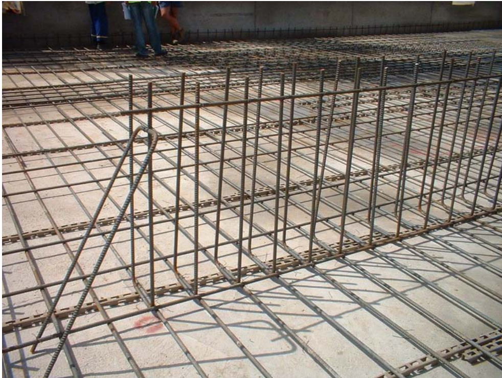
3. ábra. Vasbeton alaplemez vasalása
