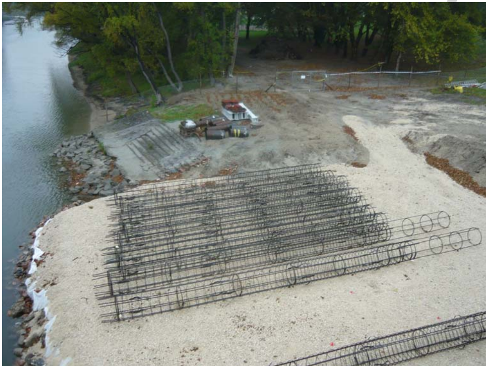
8. ábra. Összeállított cölöpvasalás, azonosító jelzésekkel ellátva
