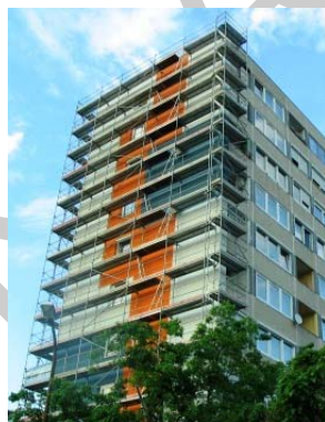
6. ábra. Többszintes lakóépület hőszigetelése
