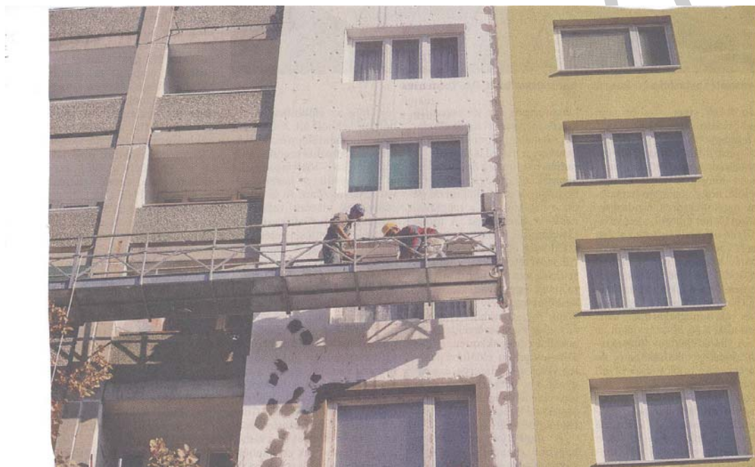
8. ábra. Paneles épület homlokzatszigetelése
