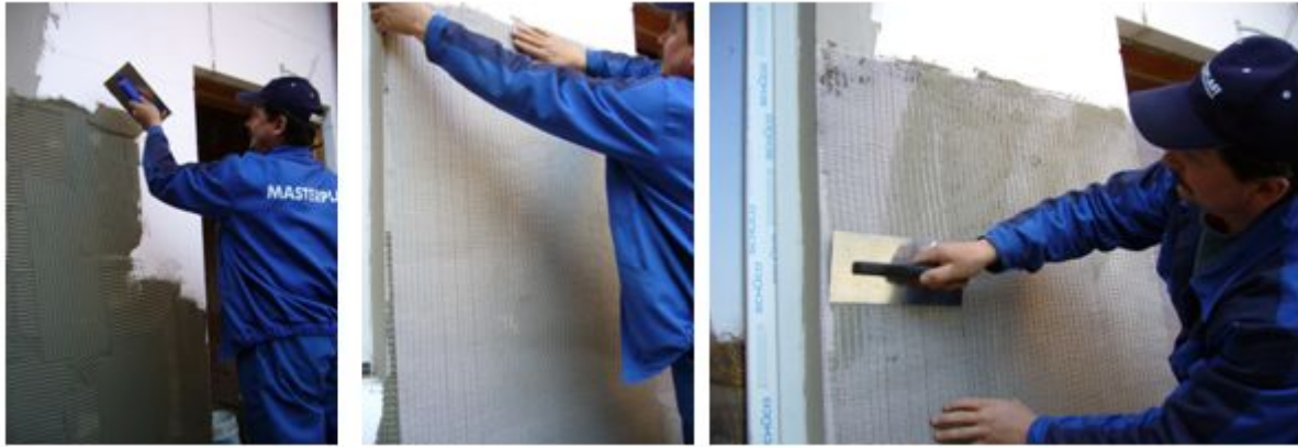
19. ábra Üvegszövet beágyazásának lépései
