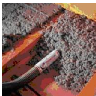
77. ábra Kézi erővel bejuttatott szigetelő anyag gerendák közé.
