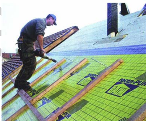
46. ábra Szarufák feletti hőszigetelés kivitelezése.
