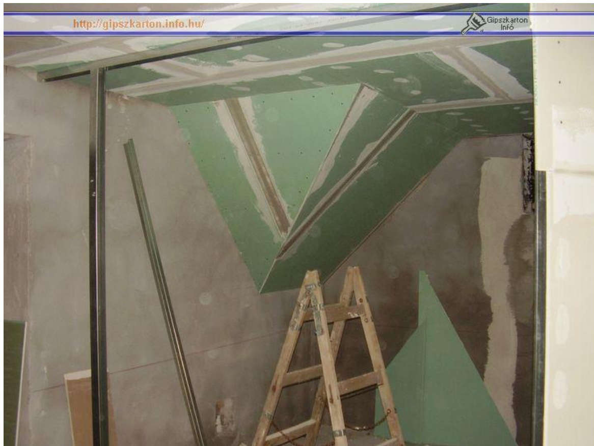
89. ábra Kész gipszkartonozott tetőtér.
