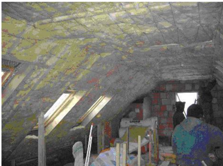
86. ábra Utólagos tetőtér szigetelés
