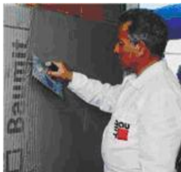
70. ábra Ragasztótapas felhordása.
