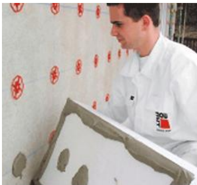
68. ábra A lemezek rögzítése dűbellel.
