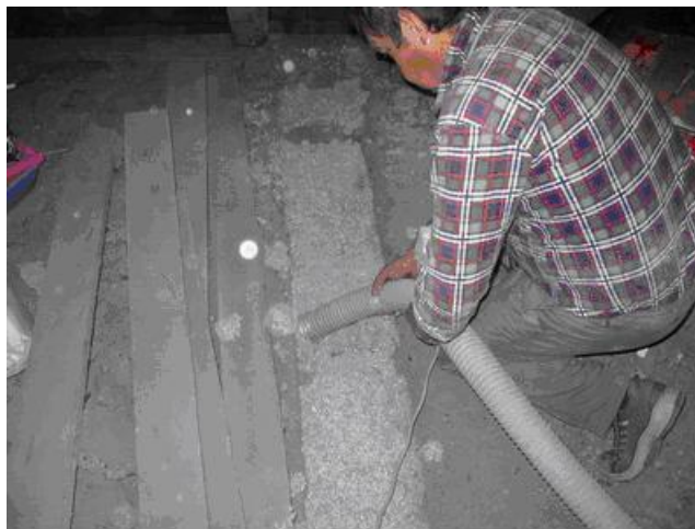
76. ábra A födém üregeinek kitöltése.
