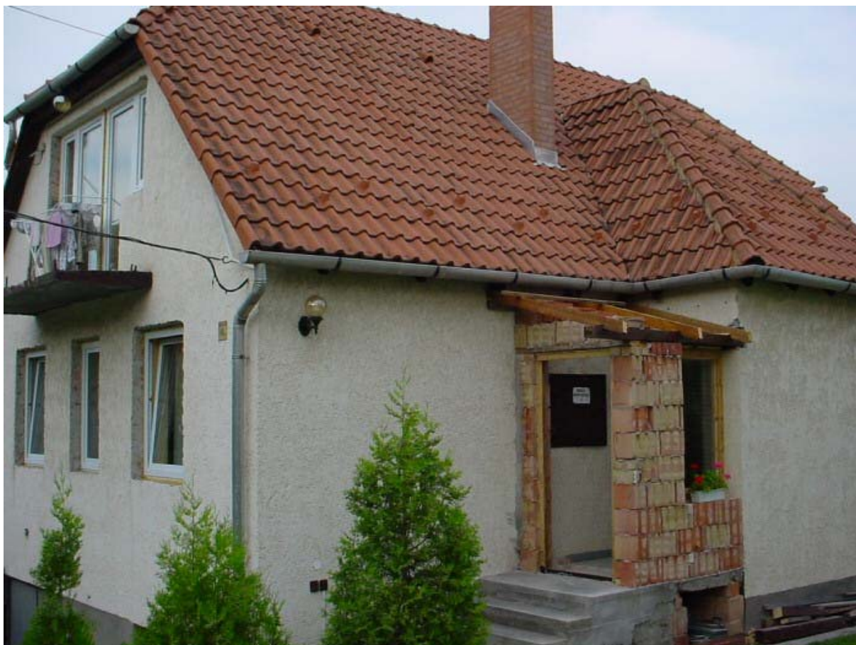
57. ábra Az épület hőszigetelés előtt
