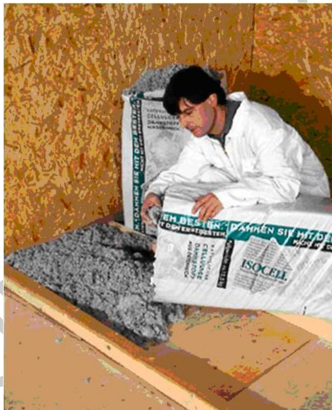
77. ábra Kézi erővel bejuttatott szigetelő anyag gerendák közé.
