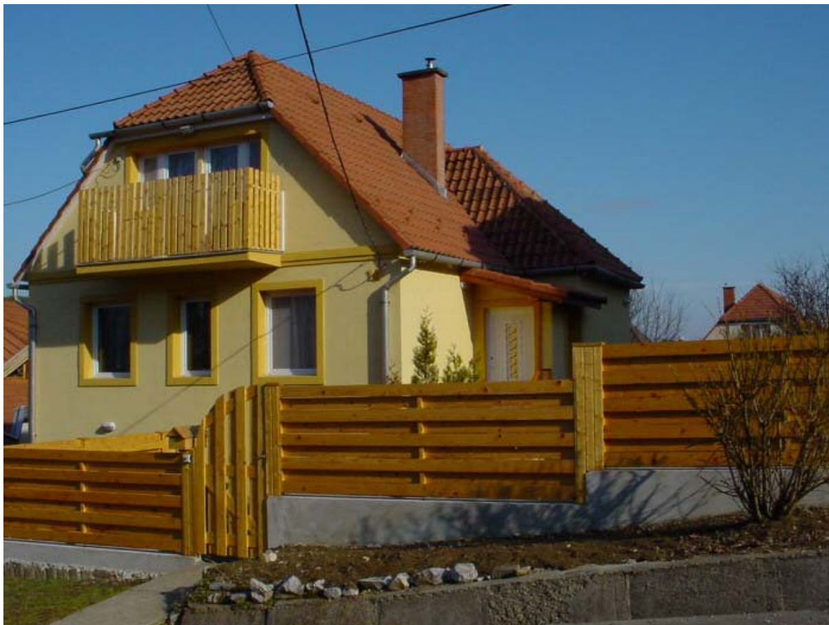
58. ábra Homlokzat hőszigetelés után.
