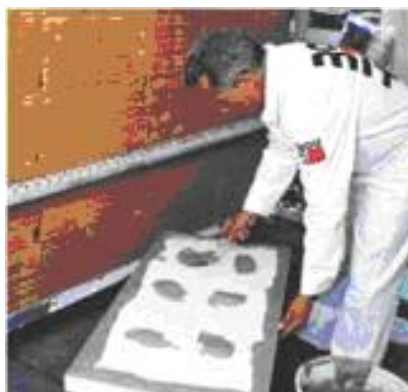
66. ábra Ragasztóanyag felhordása a szigetelő táblára
