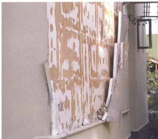
21. ábra Rosszul felragasztott, rögzített szigetelőtábla következménye.10
