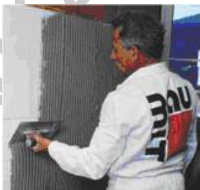
70. ábra Ragasztótapas felhordása.
