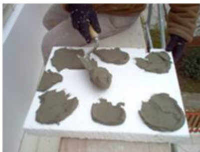
17. ábra Táblák előkészítése ragasztásra
