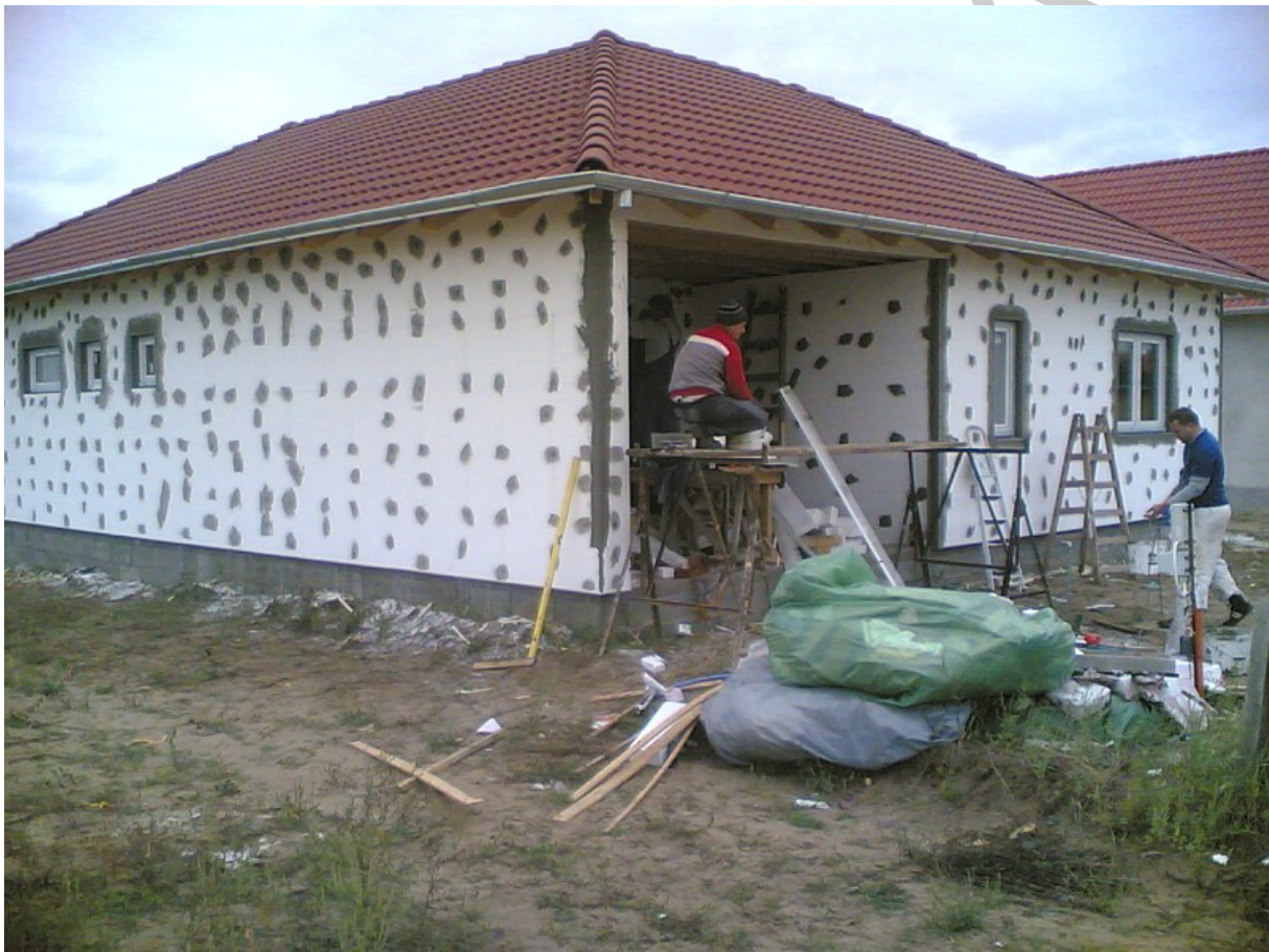
20. ábra Hőszigetelés kivitelezés közben.
