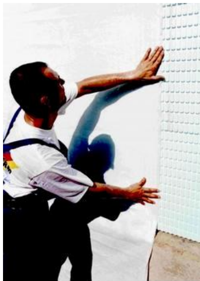
54. ábra Pincefal szigetelése.
