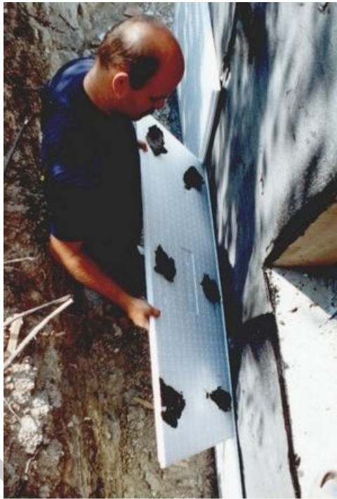
54. ábra Pincefal szigetelése.
