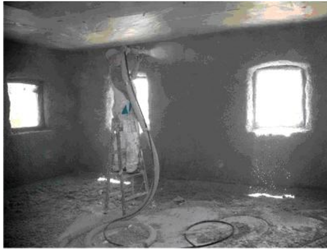
74. ábra Szigetelő anyag felfújása a felületre.
