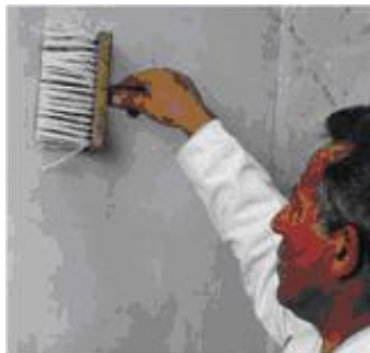
72. ábra Alapozó felhordása.
