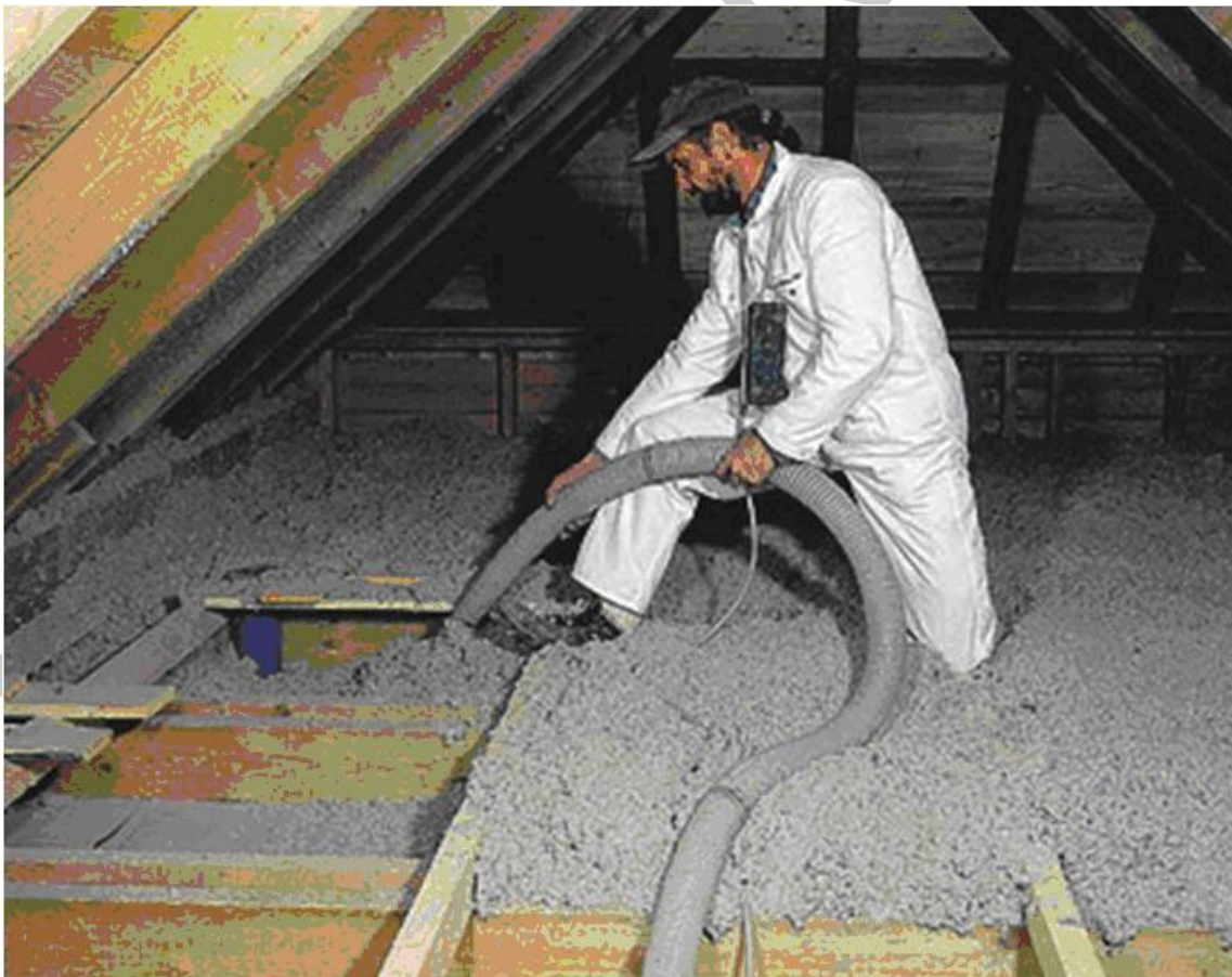
75. ábra Padlásfödém utólagos szigetelése a födémgerendák közé befúvatott szigetelőanyaggal.
