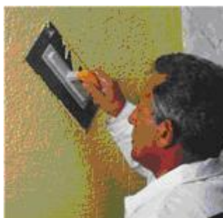
73. ábra Vakolat felhordása a felület végleges megjelenítése14
