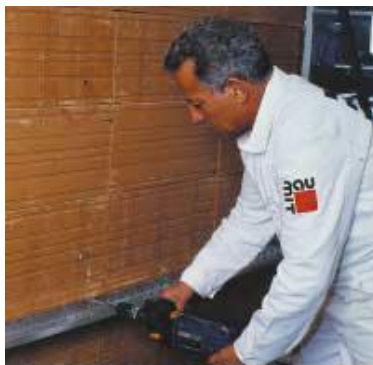
65. ábra Indítóprofil elhelyezése a lábazat fölött.
