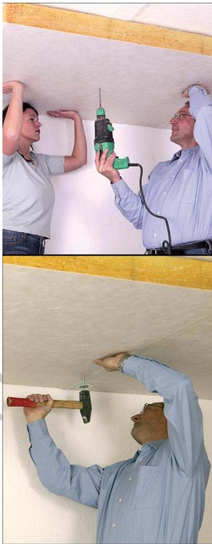
53. ábra A födém alsó síkjára helyezett hőszigetelése építés közben.
