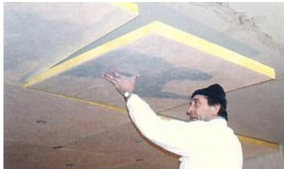
52. ábra Hőszigetelés a pincefödém alsó síkjára helyezve.
