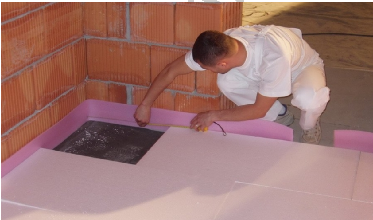
50. ábra Padlószigetelés kivitelezése.
