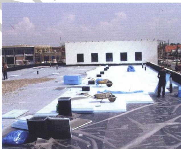
29. ábra Kivitelezési folyamat a fordított rétegrendű tetőnél.
