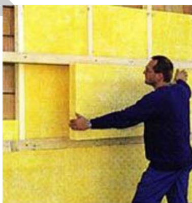
41. ábra. Hőszigetelés beszorítása lécváz közé 41
