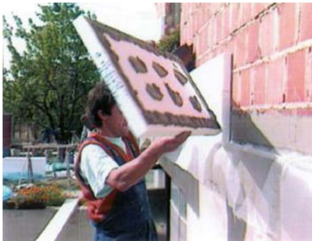
42.ábra. Hőszigetelés rögzítése ragasztással 42
