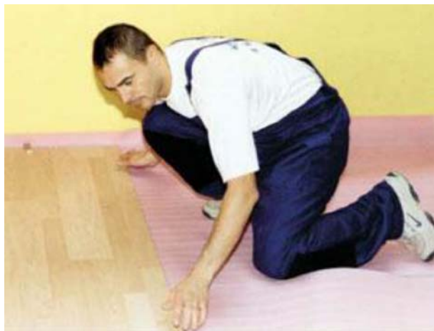
39. ábra. Padló szerkezet úsztató rétege 39
