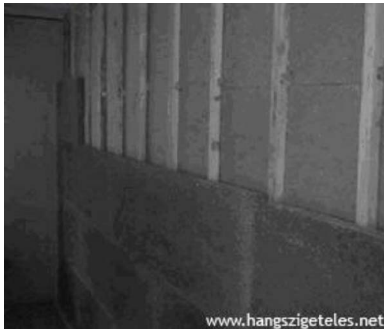
9.ábra. Lakásválasztó fal utólagos hangszigetelése 9
