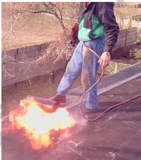
1. ábra. Lapostető szigetelése
