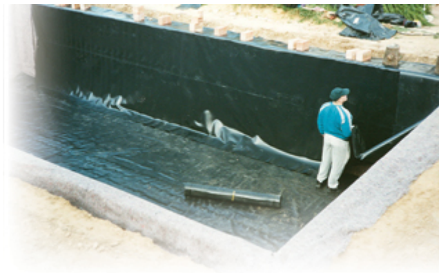
30. ábra A tekő szigetelés ellenőrzése munka közben
