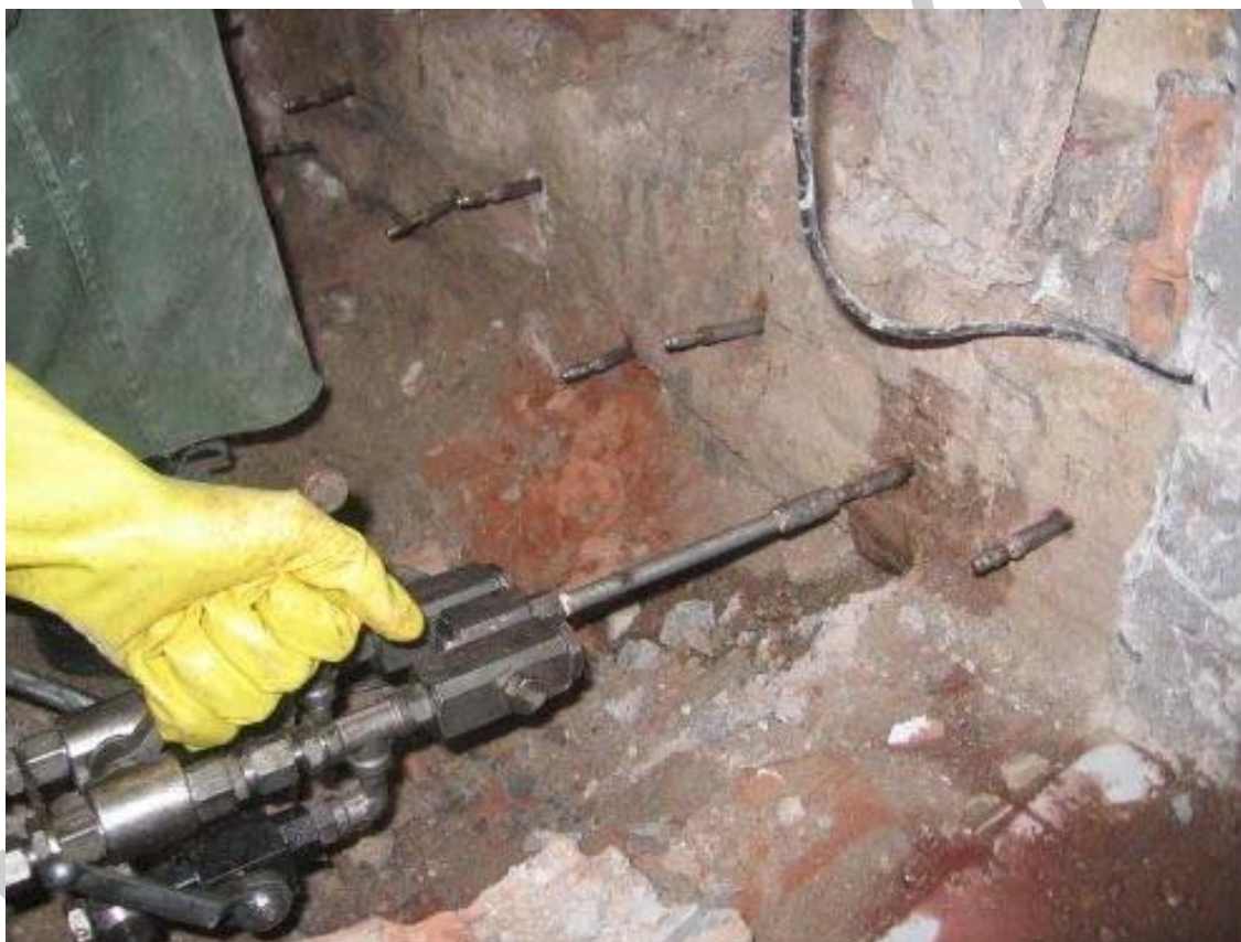
50. ábra Falszigetelés injektálással.
