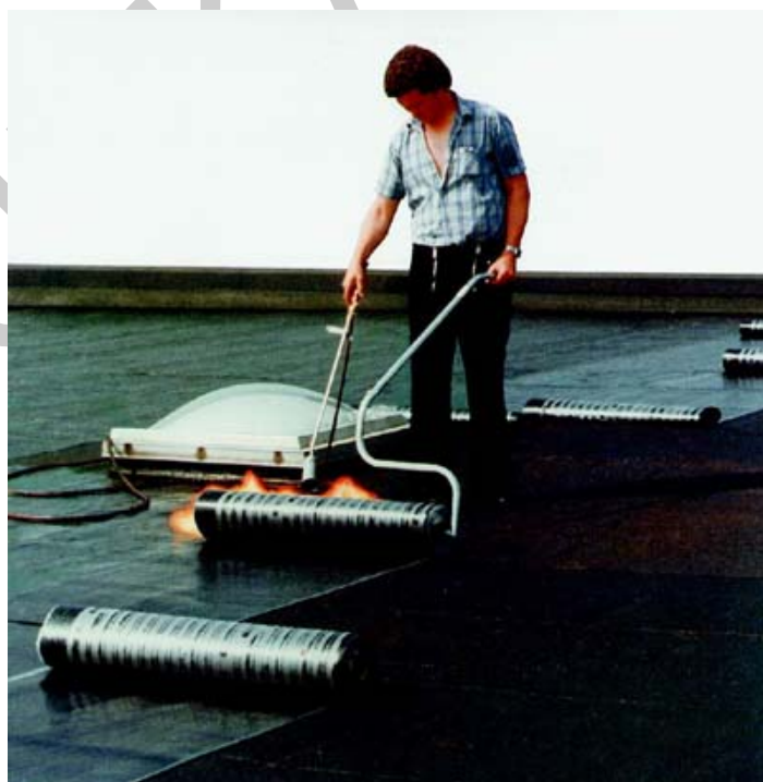
42. ábra Bitumenes vastaglemez fektetése vízszintes felületen.
