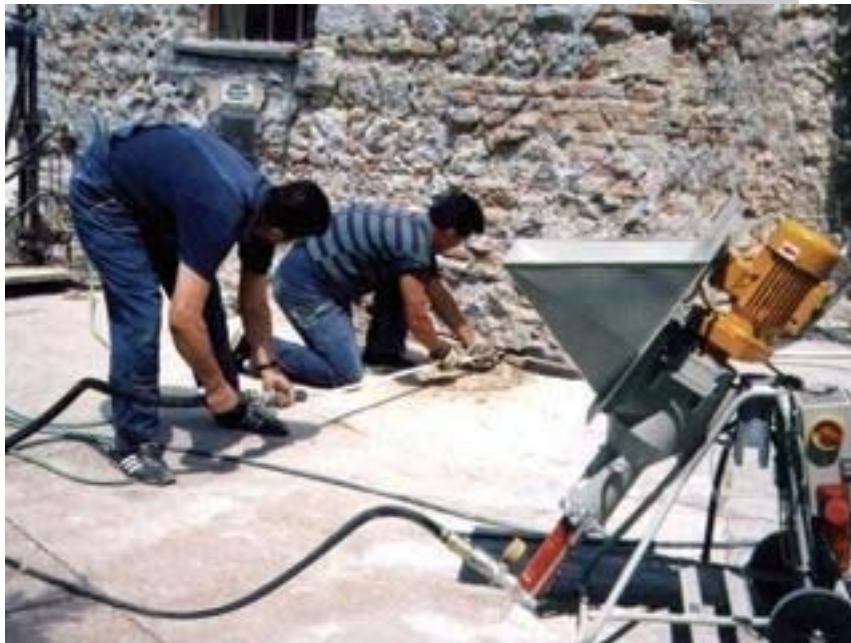
49. ábra Injektálás padló és fal szigetelése estén
