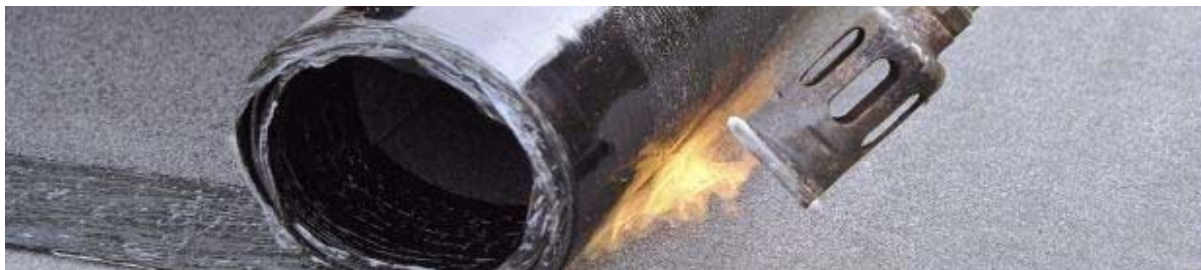
41. ábra Hegesztés készítése.
