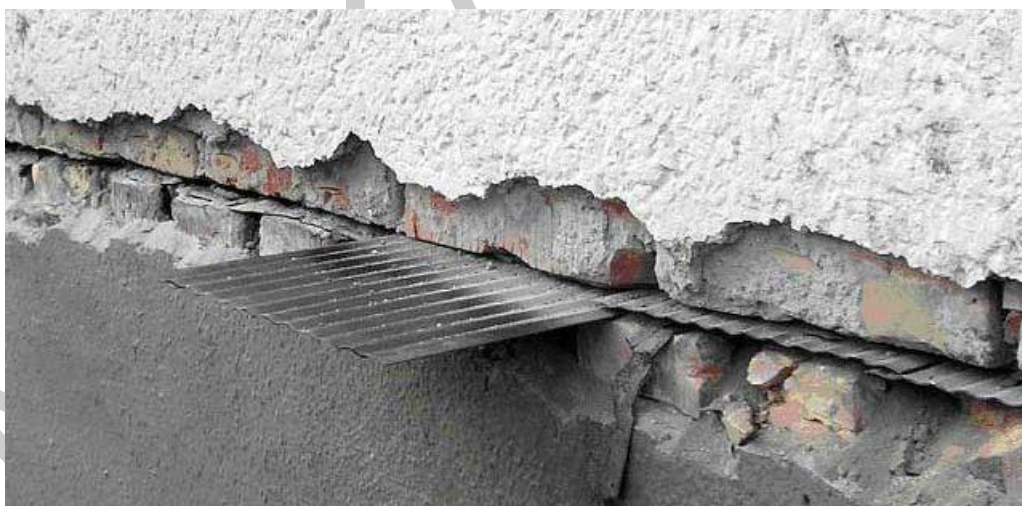
52. ábra Utólagos szigetelés, szigetelő lemez behelyezésével
