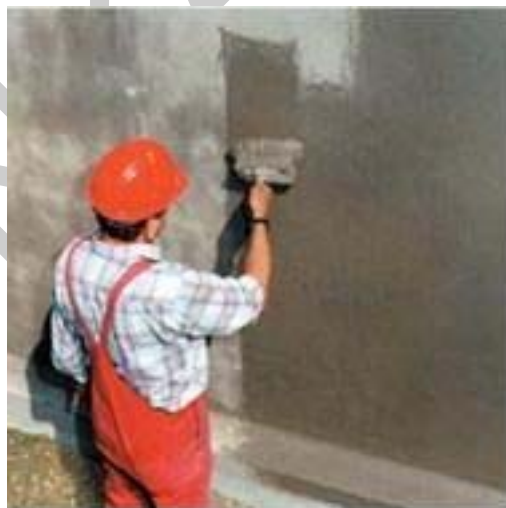
33. ábra Cementbázisú kent szigetelés felhordása
