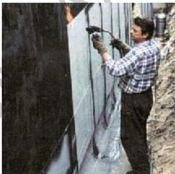
43. ábra Bitumenes vastaglemez fektetése függőleges felületen.
