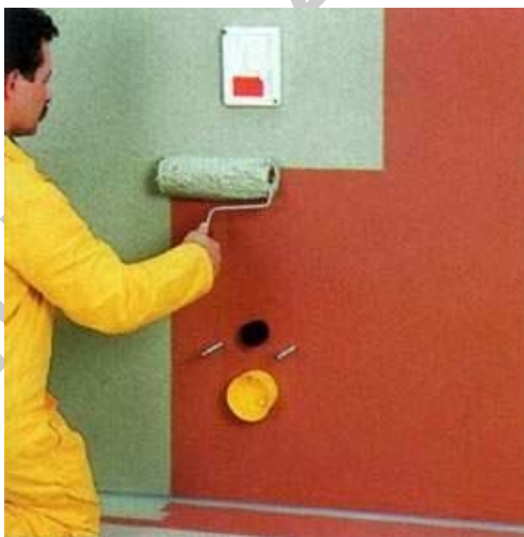
31. ábra Mázas szigetelés felhordása a fal felületére.
