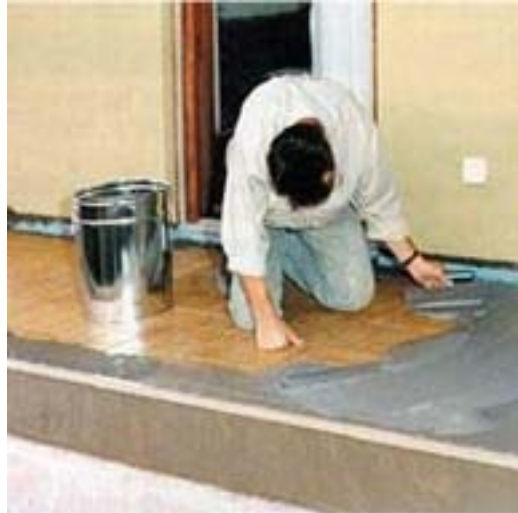
34. ábra Kent szigetelés felújításnál.
