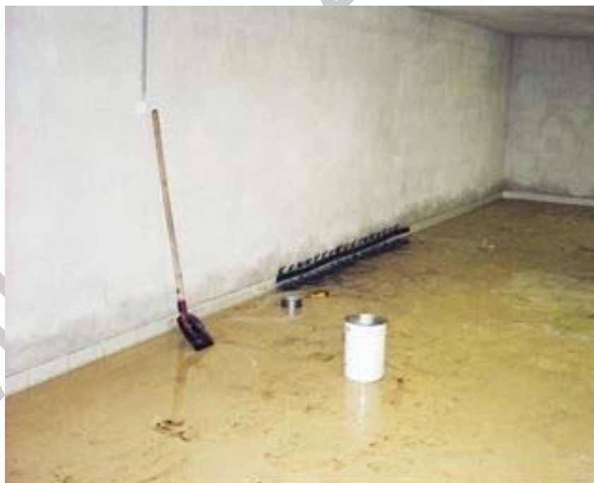
48. ábra Belső oldali szigetelés
