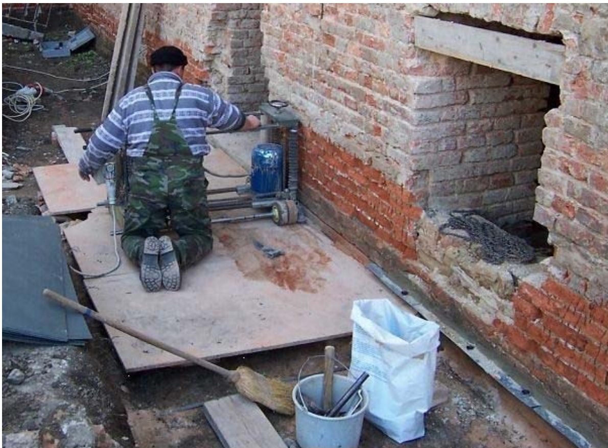
51. ábra Utólagos szigetelés előtti falbontás.
