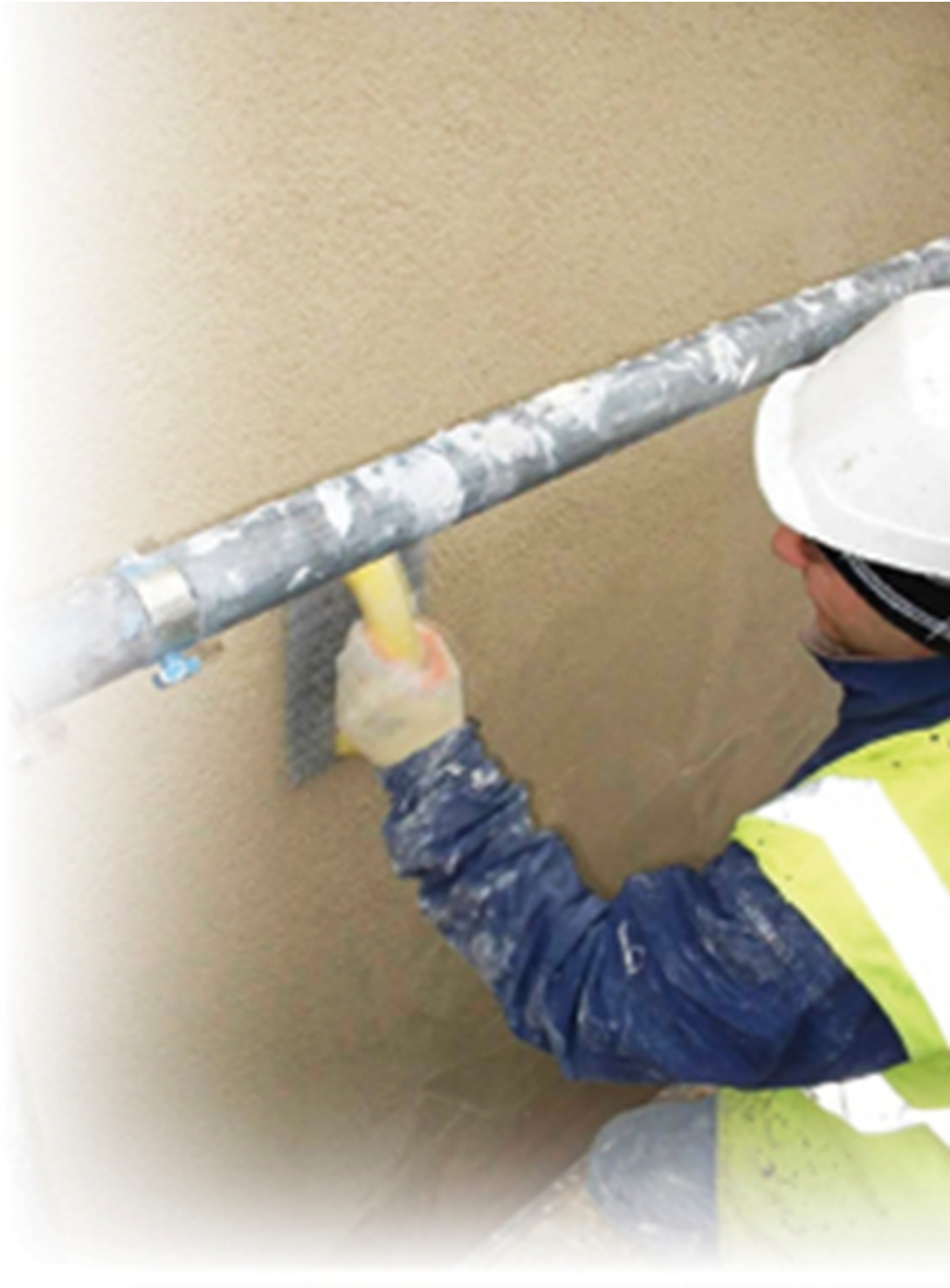
29. ábra Vakolatszigetelés külső felületen
