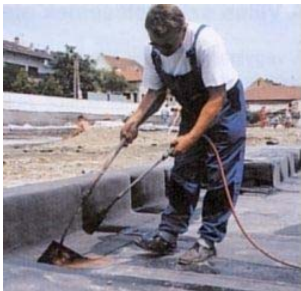
41. ábra Hegesztés készítése.
