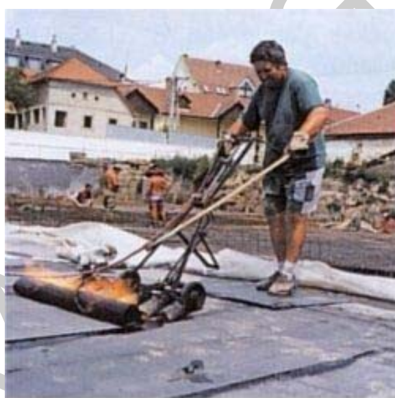
41. ábra Hegesztés készítése.
