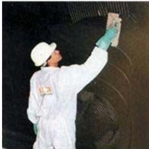
32. ábra Szigetelő máz felhordása belső felületre
