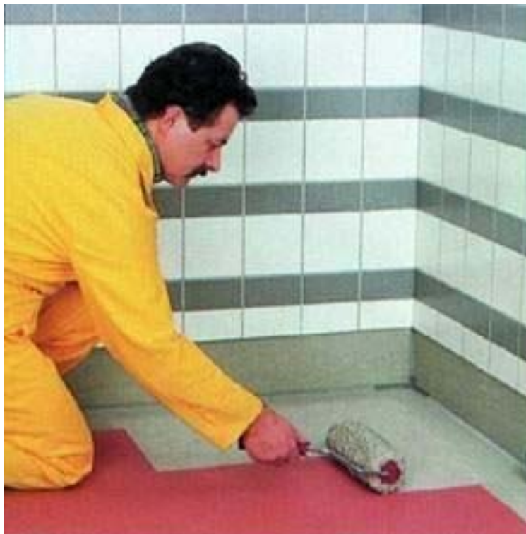
30. ábra Szigetelés felhordása az aljzatra.
