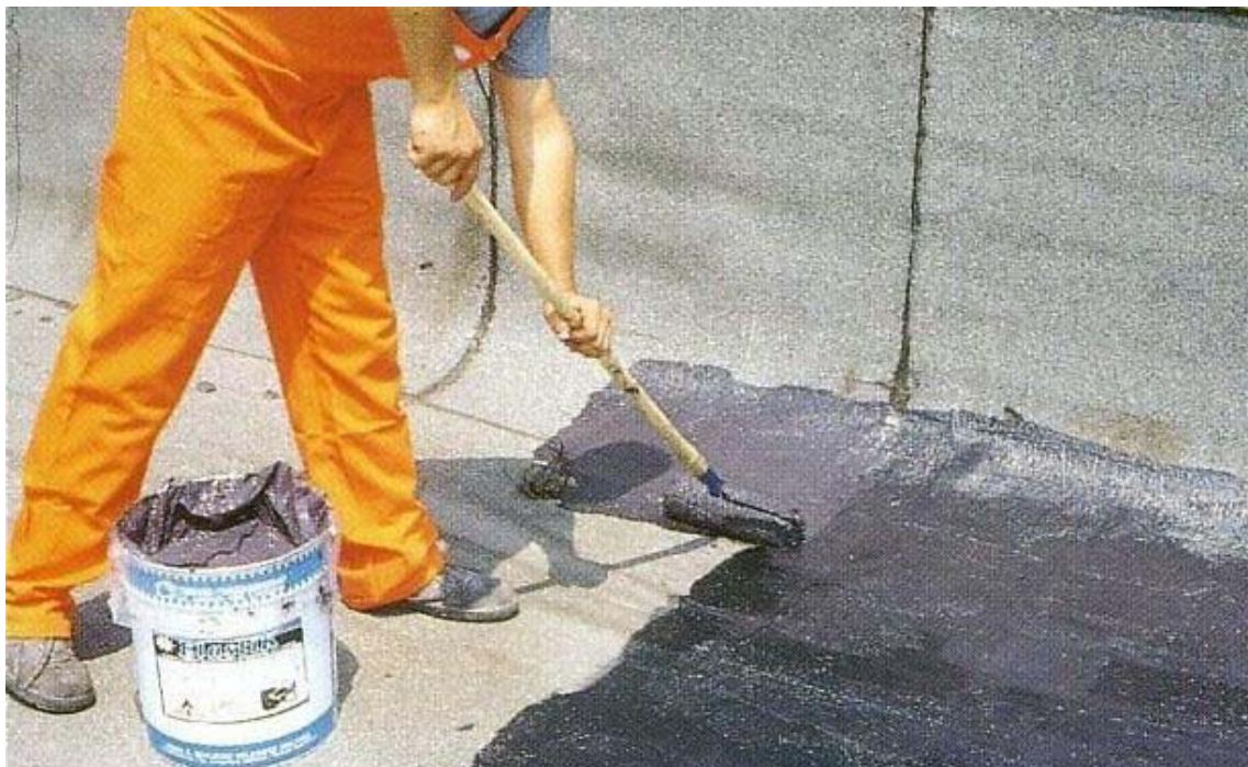
27. ábra Kent szigetelés készítése, máz felhordása hengerrel
