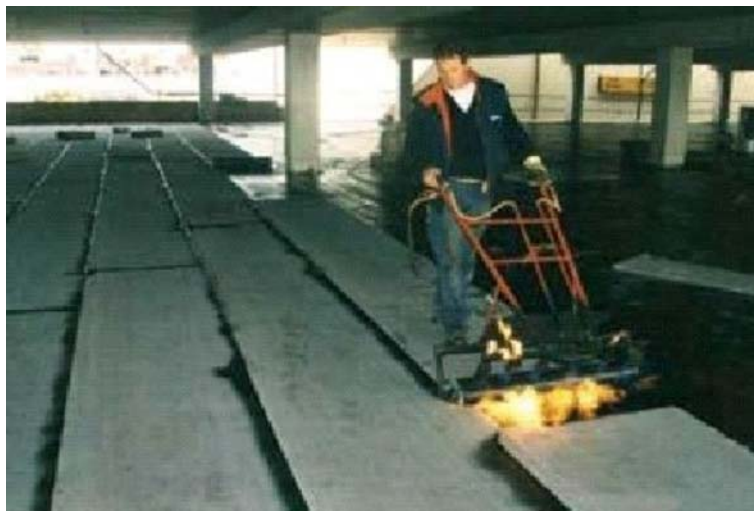
18.ábra. Szigetelőlemez fektetése többfűvókás lángolvasztóval 18
