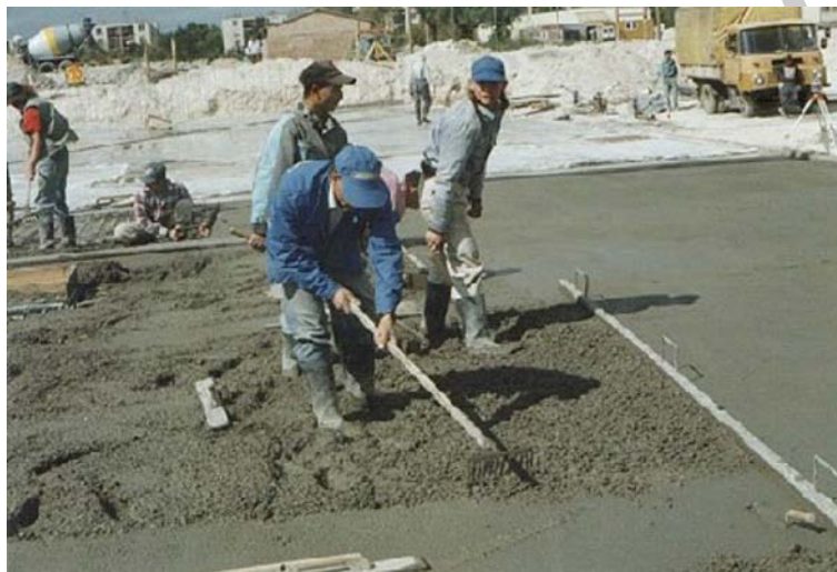
10. ábra. Építési nedvesség 10
