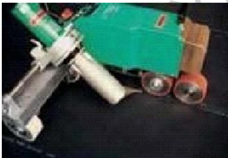
32. ábra. Műanyag szigetelőlemez hegesztése hegesztő autómátával 32
