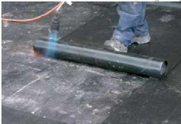
16.ábra. Lángolvasztásos ragasztás 16
