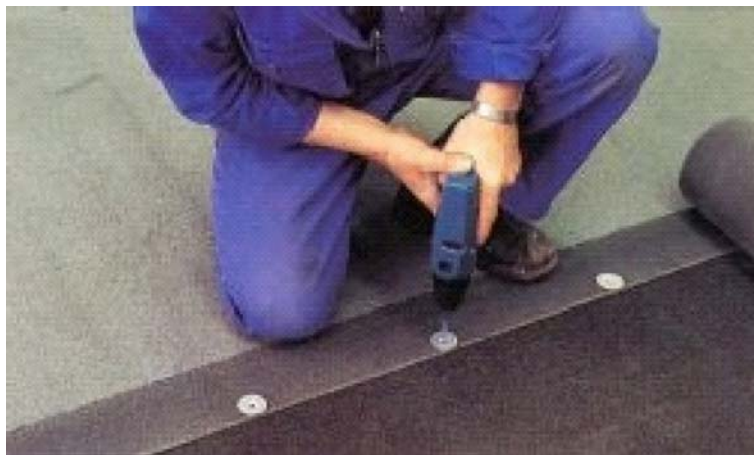
28.ábra. Sávyszerű mechanikai rögzítés 28
