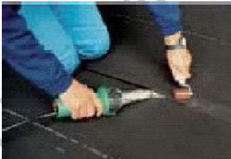
30.ábra. Műanyag szigetelőlemez oldószeres hegesztése 30
