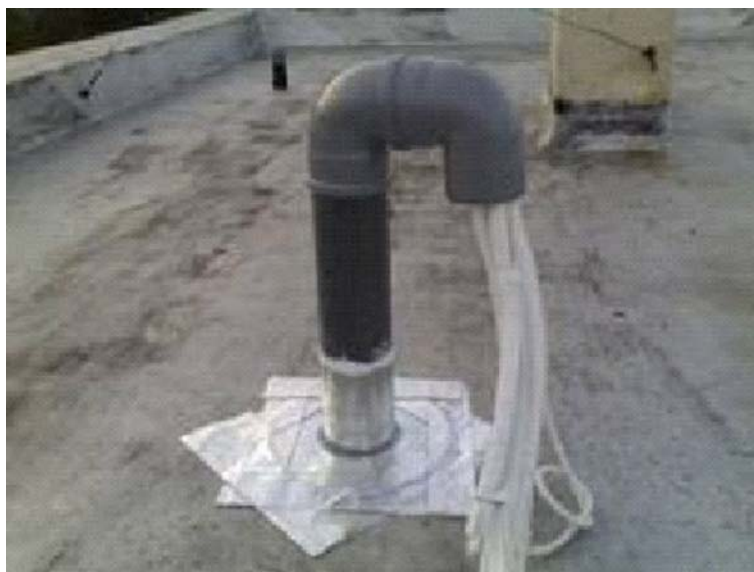
58.ábra. Csőátvezetés tetőn 46
