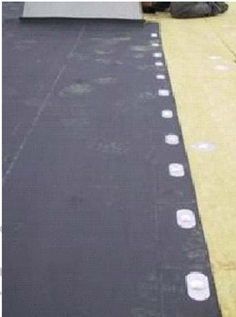
27.ábra Pontonkénti mechanikai rögzítés 27
