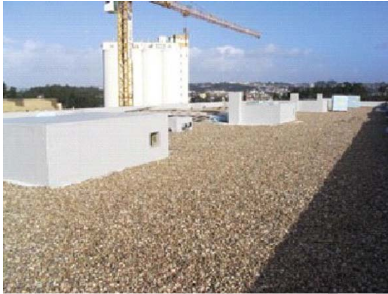
23.ábra. Kavics leterhelő réteg 23
