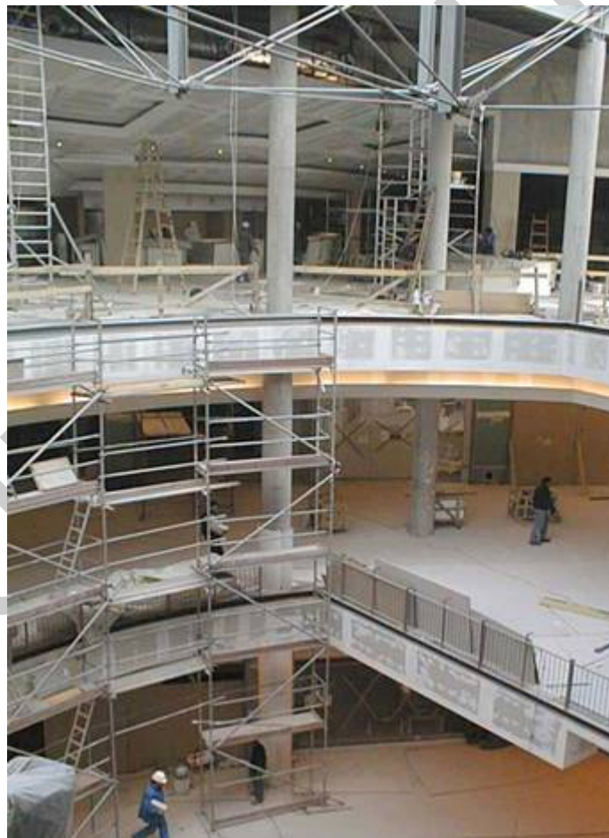
7. ábra. Építkezés egy több tűzszakaszra osztott épületben 4
