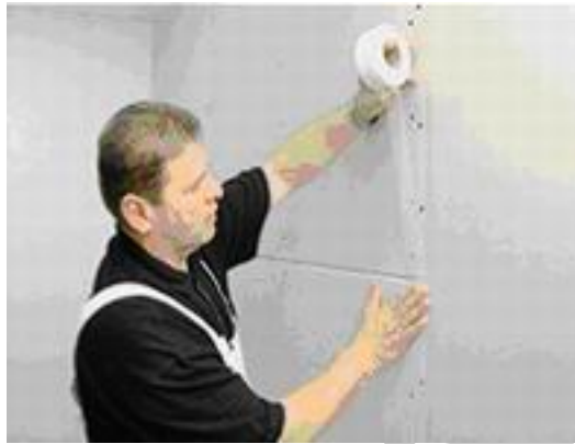
3. ábra. Az öntapadó szalag felragasztása
