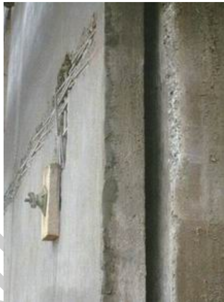
8. ábra. Vasbeton falszerkezetek között kialakított dilatációs hézag 5
