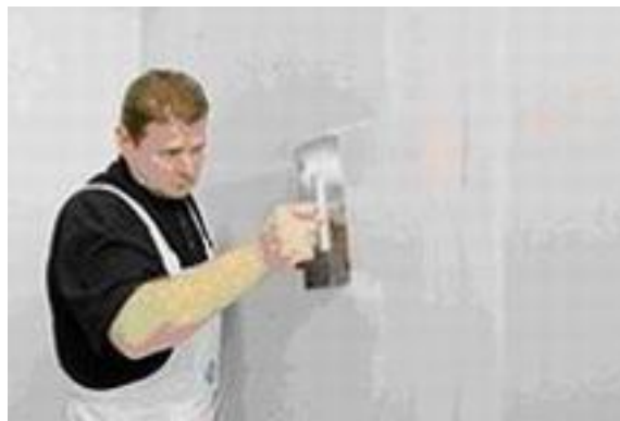
5. ábra. A hézagolóanyag szétterítése és elsimítása
