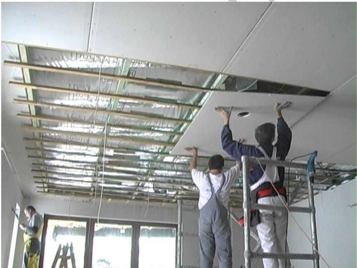
1. ábra. Gipszkarton-álmennyezet szerelése 1
