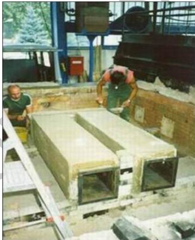
13. ábra. Légcsatorna szerelés 8
