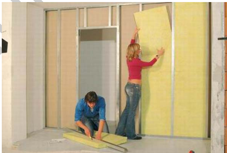
23. ábra. Ásványgyapot elhelyezése 17
