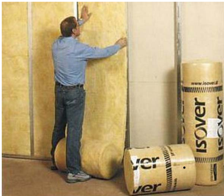
10. ábra. Ásványgyapot elhelyezése 8
