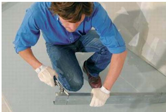
9. ábra. Összekötő-elem bevágása 7
