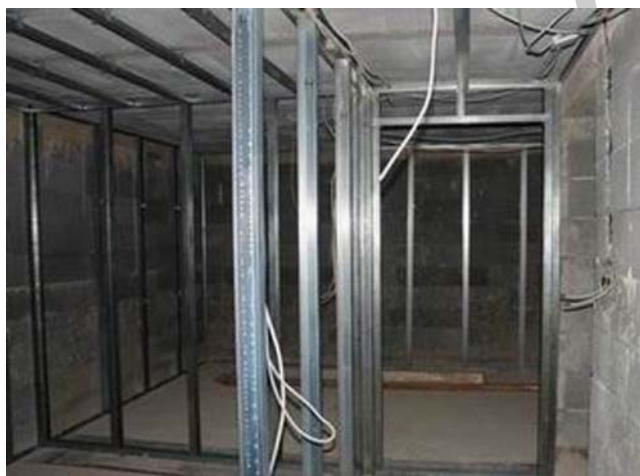
32. ábra Tartóváz szerelése 22
