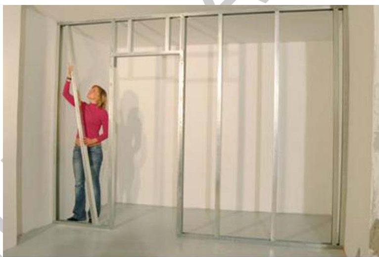
21. ábra. CW profilok elhelyezése 17
