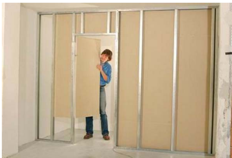
22. ábra. Egyik oldal borítása 17
