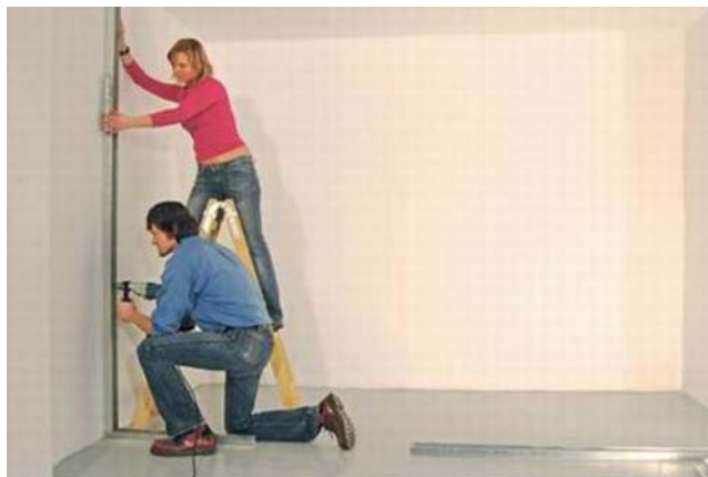
20. ábra. CW profilok rögzítése 17
