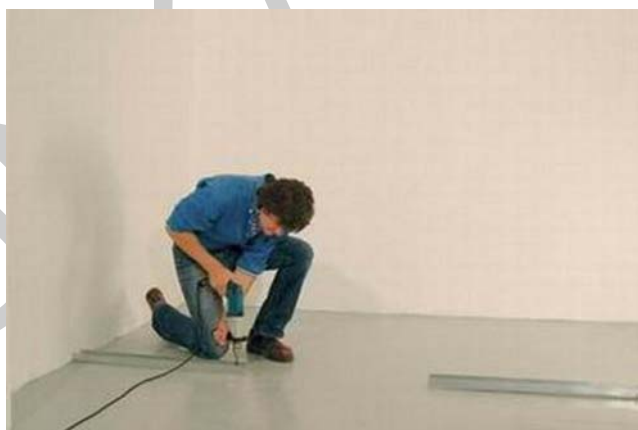
19. ábra. UW profilok rögzítése 17
