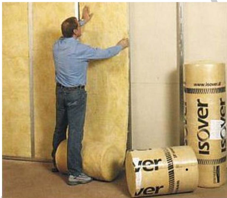
30. ábra. Ásványgyapot elhelyezése 20
