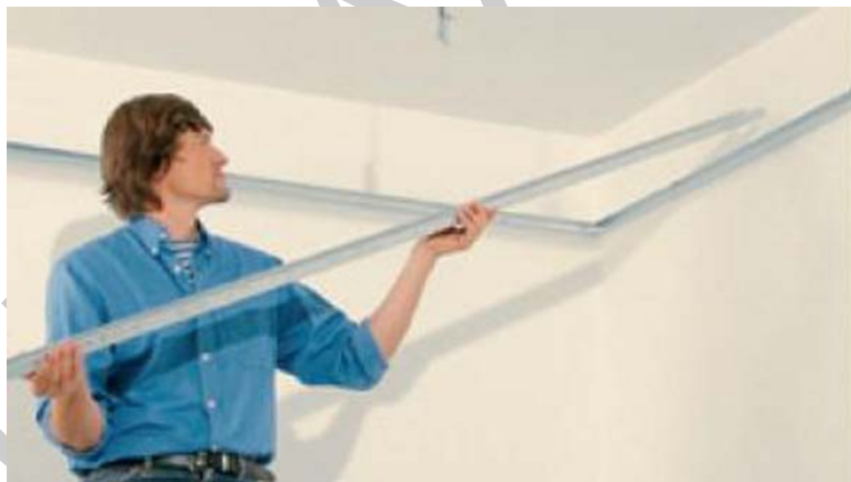
37. ábra. CD profilok elhelyezése 17
