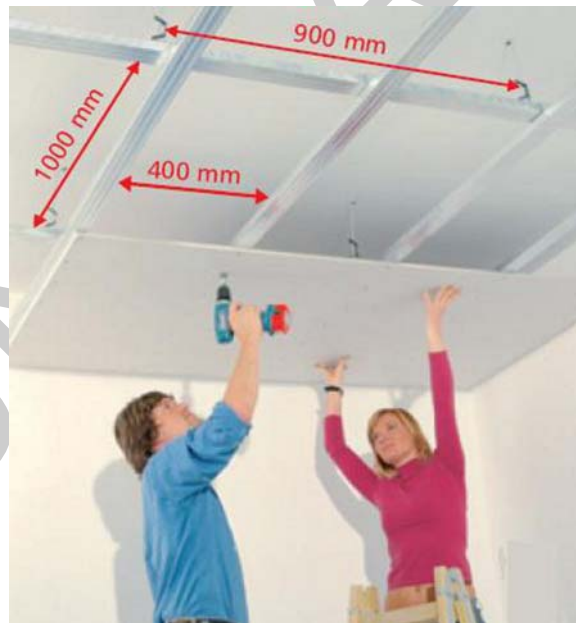
39. ábra Borítás rögzítése 17
