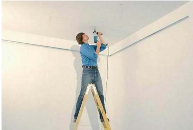
36. ábra. Függesztők felszerelése 17
