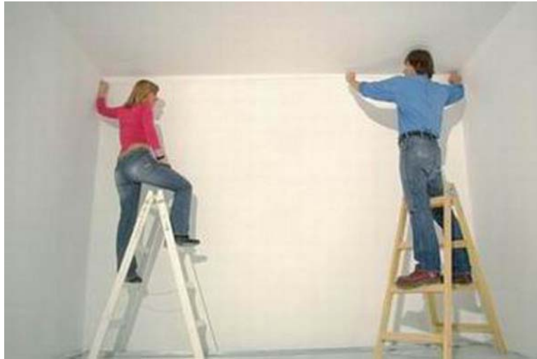
42. ábra UD profilok kijelölése 17
