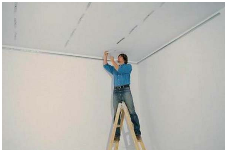
46. ábra. Függesztők rögzítése 17
