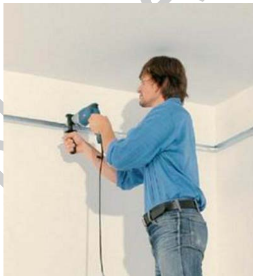
35. ábra. UD profilok rögzítése 17
