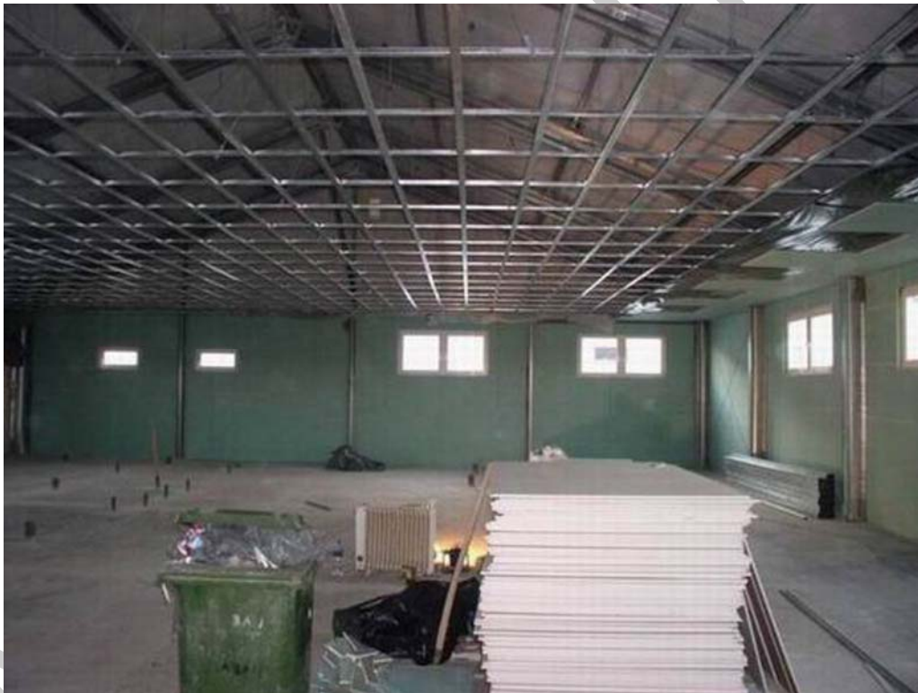
1. ábra Nagytáblás álmennyezet kivitelezése 1
