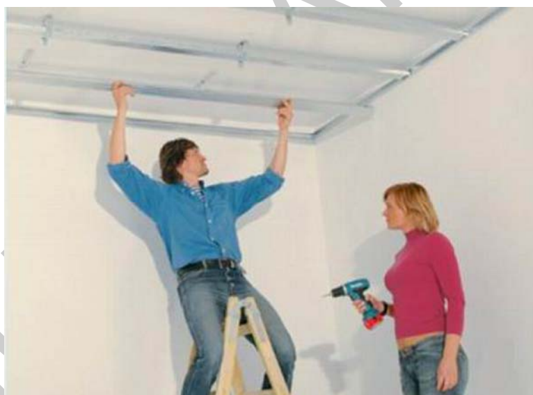
47. ábra CD profilok elhelyezése 17
