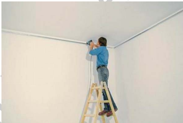
43. ábra UD profilok rögzítése 17
