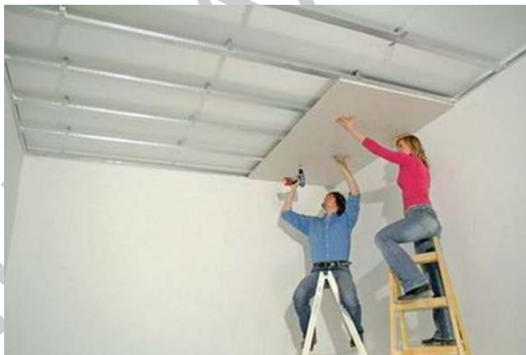
49. ábra. Borítás rögzítése 17
