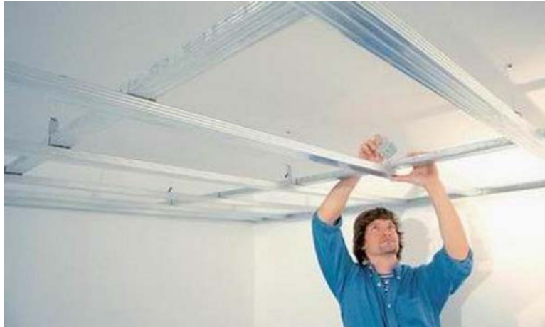
38. ábra. Keresztrögzőtők elhelyezése 17
