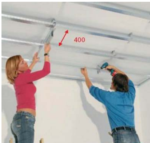
48. ábra. CD profilok toldása 17
