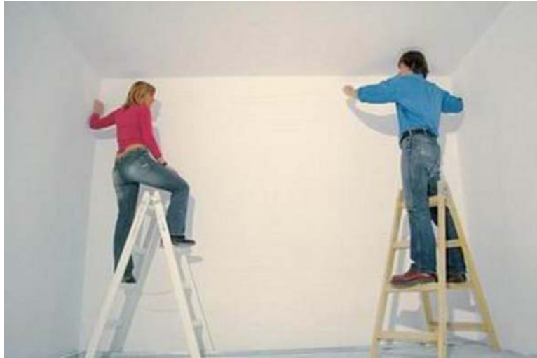
34. ábra. UD profilok kijelölése 17
