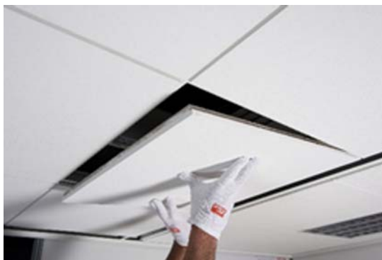
7. ábra. A kazetták szerelése 7
