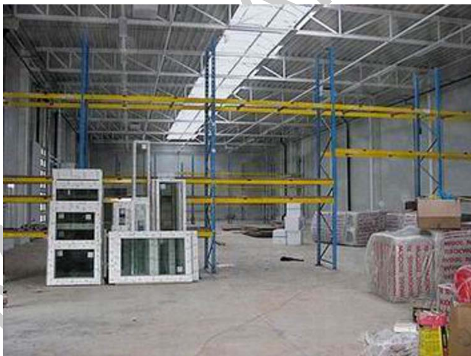
40. ábra. Csarnok tűzvédelmi szerkezeteinek kivitelezése 29
