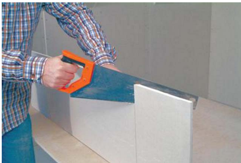
21. ábra. Vágás rócafarkú fűrésszel 20
