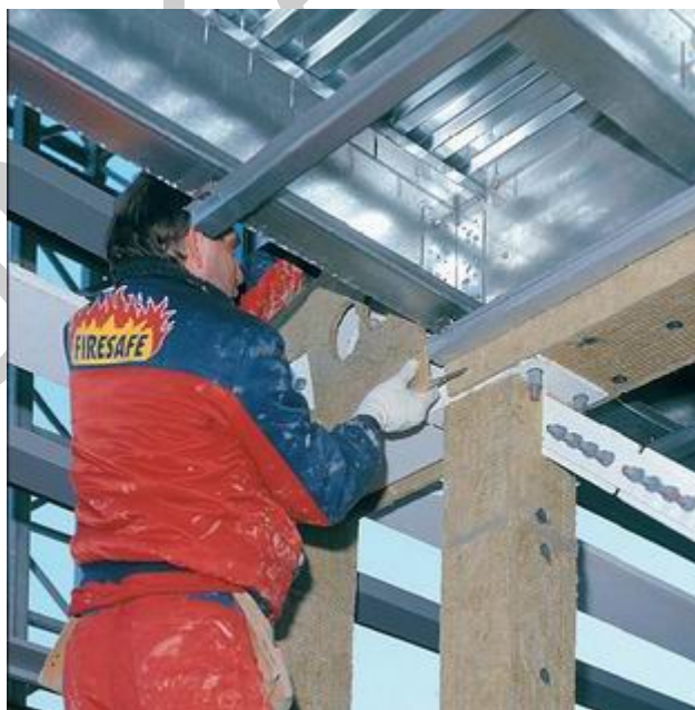
49. ábra. Légtechnikai vezeték tűzvédő borítása 38
