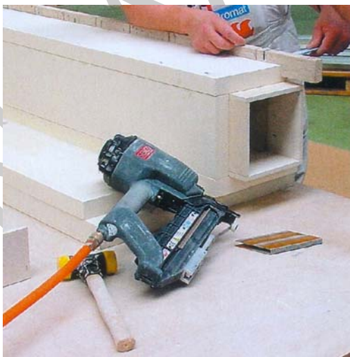
25. ábra. Rögzítés pneumatikus szerszámmal 22
