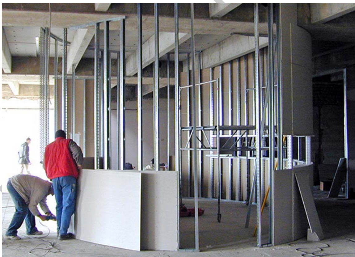
10. ábra. Szárazépítésű válaszfal szerelése 11
