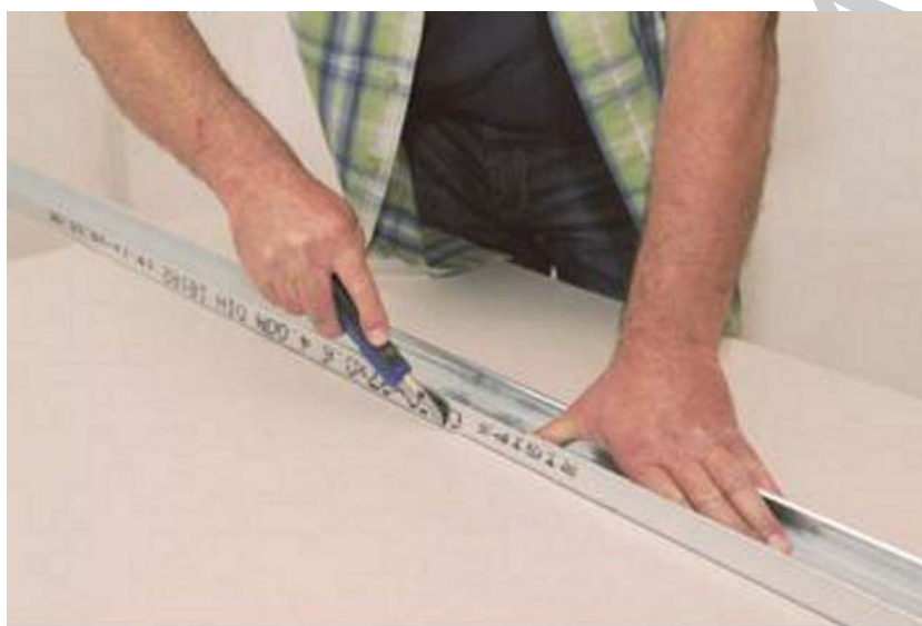
18. ábra. Valamelyik profil mellett átvágjuk a kartont 20
