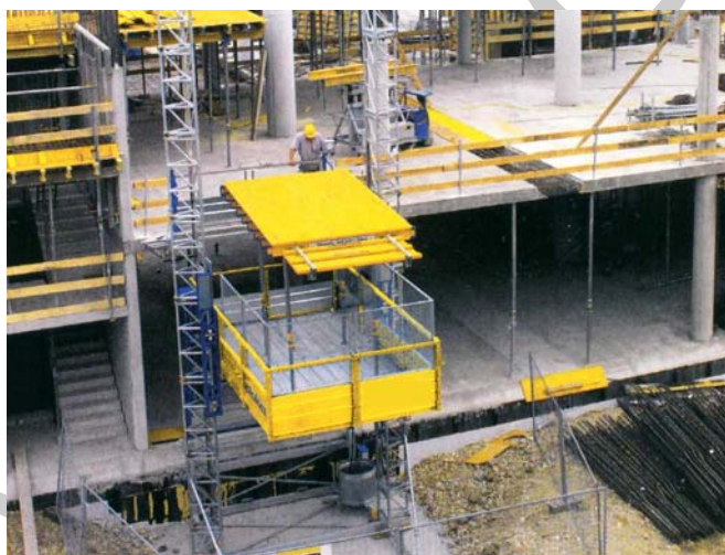
6. ábra. Födémhez rögzített fém kidugó állvány 7. ábra. Mozgatható homlokzati állvány
