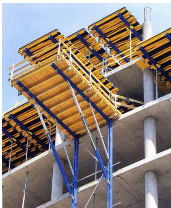
22. ábra. Födémszélre erősíthető kidugó állvány, rendszer elemekből
