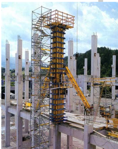
1. ábra. Feljáró lépcsőtorony, betonozó állványhoz
