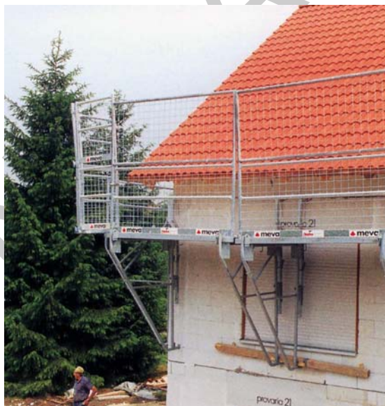
33. ábra. Konzolos függesztett állvány
