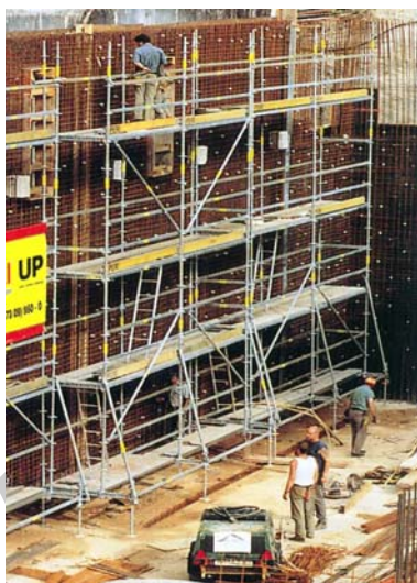
13. ábra. Mobil állvány betonacél szereléshez 14. ábra. Mobil állvány munkaszinttel, létrával
