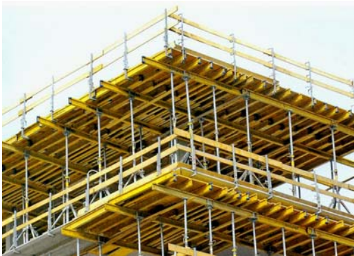
3. ábra Védőkorlát födém szinten és födémzsaluzaton. 4. ábra. Védőállvány födémzsaluzaton
