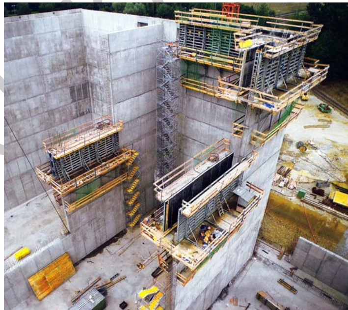
5. ábra. Feljáró lépcsőtorny a falzsaluzathoz, kúszó állványhoz
