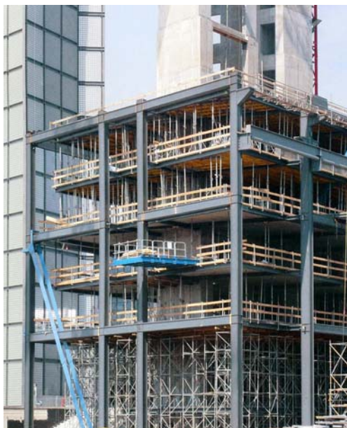
6. ábra. Födémhez rögzített fém kidugó állvány 7. ábra. Mozgatható homlokzati állvány
