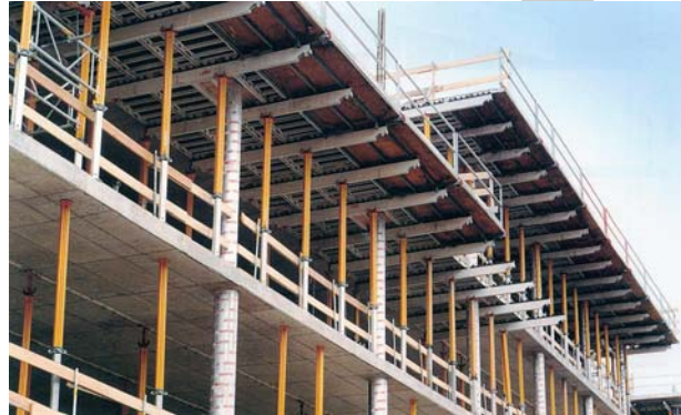
3. ábra Védőkorlát födém szinten és födémzsaluzaton. 4. ábra. Védőállvány födémzsaluzaton
