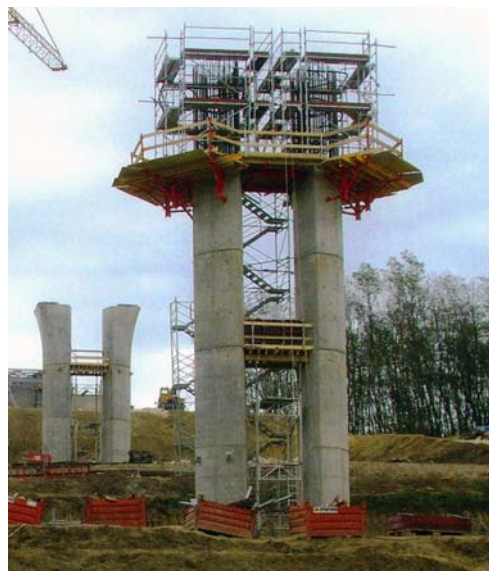
1. ábra. Feljáró lépcsőtorony, betonozó állványhoz
