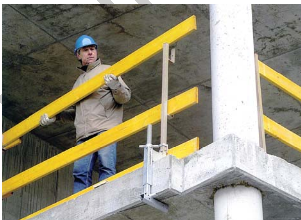
31. ábra. Födémşélre rögzített munkavédelmi állvány
