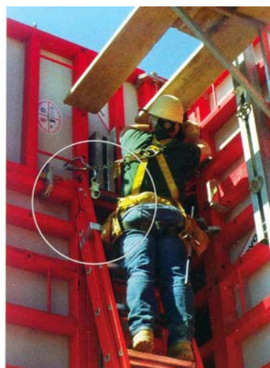
30. ábra. Falzsaluhoz visszakötés rögzítő láncsal (amerikai OSHA-előírás)
