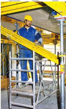
17. ábra. Gördíthető szerelőállvány födémzsalúzáshoz 18. ábra. Mozgatható szerelőállvány
