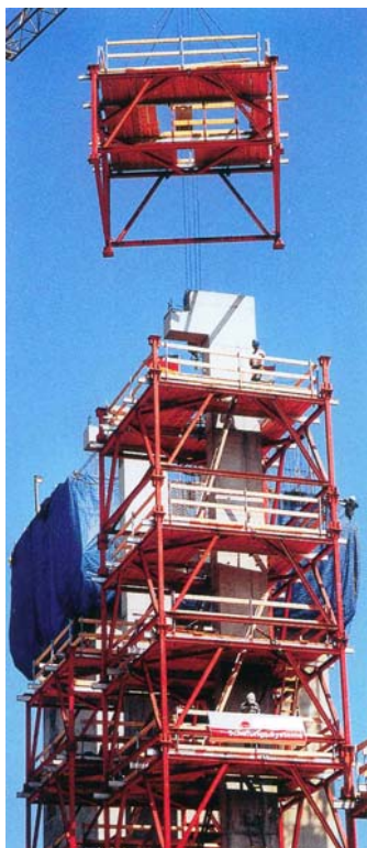
19. ábra. Munkaszinttel ellátott állványtorony elhelyezés 20. ábra. Lépcsőtorony
