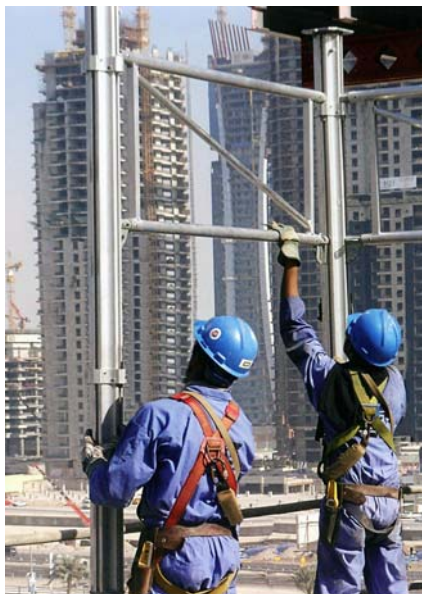
28. ábra. Testheveder használat állvány szerelésnél 29. ábra. Védőfelszerelés, biztonsági heveder
