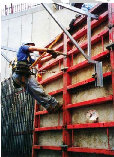
30. ábra. Falzsaluhoz visszakötés rögzítő láncsal (amerikai OSHA-előírás)
