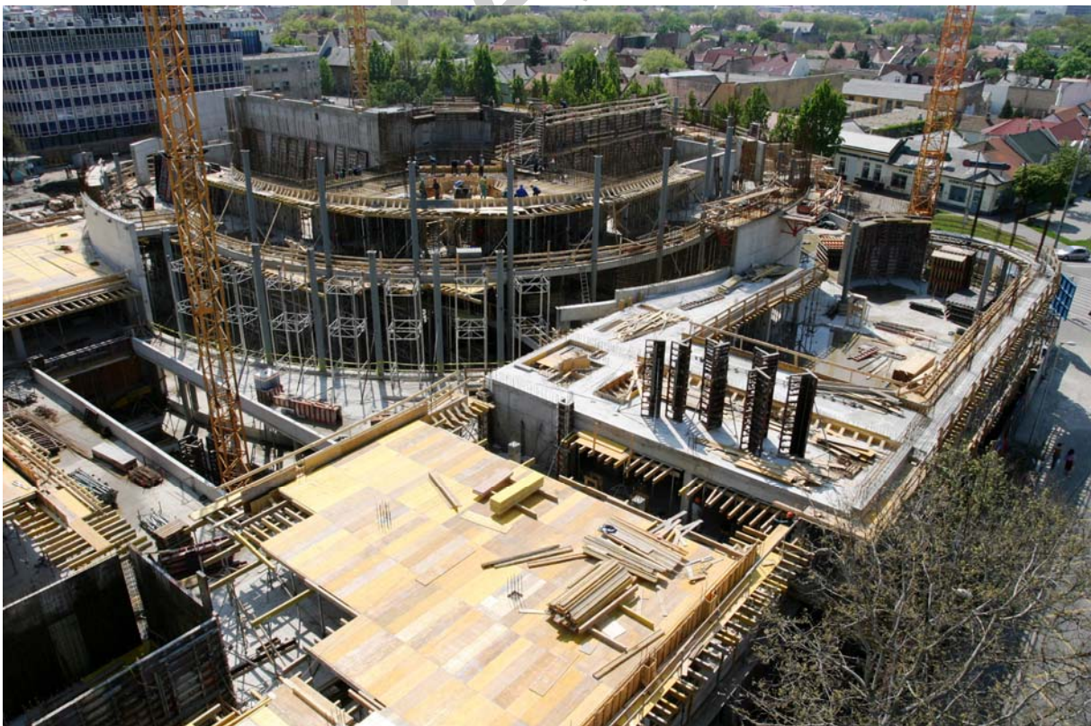
7. ábra. Változatos födémszerkezet, gerendák, födémek zsaluzása fatartós födémzsaluzattal
