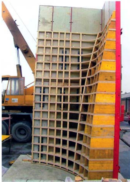
2. ábra Keretes falzsaluba helyezett egyedi zsaluforma – és az Alkus héjjal borított zsaluzat
