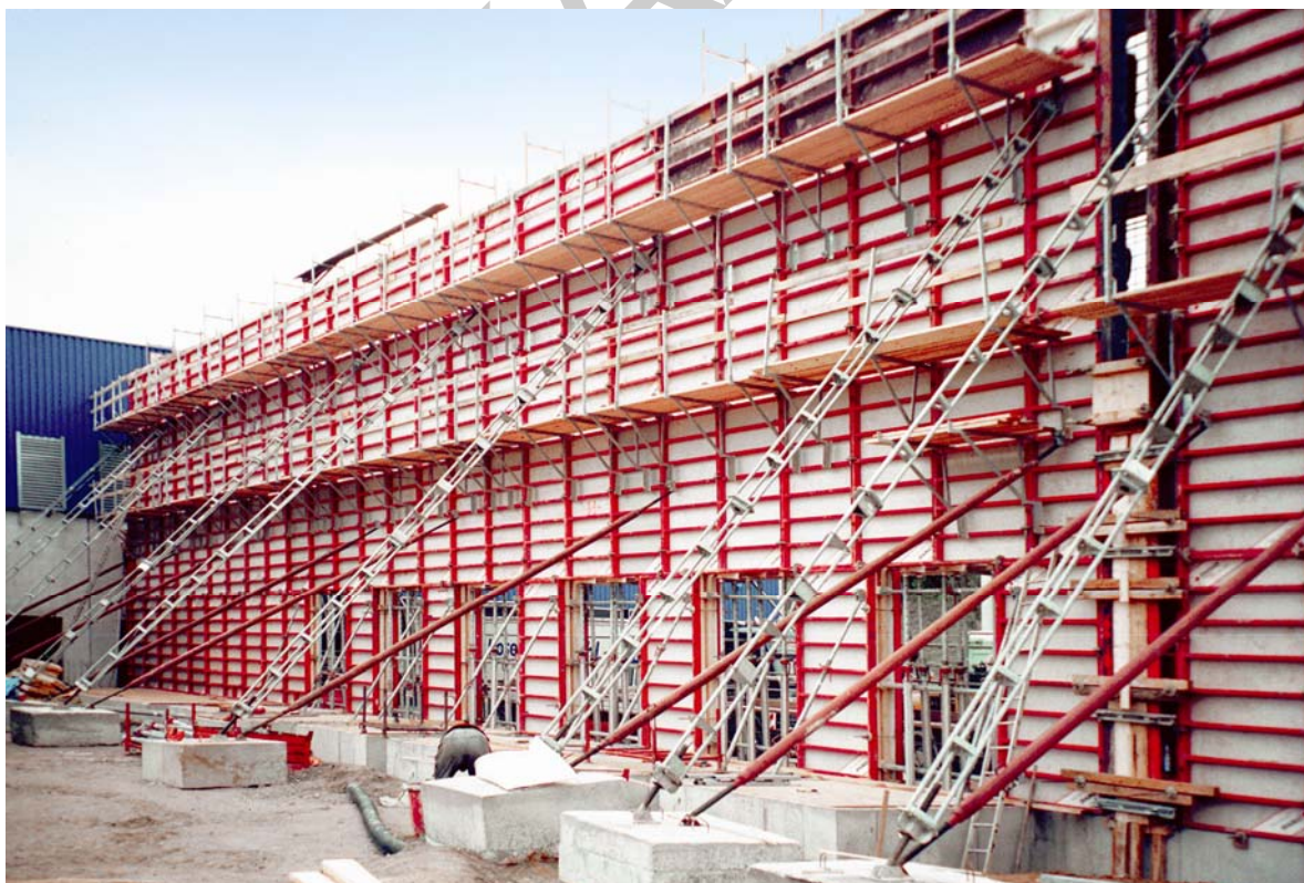
5. ábra. Kétoldali falzsaluzás, keretes falzsaluval, magasság 9 m
