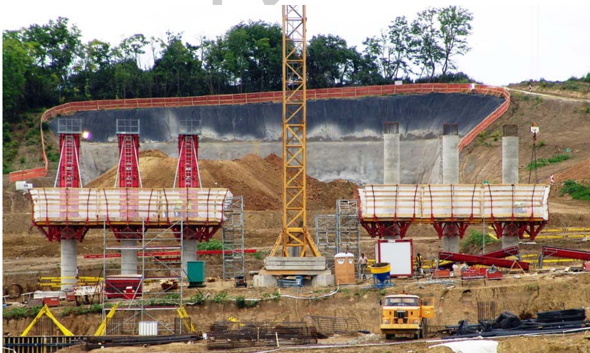
31. ábra. A zsaluterven szereplő körpillérek kivitelezésének építési fázisai
