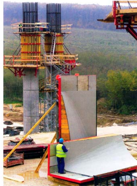
2. ábra Keretes falzsaluba helyezett egyedi zsaluforma – és az Alkus héjjal borított zsaluzat
