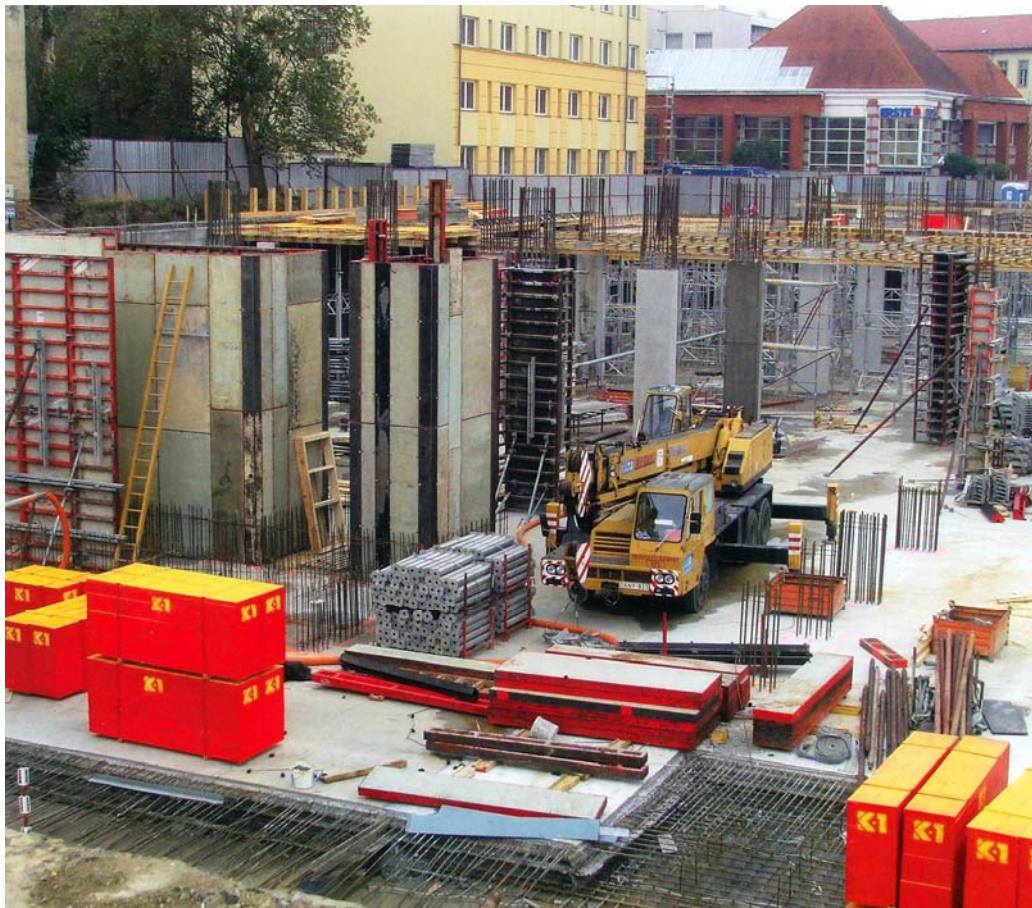
1. ábra. Pincszint pillér, fal, födémzsaluzás
