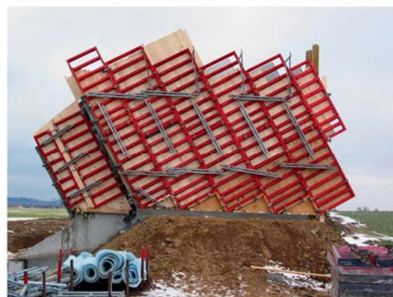
3. ábra. Körmedence zsaluzás keretes falzsaluval. – Ferdefal zsaluzás
