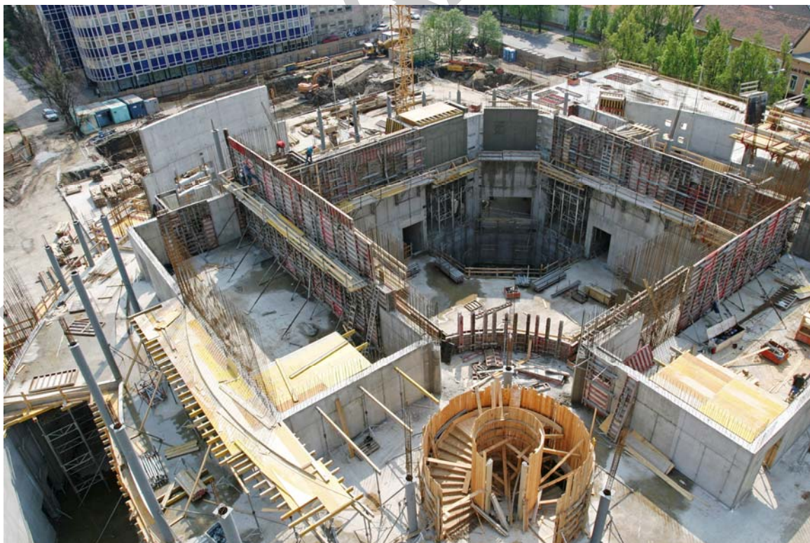
53. ábra. Épületszerkezet zsaluzása rendszerzsaluzattal és hagyományos zsaluzattal
