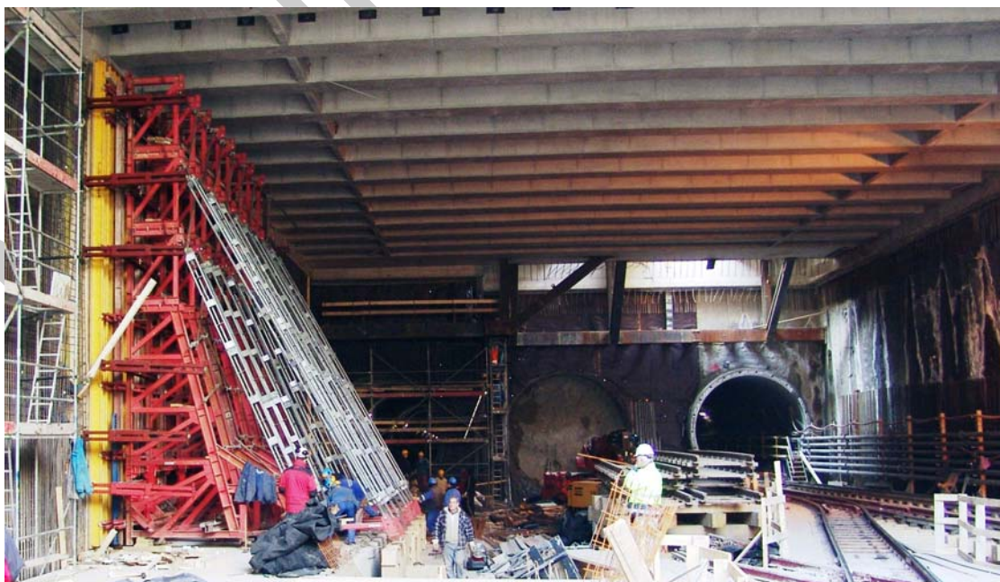
40. ábra. Metró állomás belső látszó betonfelületű falszerkezetének egyoldali falzsaluzata
