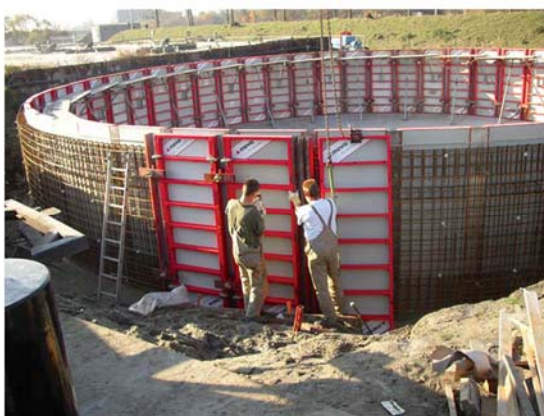
3. ábra. Körmedence zsaluzás keretes falzsaluval. – Ferdefal zsaluzás
