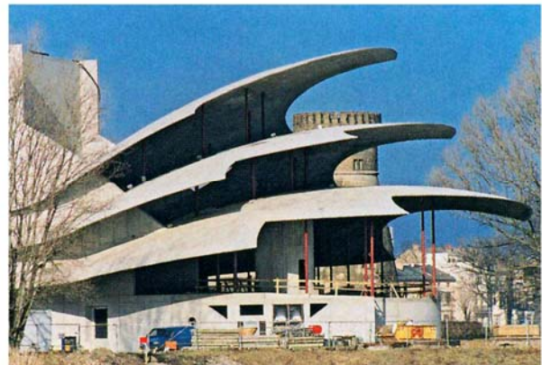
6. ábra. Egyedi formájú födém, zsalu alátámasztási vázlata és a kész födémszerkezet
