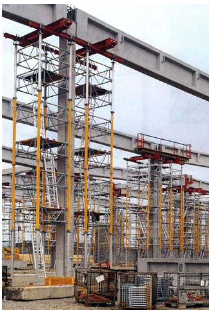
28. ábra. Előregyártott gerenda alátámasztás 29. ábra. Előregyártott gerenda alátámasztás
