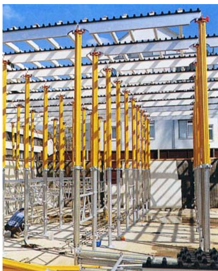
6. ábra. Födém támaszok beépítés közben 7. ábra. Teleszkópos födém támasz
