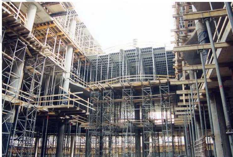
1. ábra. Alumínium födémzsaluzat támaszokkal, asztalzsaluzat keretes állvánnyal, konzolos födém alátámasztás állvány tornyokkal (Bp. Mamut II)
