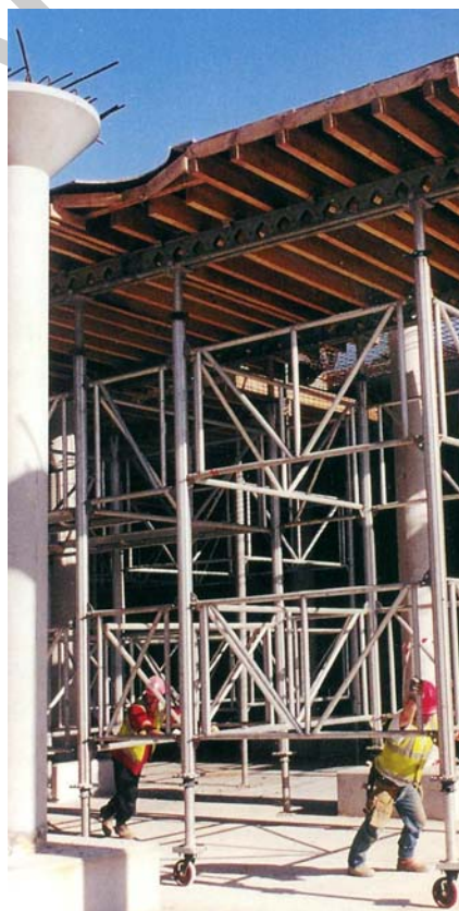
2. ábra. Gerenda alátámasztó állványzat ELTE Bp. 3. ábra. Asztalzsaluzat állványának mozgatása gördítő keréken
