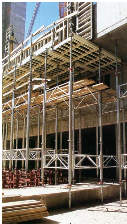
32. ábra. Támaszrendszerű keretes állvány 33. ábra. Főtartót alátámasztó állvány és nagymagasságú födém támasz
