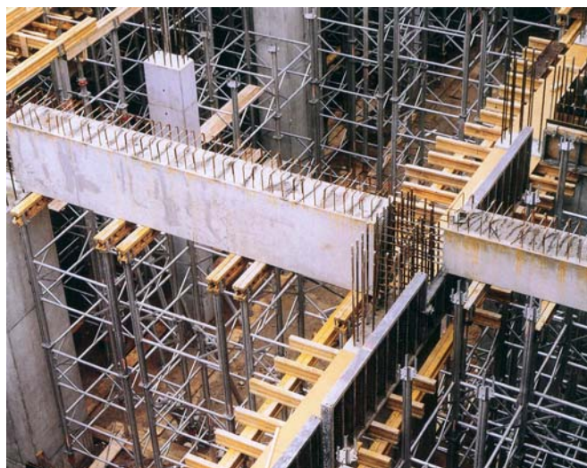
28. ábra. Előregyártott gerenda alátámasztás 29. ábra. Előregyártott gerenda alátámasztás
