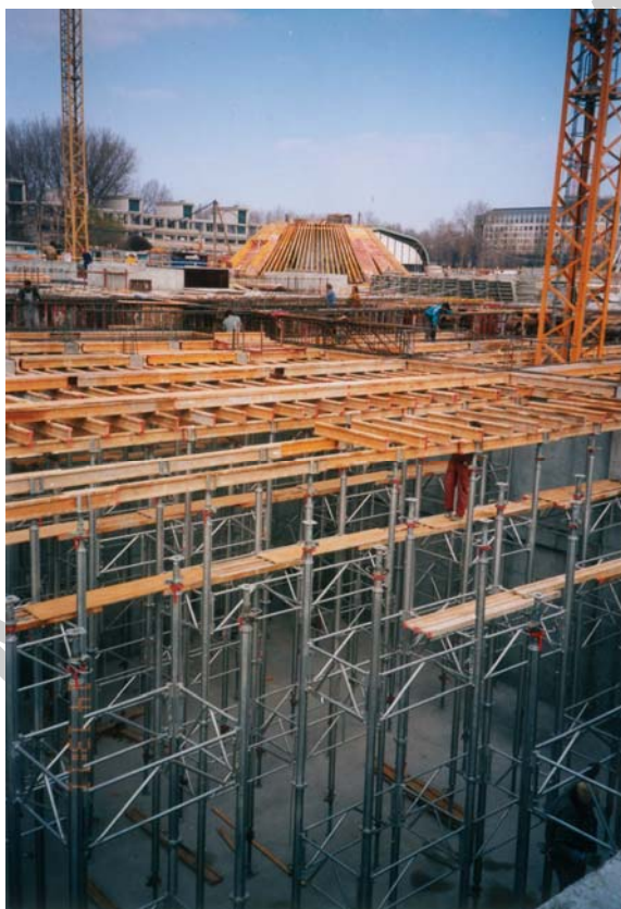
2. ábra. Gerenda alátámasztó állványzat ELTE Bp. 3. ábra. Asztalzsaluzat állványának mozgatása gördítő keréken
