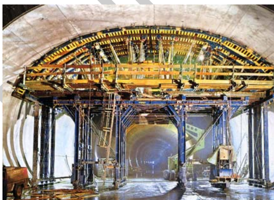
30. ábra Alagút földszerkezetének zsaluzata 31. ábra. Alagút zsaluzat előszerelése (Ballahegyi alagút, Magyar-Szlovén vasútvonal)
