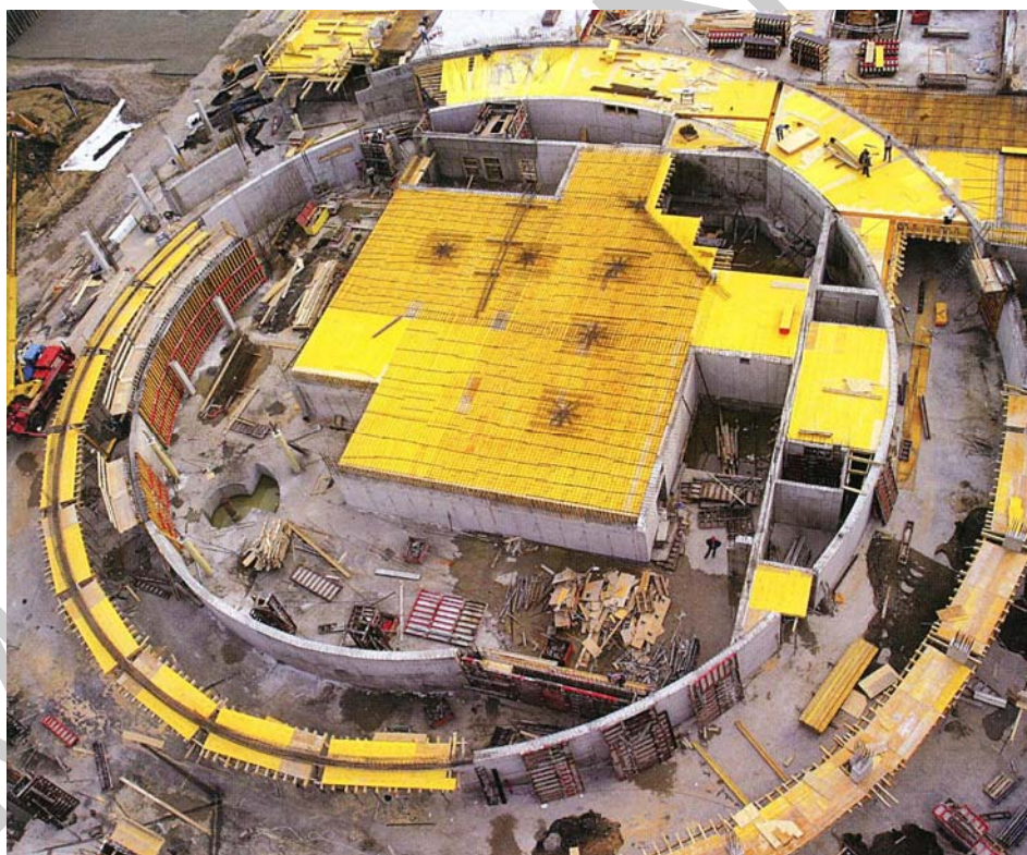
1. ábra Íves és egyenes falakkal, gerendákkal közrefogott födém mezők fatartós zsaluzata (Debrecen: Kölcsey Központ)
