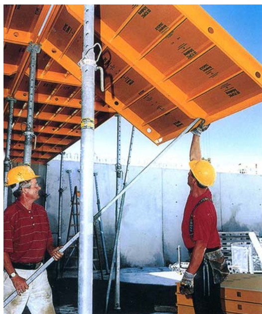
41. ábra. Nagyméretű födémelem elhelyezés
