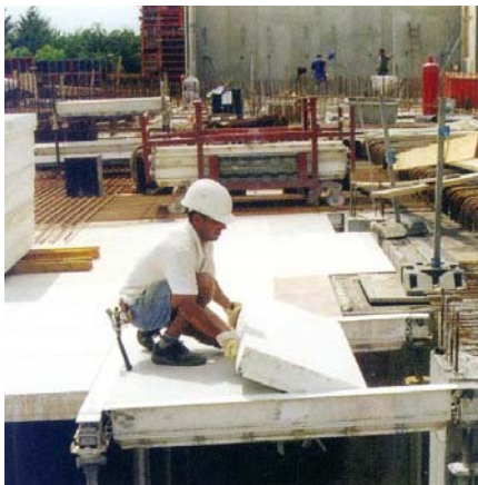
37. ábra Födémelem behelyezés
