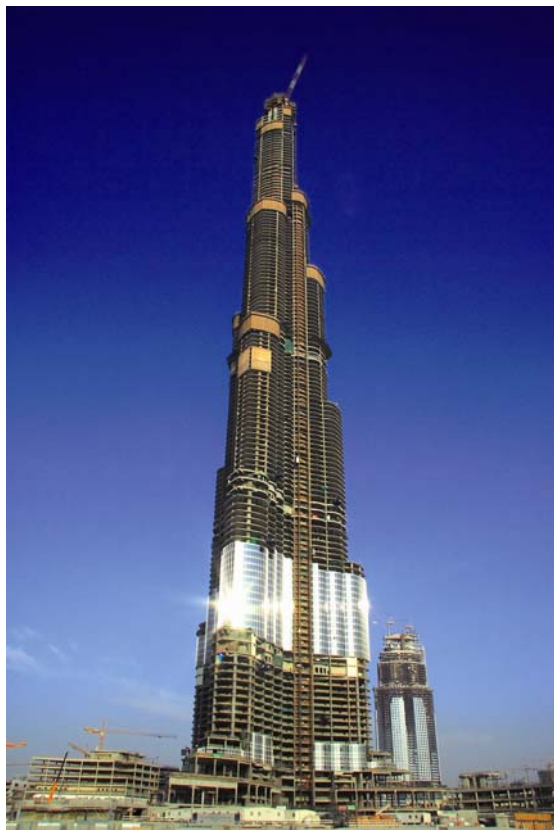
49. ábra. Burj Dubaj szerkezet építés közben
