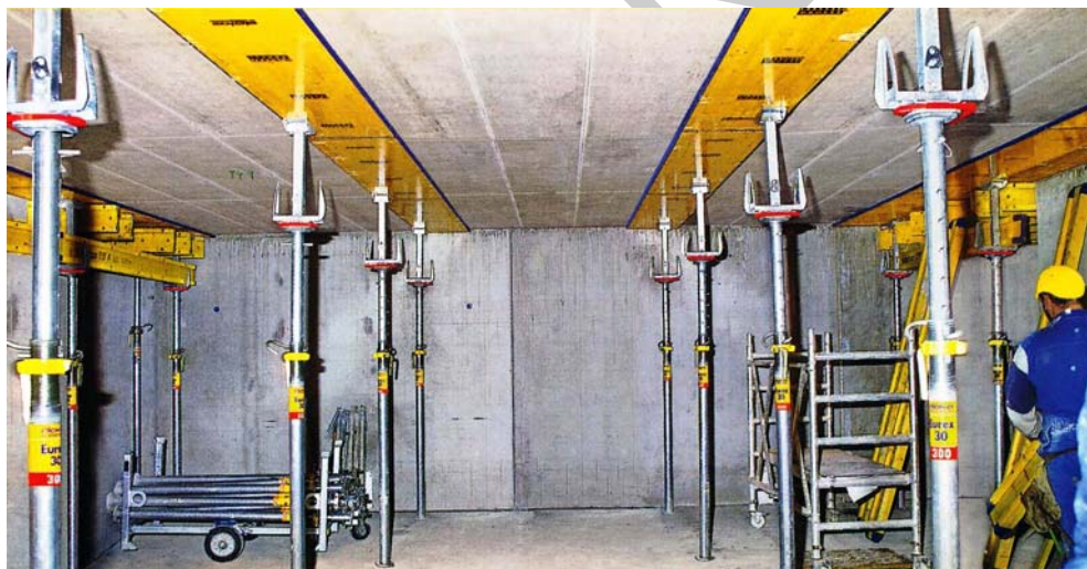
24. ábra. Utólagos födém alátámasztás, ejtőfejes keresztfej alkalmazásánál
