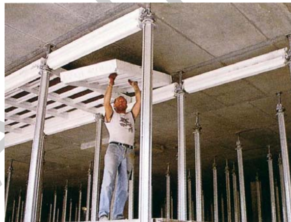
38. ábra. Zsalu leengedés, födémelem kiszaluzás
