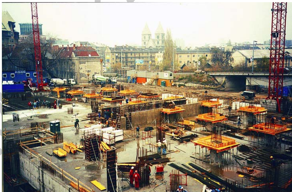
2. ábra. Gombafejes födémnél a fejrészek zsaluzása fatartós födémzsaluzattal, a födém többi része, ejtőfejes alumínium rendszerű zsaluzattal. (Budapest: WestEnd City Center)
