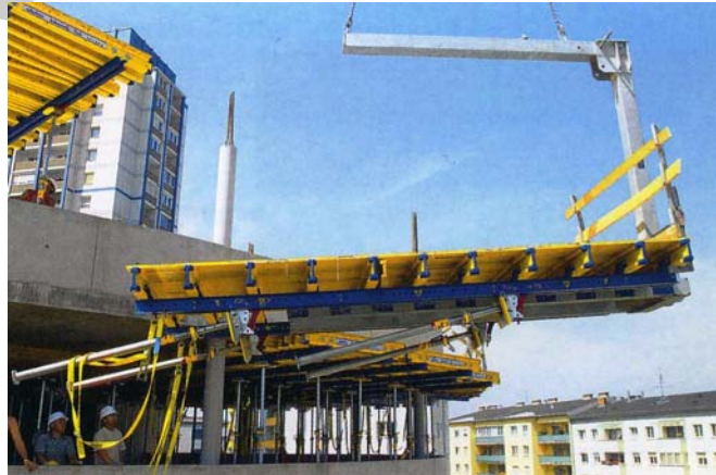
7. ábra. Födémasztal zsaluzat korláttal felszerelt homlokzati elemének elhelyezése himbával
