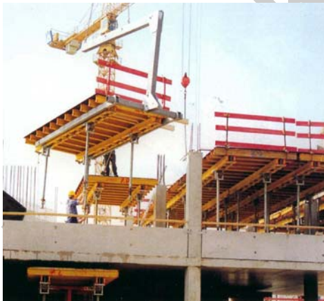
7. ábra. Födémasztal zsaluzat korláttal felszerelt homlokzati elemének elhelyezése himbával
