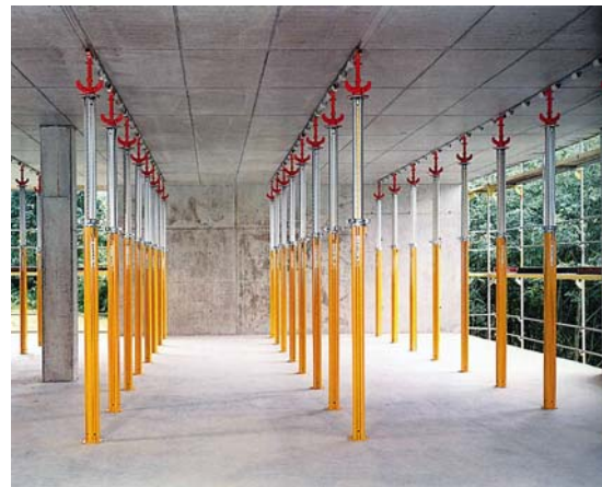
9. ábra. 10. ábra. Ejtőfejes, főtartós, betételemes alumínium födémzsaluzat bezsaluzása, és a kizsaluzott födém utólagos alátámasztása, az ejtőfejes födém támaszokkal
