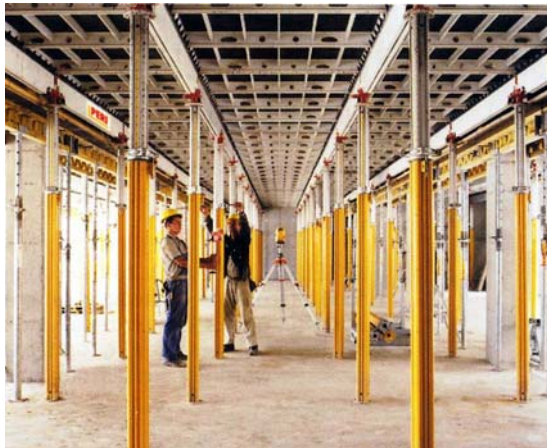
9. ábra. 10. ábra. Ejtőfejes, főtartós, betételemes alumínium födémzsaluzat bezsaluzása, és a kizsaluzott födém utólagos alátámasztása, az ejtőfejes födém támaszokkal
