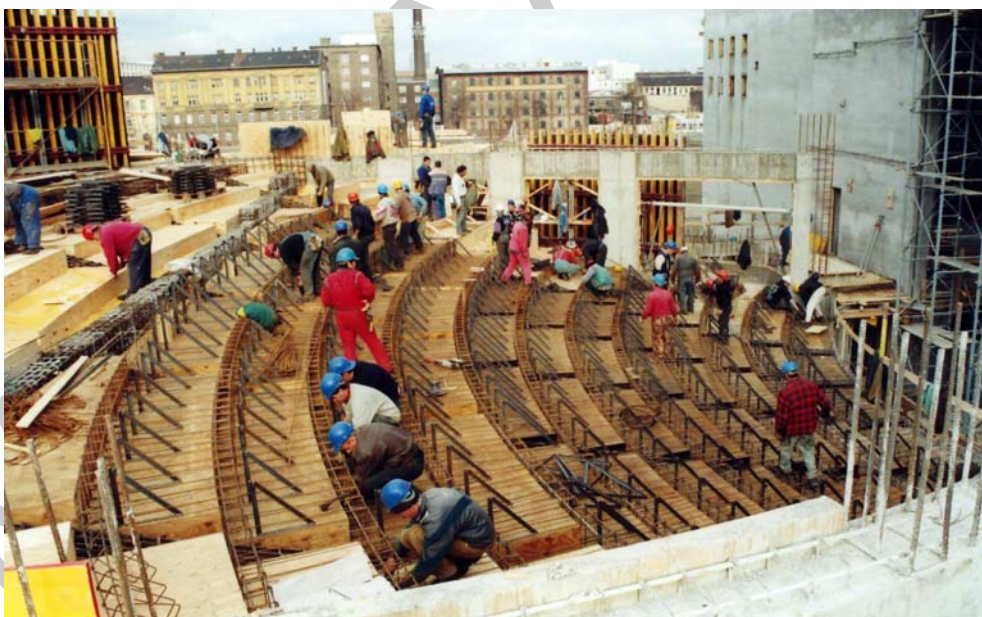
4. ábra. Lépcsős lelátó zsaluzása, és vasszerelése (Budapest: Nemzeti Színház)
