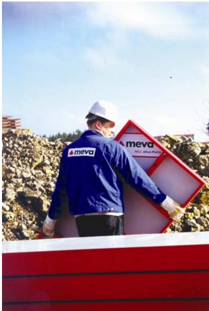
5. ábra. Kézzel mozgatható zsaluelem
