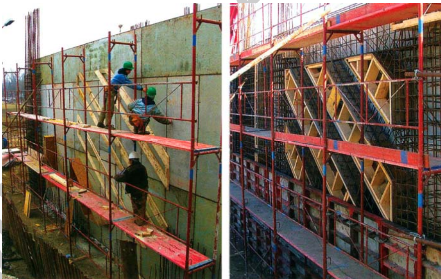
44. ábra. Falzsazatra rögzített, kidobozolás, nyílás kirekesztés
