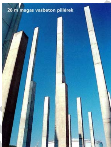
1. ábra Kizsaluzott pillérszerkezet
