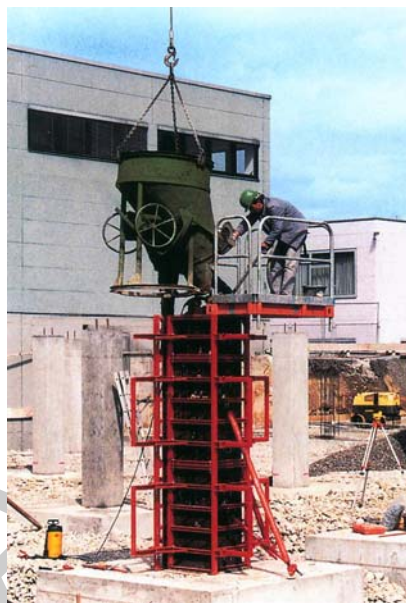
13. ábra Nyitható pillérzsaluzat, betonozás
