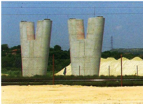
7. ábra „Y” formájú hídpillér
