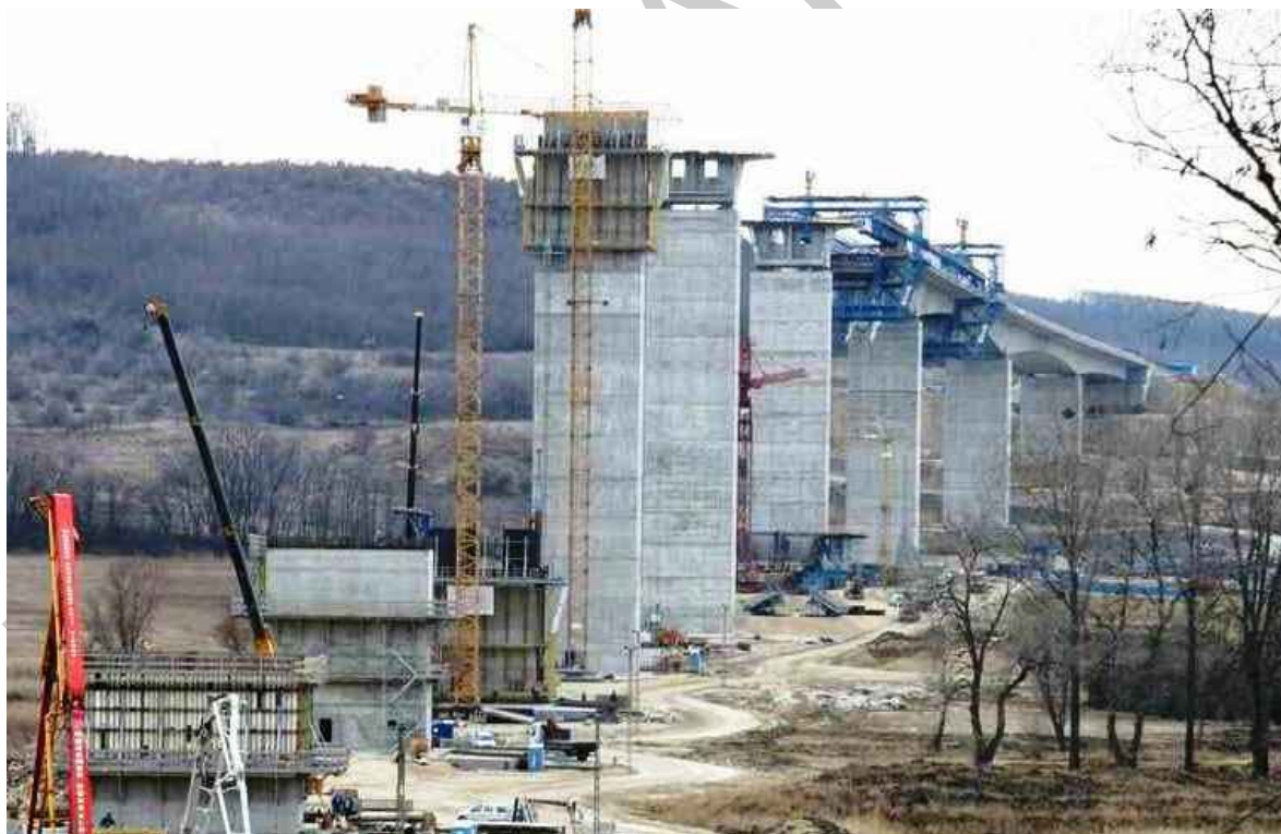
9. ábra Köröshegyi völgyhíd hídpilléreinek zsaluzása, fatartós falzsaluzati elemekkel
