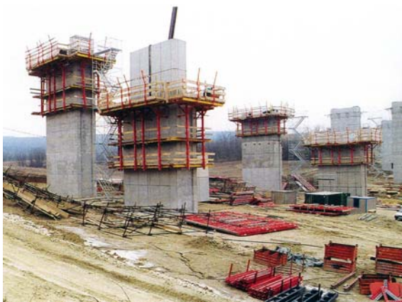
5. ábra M7 autópálya híd, Balatonszárszónál
