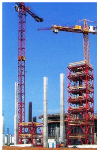
2. ábra Állványtorony a pillérzsaluzathoz
