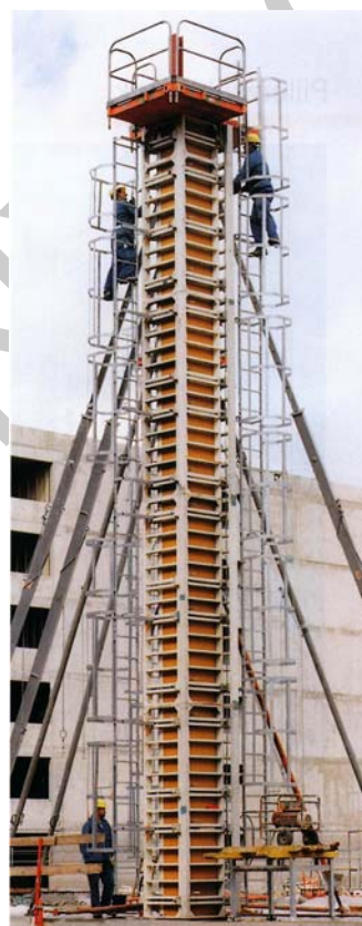
19. ábra Elemekből összeállított oldaltámasz 20. ábra Nagymagasságú pillér megtámasztás
