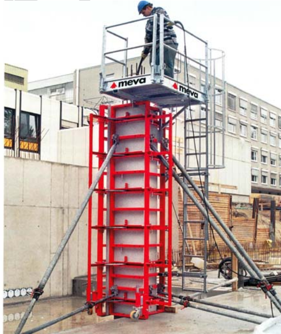
25. ábra Széthajtható pillérzsaluzat kizsaluzva, és betonozás közben
