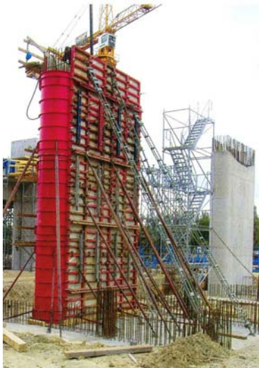
3. ábra Megyeri híd ártéri hídpillérek
