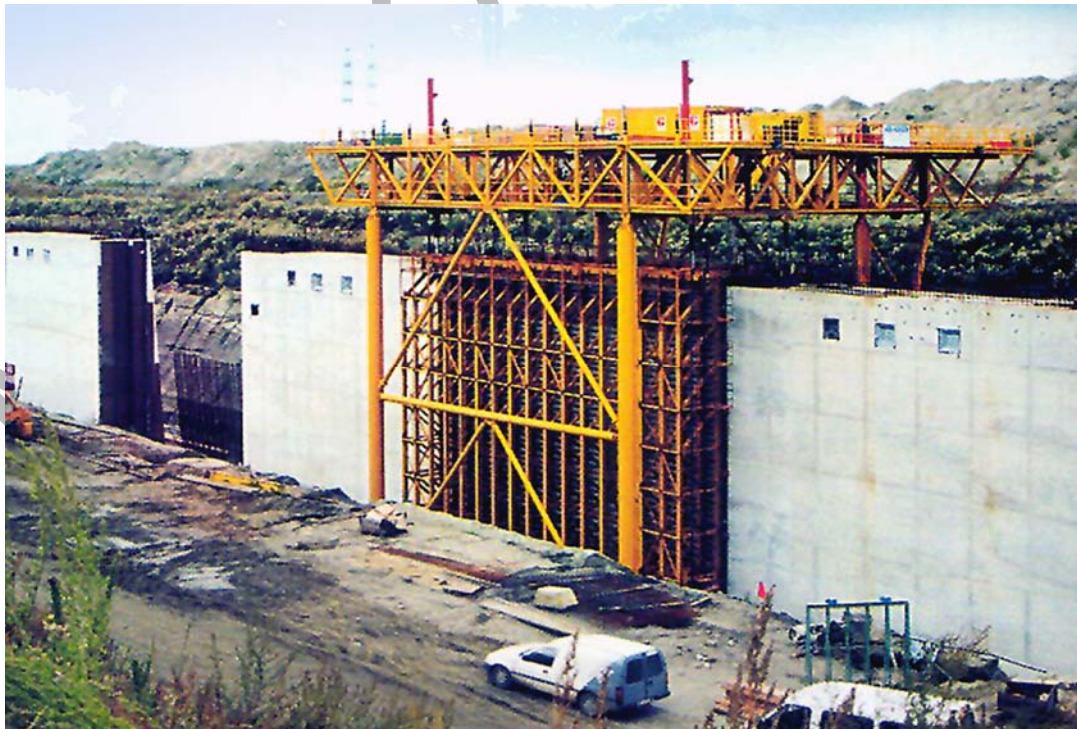
24. ábra. Kikötődokk: 5,3 m széles, 17 m magas, 5 km hosszú fal, szakaszos építése (Antwerpen)
