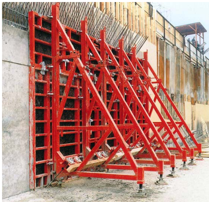
6. ábra. Egyoldali falzsaluezat, támasztó bakokkal – zsalue lehoronyzással
