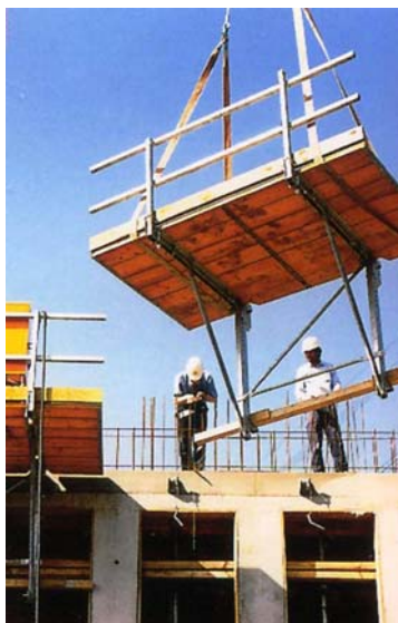
8. ábra. Homlokzatra helyezhető konzolos állvány 9. ábra. Zsalu és állvány választék
