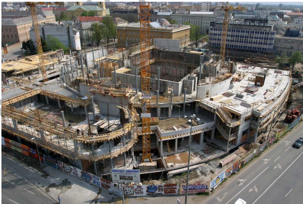
22. ábra. Középület szerkezetének zsaluzása (Debrecen)
