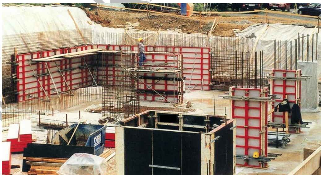
5. ábra. Rézsűsen kialakított földpart mellett kétoldali falzsaluzás – pillérzsalu falelemekből
