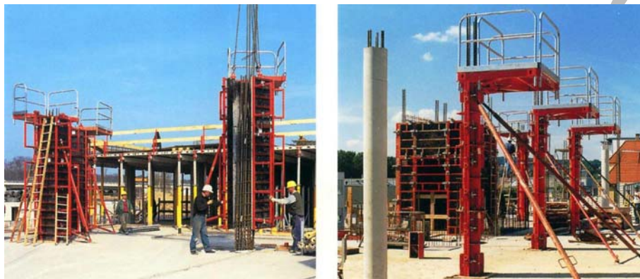
4. ábra. Egyben áthelyezhető nyitható pillérzsaluzat – körpillér (oszlop) zsaluzat
