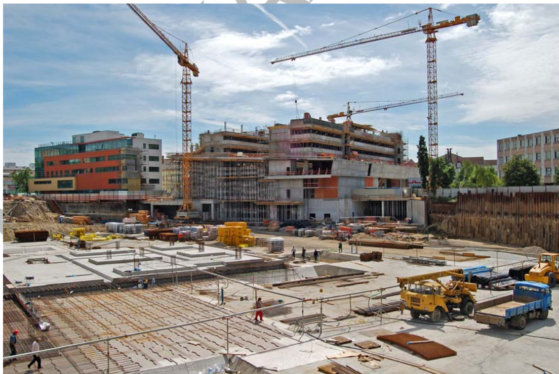
26. ábra. Többfunkciós épületegyüttes, monolit vasbeton és előregyártott épületszerkezetének zsaluzási-kivitelezési fázisai (Debrecen)
