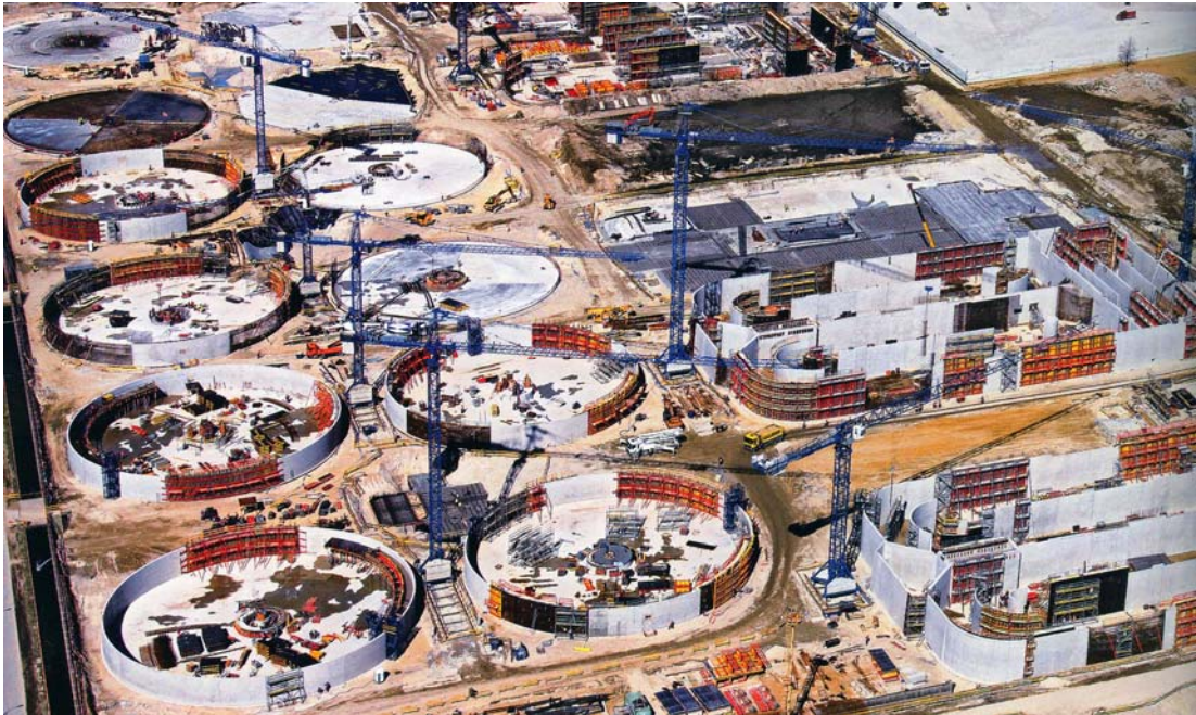
23. ábra. Szennyvíztisztító telep medencéinek építési, zsaluzás, fázisai (Lengyel ország)
