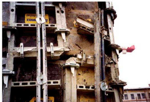
25. ábra. Szerelési hiba a betonozás során a pillérzsaluzat tönkremeneteléhez vezet 27
