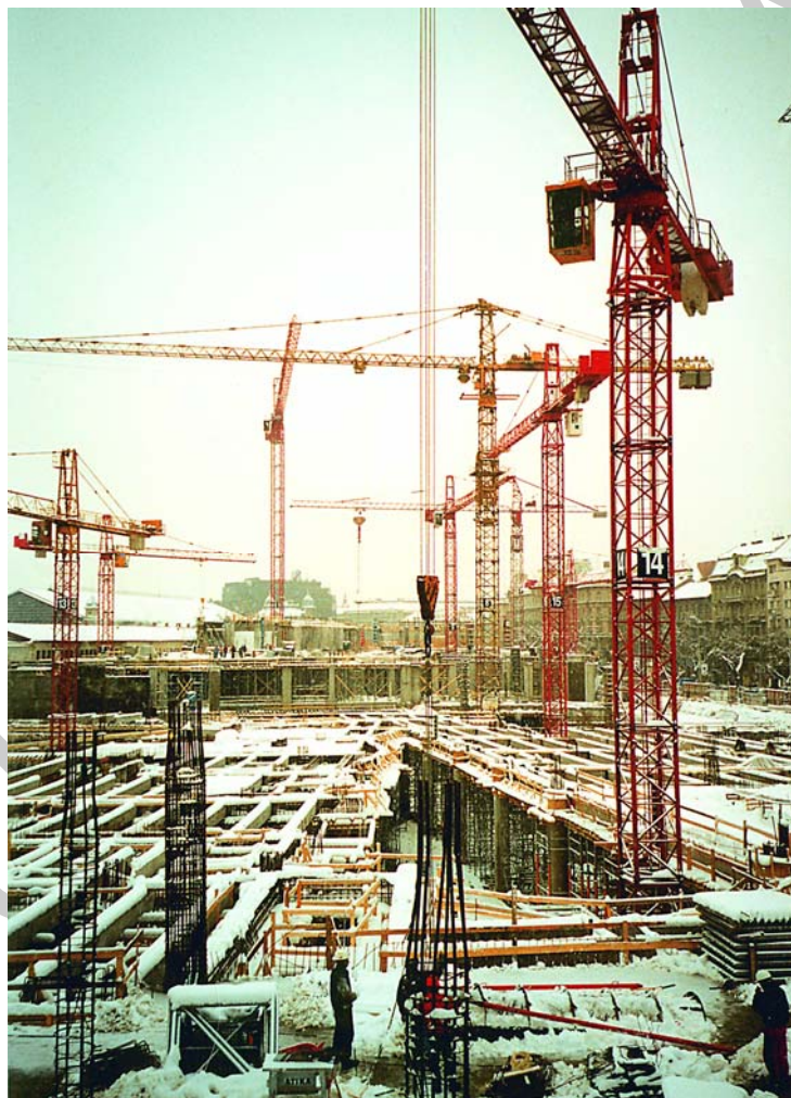
28. ábra. Hóval borított zsaluszerkezet sok veszélyt rejt 30
