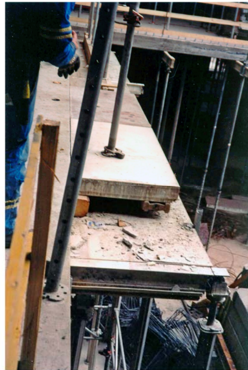
34. ábra. Falzsaluzat mozgatus-, födemelem terhelés 36
