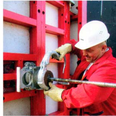
7. ábra. Betöltőnyílásos elem csatlakozó elemei, azok felhelyezése 7
