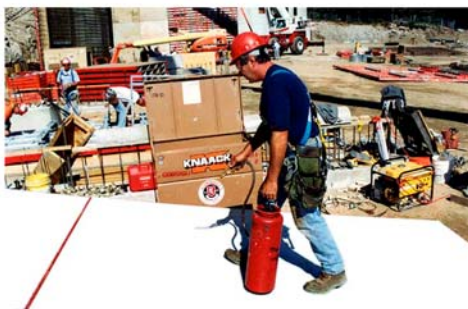
12. ábra. Zsaluhéj felület permetezése, és a zsaluleválasztó felhordása hengerrel 12
