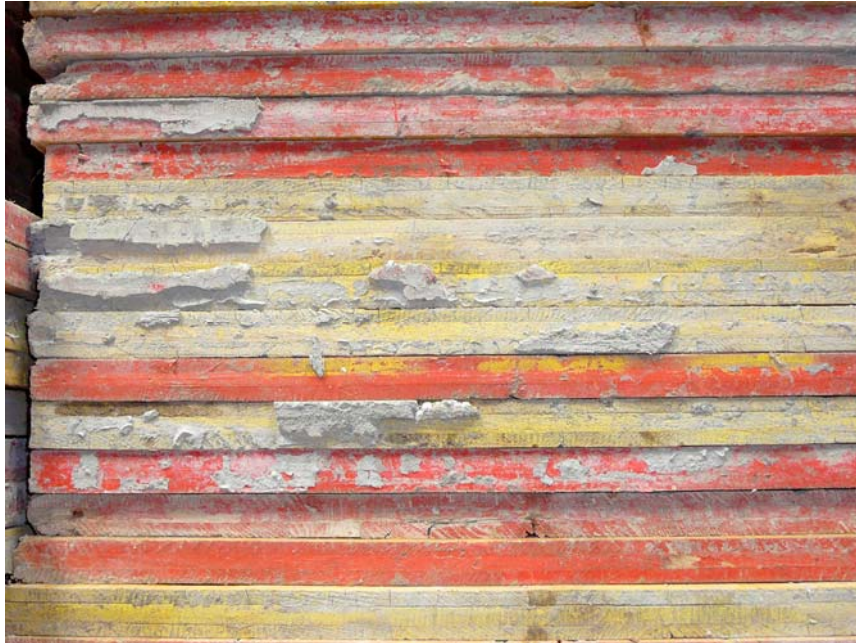
20. ábra. Háromrétegű födém zsaluhéj köteg, válogatás és tisztítás előtt 22
