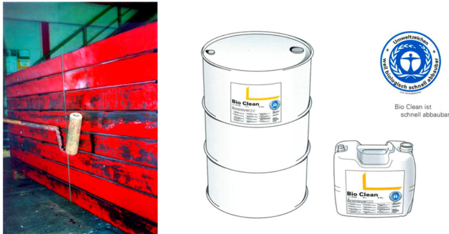
13. ábra. Fémkeretes falzsaluzat oldalfelületének kezelése 13 -, hordós és kannás zsaluolaj 14
