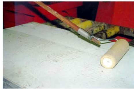
12. ábra. Zsaluhéj felület permetezése, és a zsaluleválasztó felhordása hengerrel 12
