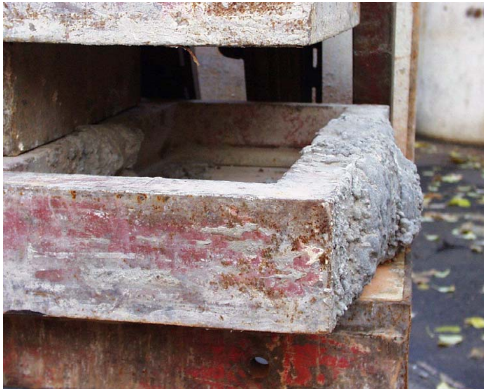
5. ábra. A zsaluzat keretén megszilárdult betondarab megakadályozza a használatát 5
