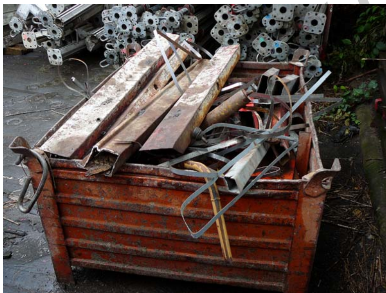
29. ábra. Selejtes anyagokat az arra kijelölt területen kalodákban, ládákban kell gyűjteni 31
