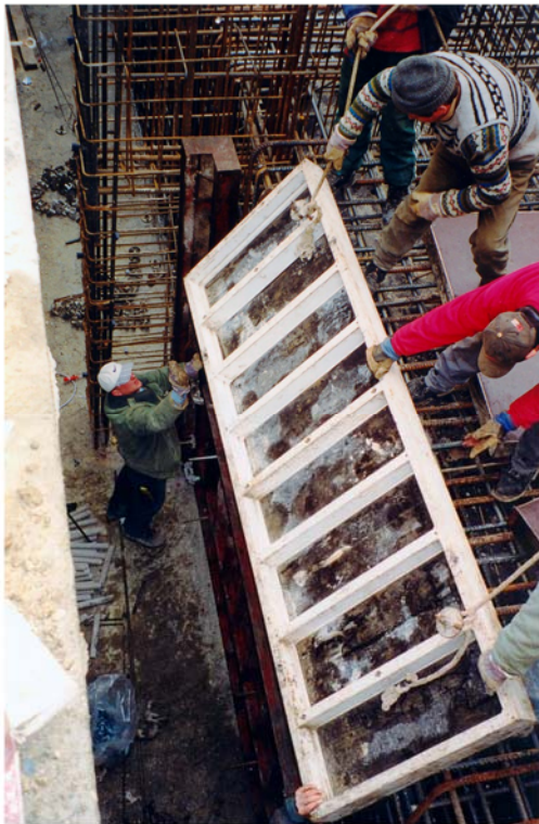
34. ábra. Falzsaluzat mozgatus-, födemelem terhelés 36
