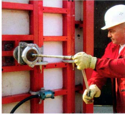
7. ábra. Betöltőnyílásos elem csatlakozó elemei, azok felhelyezése 7
