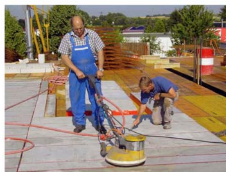
11. ábra. Műanyag zsaluhéj tisztítás vízzel, illetve forgótárcsás készülékkel 11
