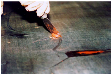
15. ábra. Fa zsaluej javítás-, műanyag zsaluej javított felületének simítása 16
