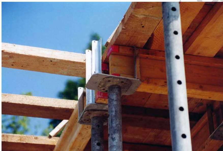
30. ábra. Fatartós födém kialakítás 32
