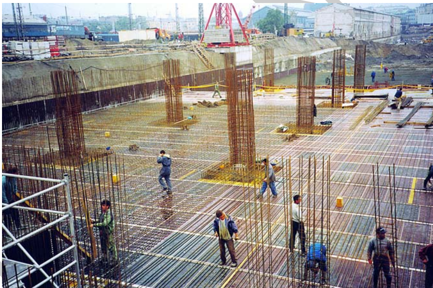
14. ábra. Vasszerelés az ejtőfejes – betételemes födémzsaluzaton 15
