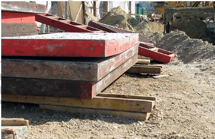
3. ábra. Az acélkeretes falzsalu elem elhajlás 3
