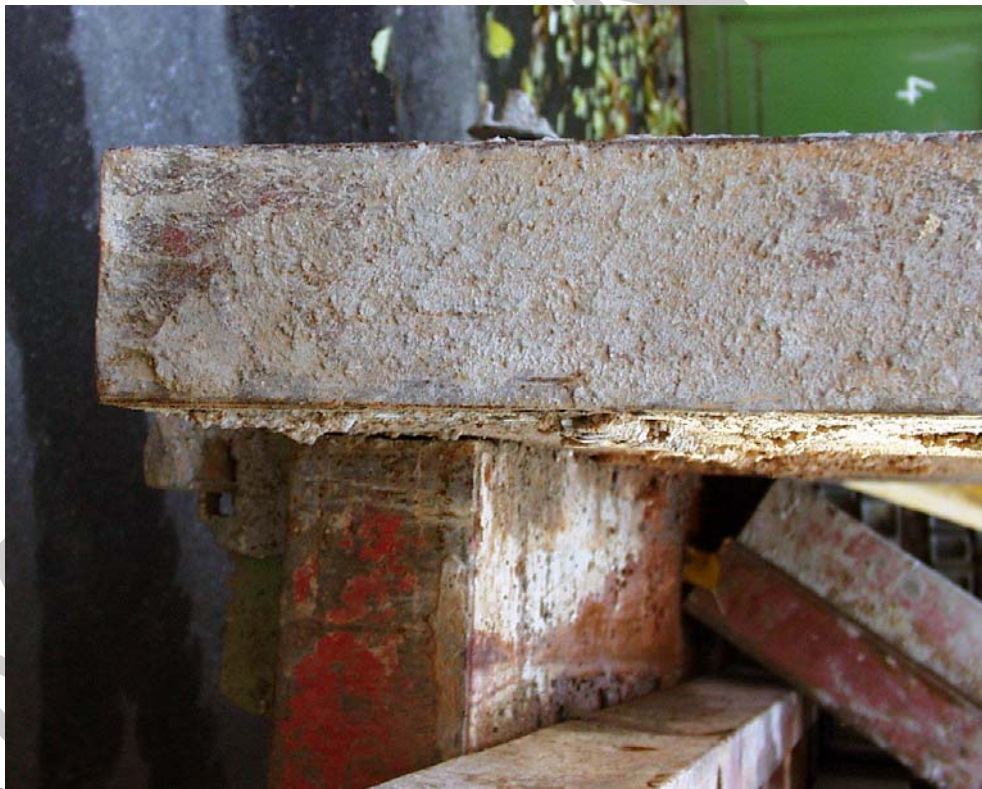
8. ábra. Falzsalu acélborítású belső sarokelemének felületén megszilárdult betonréteg 8
