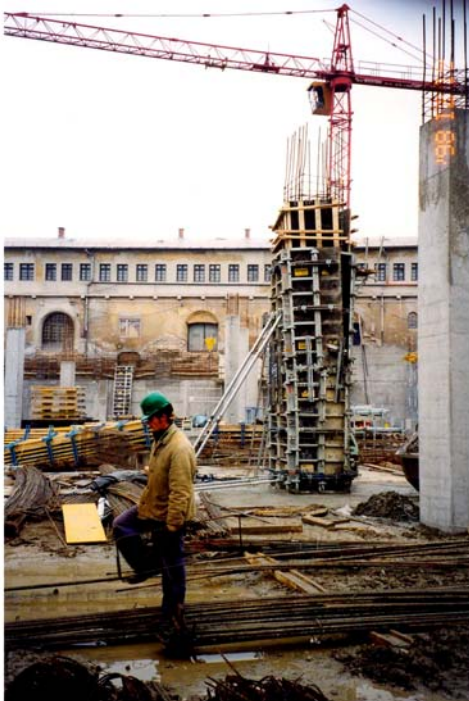
25. ábra. Szerelési hiba a betonozás során a pillérzsaluzat tönkremeneteléhez vezet 27
