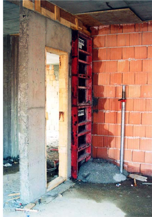
27. ábra. Az acélkeretes falzsaluzat is eldeformálódik ilyen körülmények között. – A falzsalu elemet és a támaszt hosszú időre bebetonozták 29
