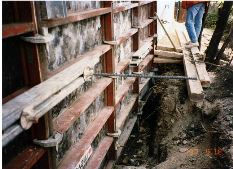
31. ábra. Falzsalu elhelyezés-, kifogásolható körülmény 33
