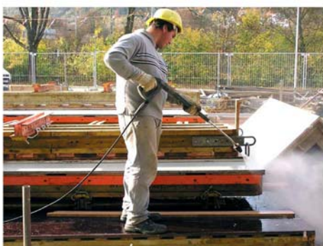
11. ábra. Műanyag zsaluhéj tisztítás vízzel, illetve forgótárcsás készülékkel 11
