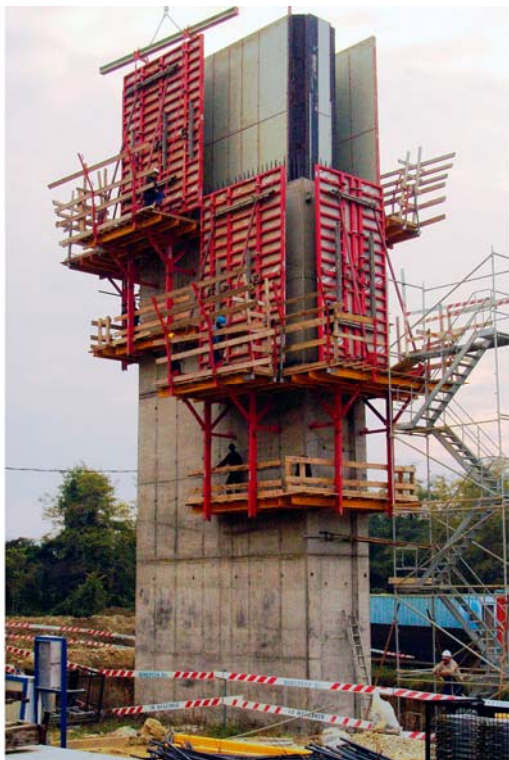
23. ábra. Kúszózszaluzat emelése himbával 25 – Pillérzszaluzáshoz használt állvány emelése 26
