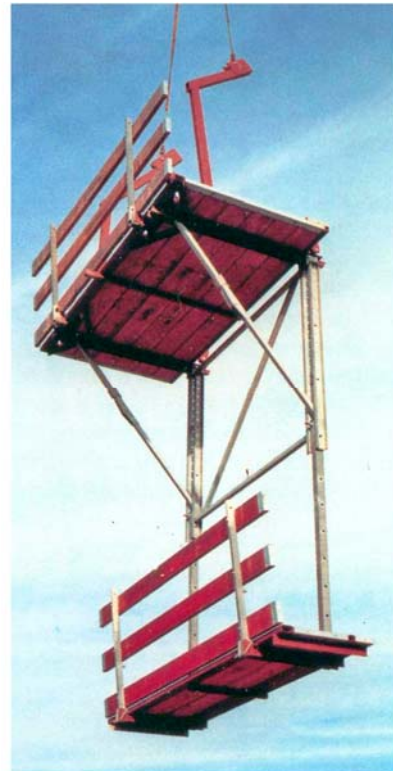
22. ábra. Konzolos állvány, emelés zsaluzattal (a) – Konzolos állvány, emelés himbával (b) 24
