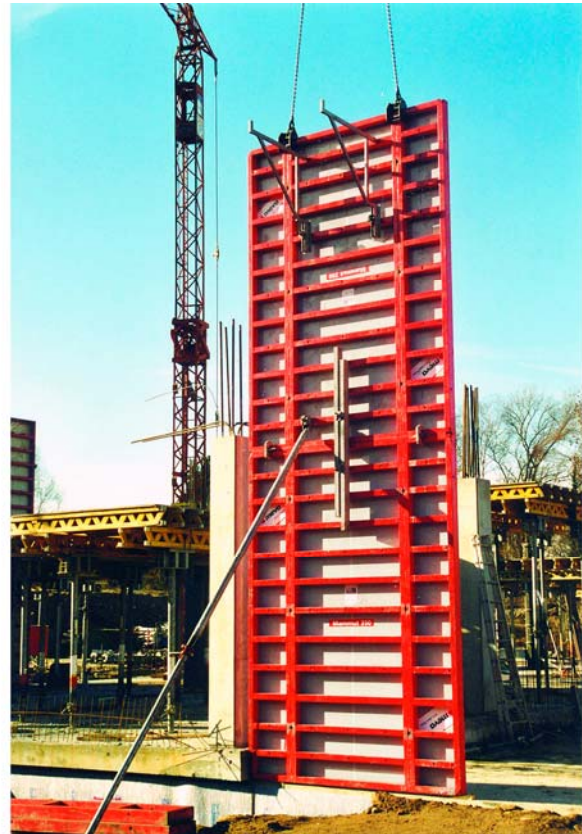
19. ábra. Liftakna belső zsaluzatának emelése himbával-, 7 m magas falzsalu egység emelése
