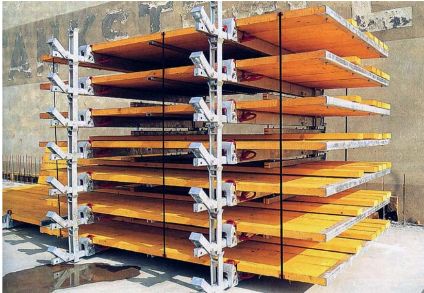
10. ábra. Munkaszinttel, korláttal felszerelt konzolos állvány tárolása 10
