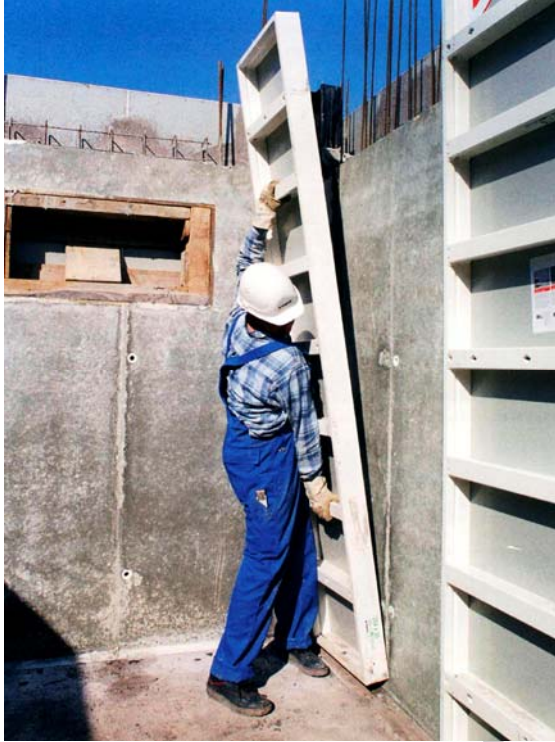
14. ábra. Falzsalu elem, bontás (a), 15 födémtámasz mozgató (b) 16
