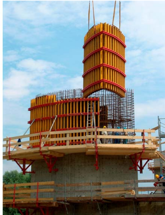
21. ábra. 12 m magas fatartós zsaluelem elhelyezése-, fatartós egyedi végelem daruzása 23
