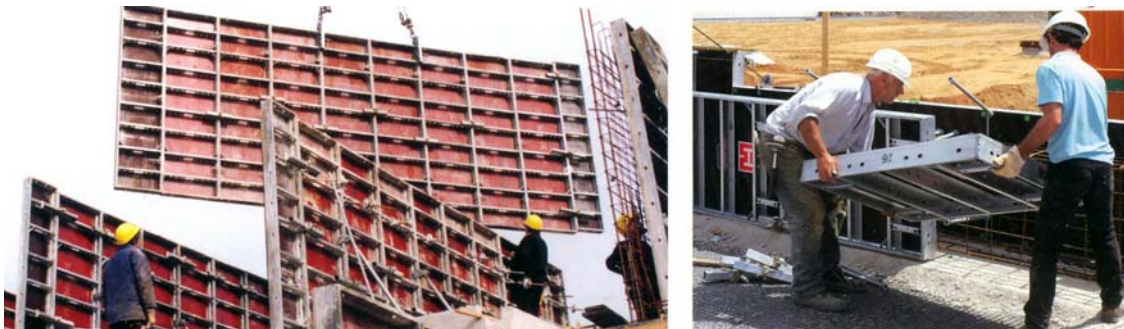
1. ábra. Falzsalu elemek gépi és kézi mozgása 1
