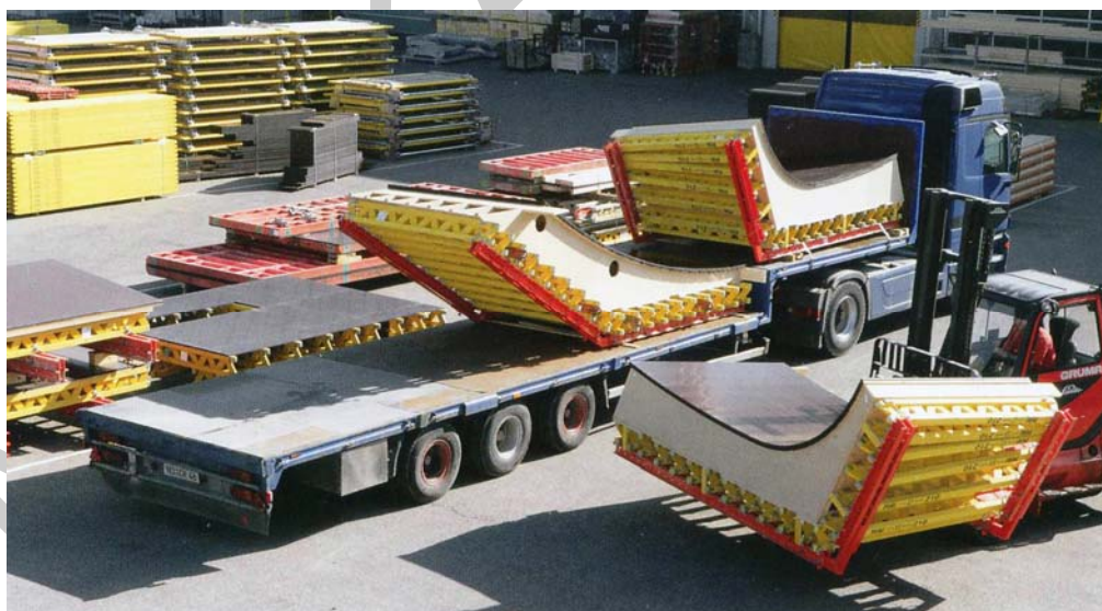
31. ábra. Egyedi formájú fatartós falzsalu elemek rakodása szállító gépjárműre 35
