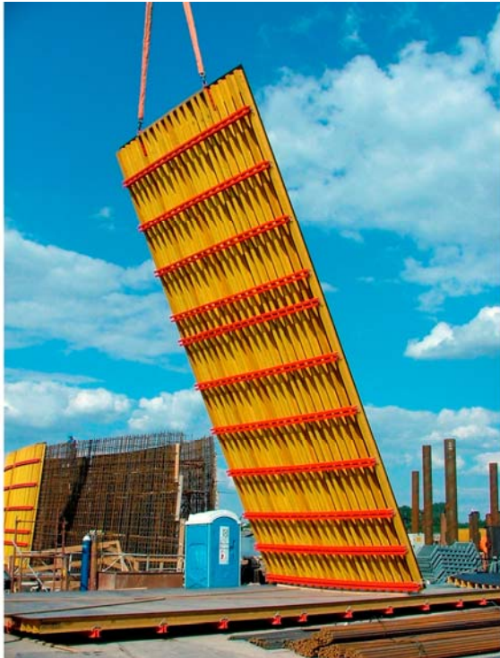
21. ábra. 12 m magas fatartós zsaluelem elhelyezése-, fatartós egyedi végelem daruzása 23
