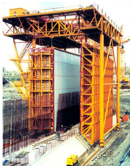
27. ábra. Javítóműhelyben, zsaluelemet mozgó bakdaru (a). – Átkötés nélküli, műanyag zsaluelemmel borított magas falzsalu szerkezetének mozgatás egyedi bakdaruval(b) 31
