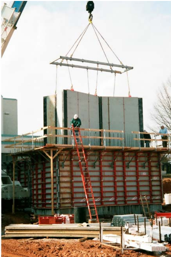
19. ábra. Liftakna belső zsaluzatának emelése himbával-, 7 m magas falzsalu egység emelése
