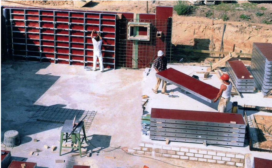
15. ábra. Nagyméretű falzsalu elem, kézi mozgatása 17
