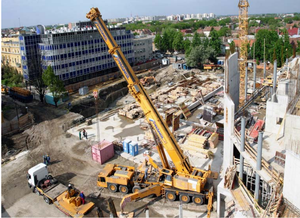
25. ábra. A toronydaru hatósugarán kívül levő, anyagfogadáshoz használt mobil autódaru 28
