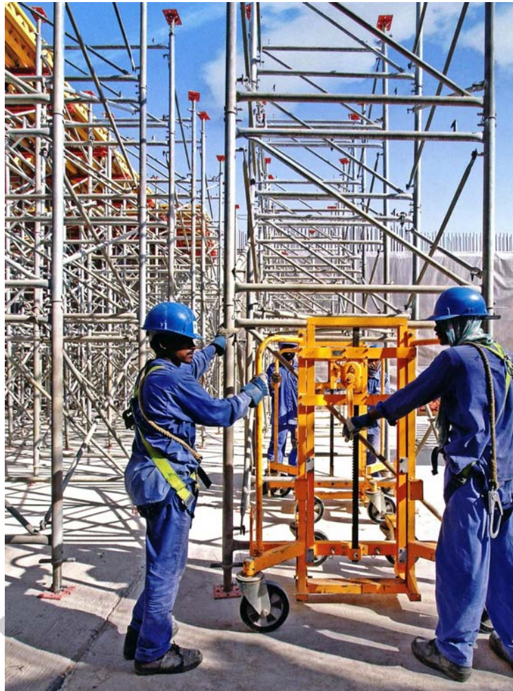
32. ábra. Alátámasztó állvány egységek kézi mozgatása, kizsaluzó kocsi segítségével 36
