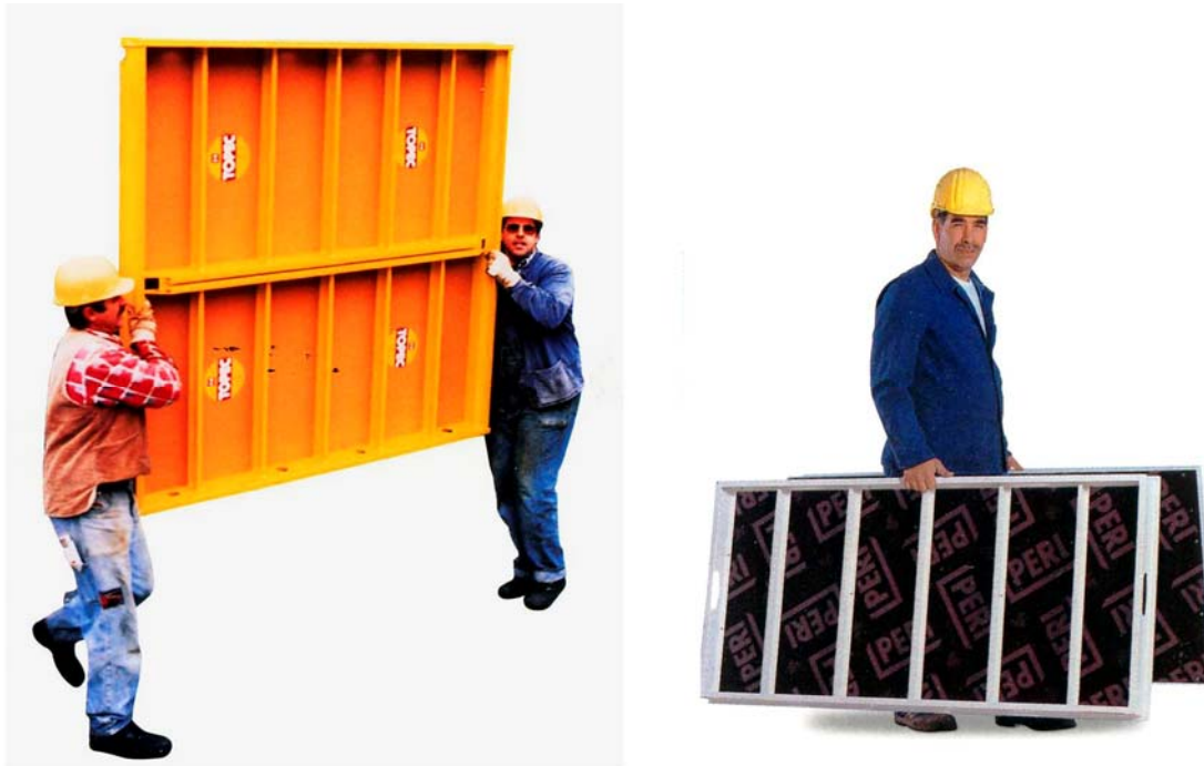
13. ábra. Alumínium keretes födémzsalu elemek mozgatása: két fővel (a) 13 és egy fő (b) 14
