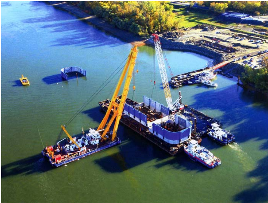
28. ábra. Mederpillérek víz alatti betonozásához szükséges vasbeton kéregelemek, acél őrfalak elhelyezése 120 t teherbírású úszódaruval 32
