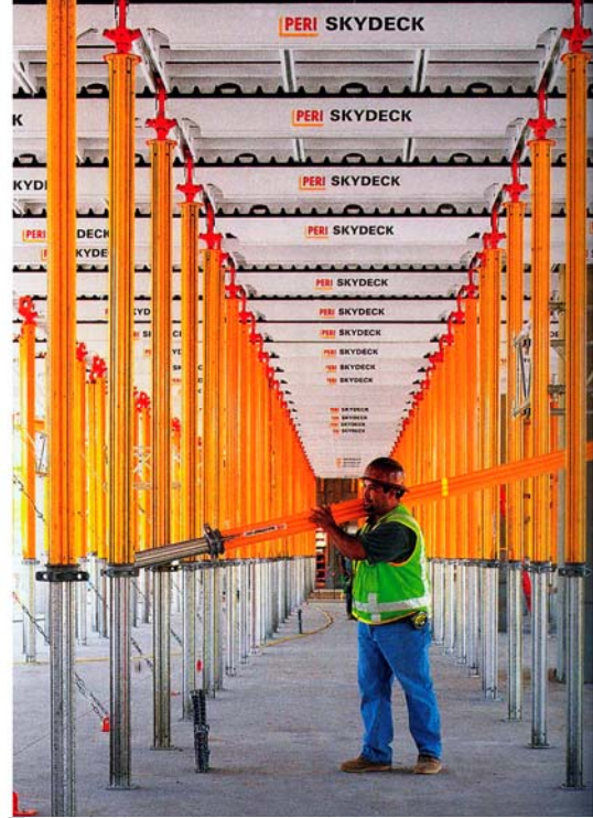
14. ábra. Falzsalu elem, bontás (a), 15 födémtámasz mozgató (b) 16
