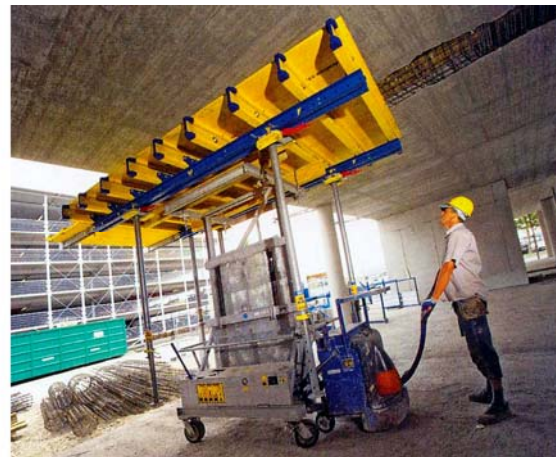
16. ábra. Födémzsalu betételelemek mozgatása (a) 18 – Födémasztal zsaluzat mozgatása (b) 19
