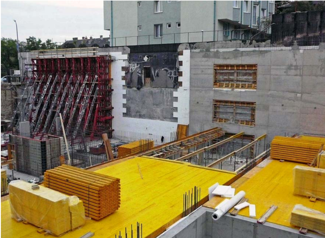
12. ábra. Zsalukötegek felhelyezése a már teljesen elkészült födémzsaluzaton 12
