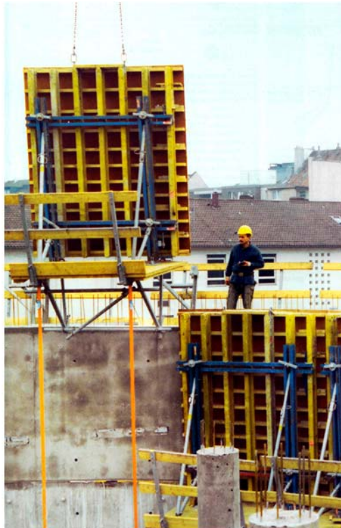
22. ábra. Konzolos állvány, emelés zsaluzattal (a) – Konzolos állvány, emelés himbával (b) 24
