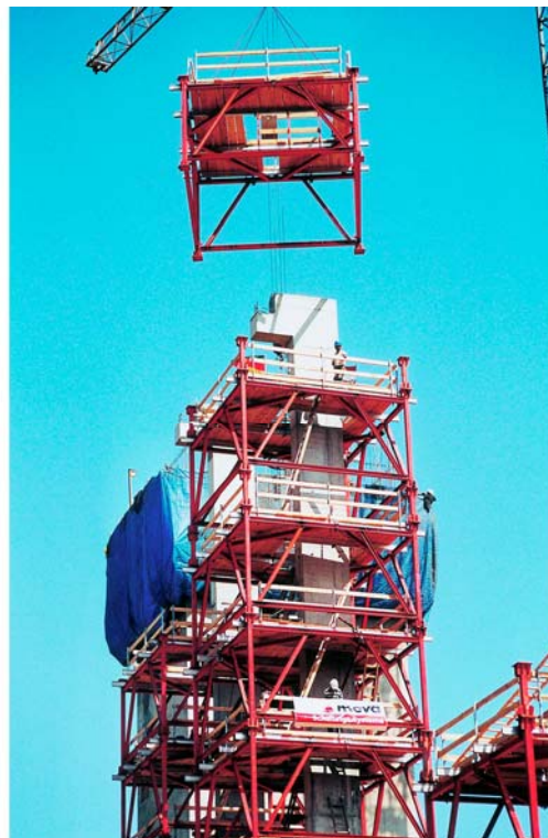
23. ábra. Kúszózszaluzat emelése himbával 25 – Pillérzszaluzáshoz használt állvány emelése 26
