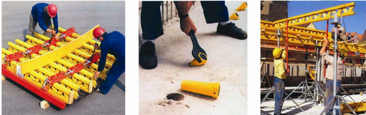
14. ábra. Villáskulcs használata zsaluszerelésnél, alkatrész eltávolításnál (a-b) – Fatartó elhelyezés szerelő villával (c) 17
