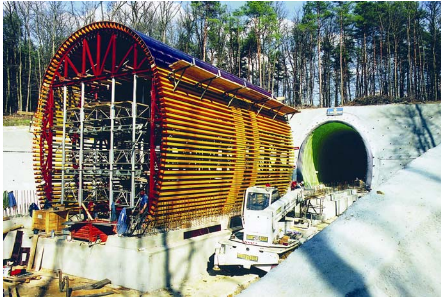
10. ábra. Alagút formáját az íves acélszerkezet adja meg 11
