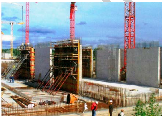
1. ábra. Egyenes és íves falszerkezetek zsaluzása fatartós zsaluzattal 1
