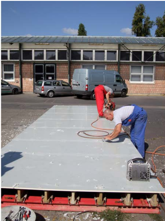
6. ábra. 9,0 m hosszú fatartós falzsalu műanyag zsaluhéjának összedolgozása 6
