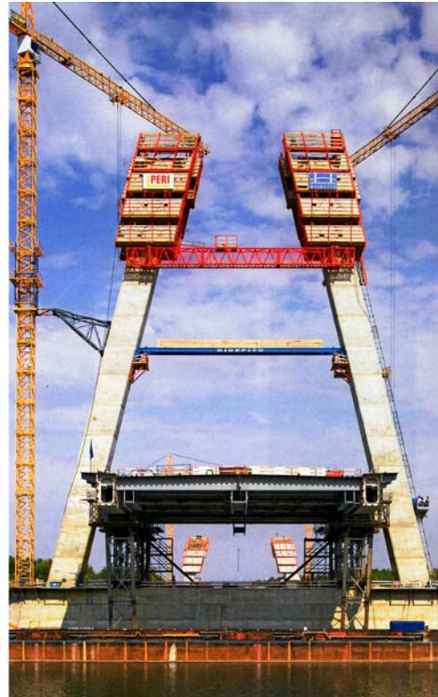
21. ábra. Zsaluzatszerelő kellékei (a) 24 – Folyami híd, 100m m magas pilonok zsaluzása (b) 25
