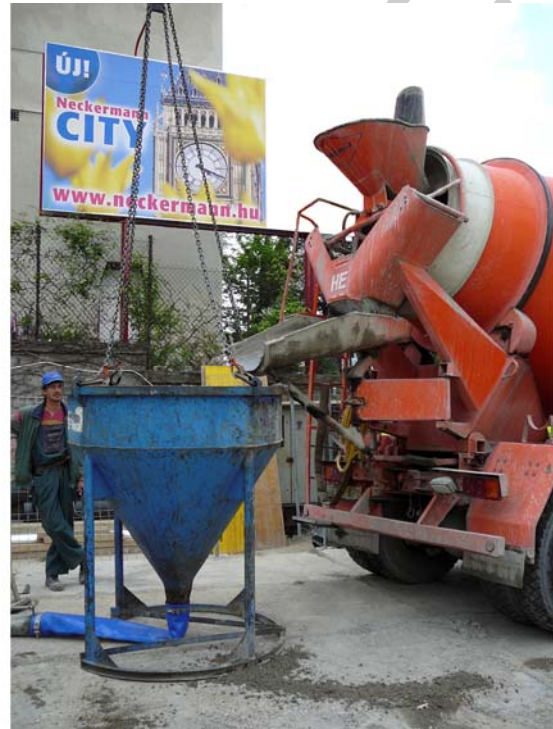
24. ábra. Betonozó nyílásos keretes falzsalu elemhez csatlakoztatott szivattyú. – Betonürítés konténerbe 28
