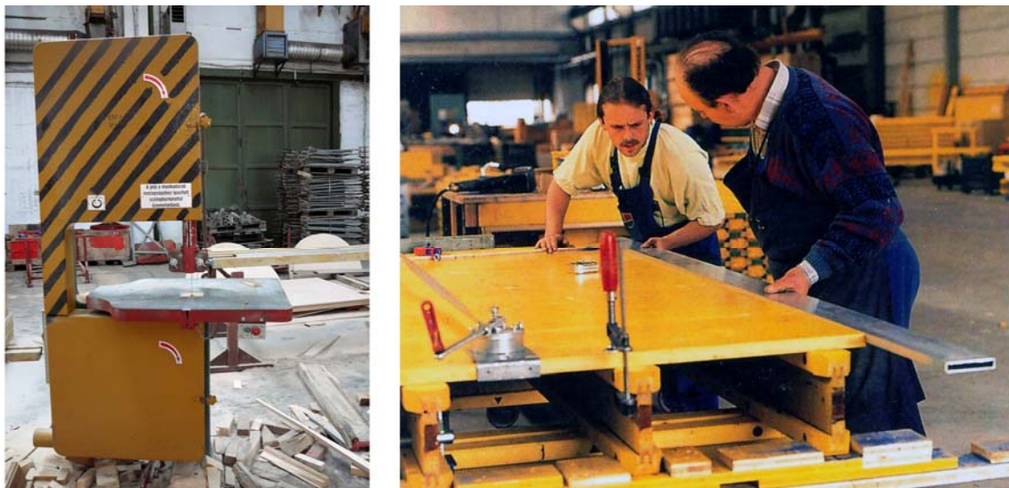
5. ábra. Faanyag szabásához használható szalagos fűrészgép (a) 5 – Fatartó és zsaluhéj szerelés közben történő ideiglenes megfogása pillanatszerűen (b)
