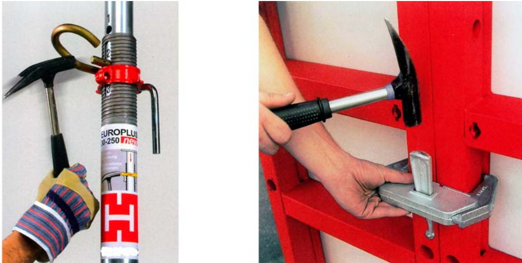
11. ábra. Födém támasz kengyel kiütés (a) 12 – Ékes zsalukapocs rögzítés kalapáccsal (b) 13
