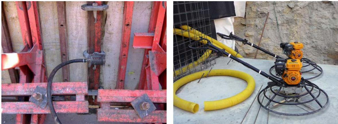
25. ábra. Acélkeretes falzsaluzatra kapcsolt zsaluvibrátor – Felületsimító 29
