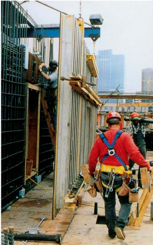
21. ábra. Zsaluzatszerelő kellékei (a) 24 – Folyami híd, 100m m magas pilonok zsaluzása (b) 25
