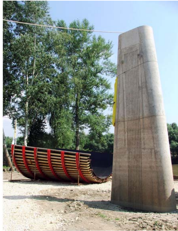
7. ábra. Acélhevederek végeinek végleges kialakítása (sarokcsiszolóval) 7 – Kész pillérzsaluzat és a kiszaluzott betonszerkezet 8
