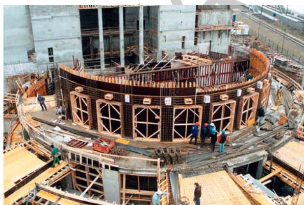
15. ábra. Kúszóállvány konzolelemei szerelés közben – Nyíláskirekesztések falzsalura rögzítve 18
