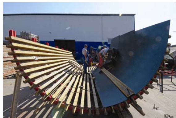
8. ábra. Íves acélhevederek tervszerinti elhelyezése, ideiglenes összefogása fa és acél segédanyaggal – Fatartóval felszerelt zsaluelem borítása ívre hajlítható fa zsaluhéjjal 9
