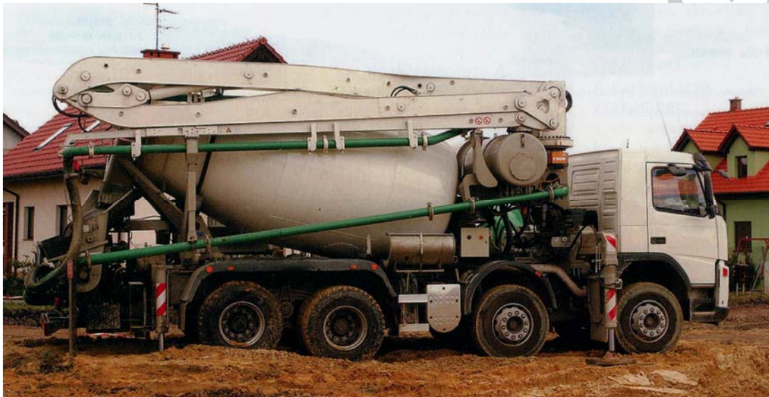
22. ábra. Beton pumpával felszerelt betonszállító jármű, mixer 26
