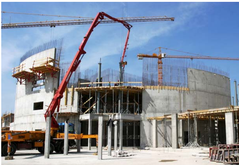
3. ábra. Födémbetonozás, betonozó pumpával 3
