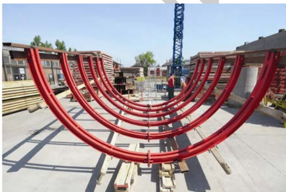
8. ábra. Íves acélhevederek tervszerinti elhelyezése, ideiglenes összefogása fa és acél segédanyaggal – Fatartóval felszerelt zsaluelem borítása ívre hajlítható fa zsaluhéjjal 9
