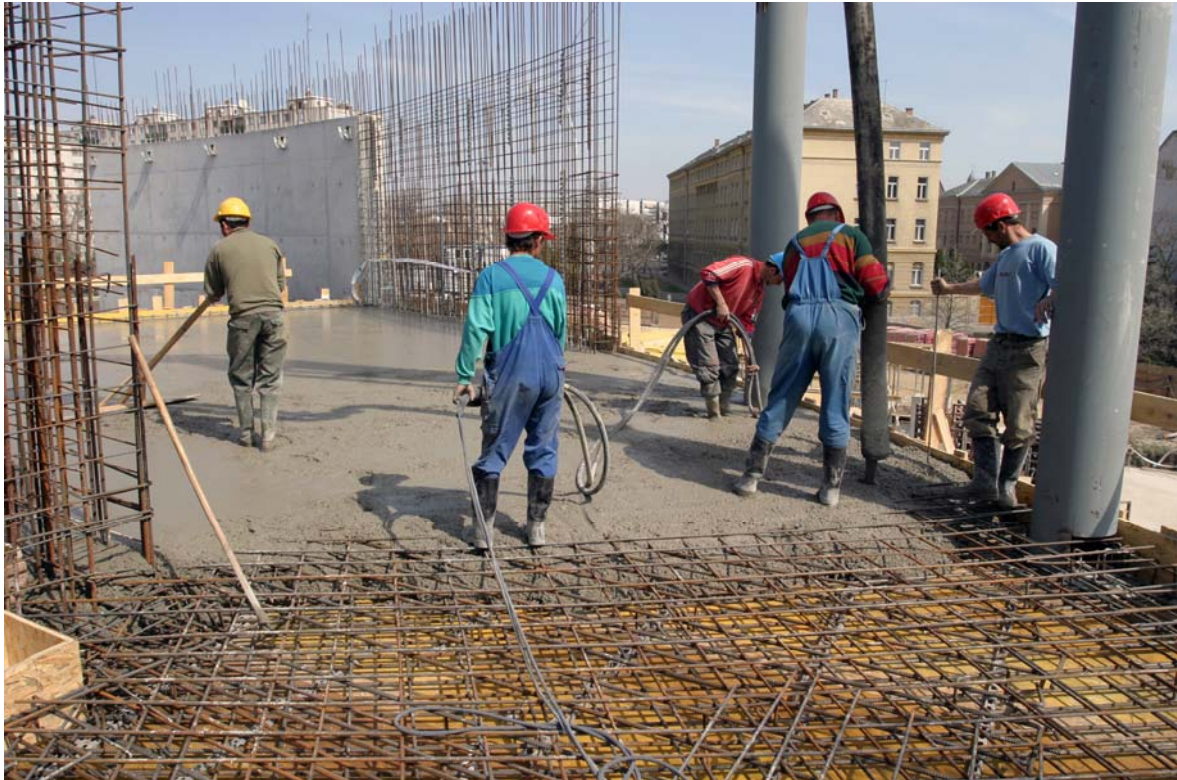
26. ábra. Födémbetonozás betonozó pumpával, – beton bedolgozás merülő vibrátorral, és simító léccel 30
