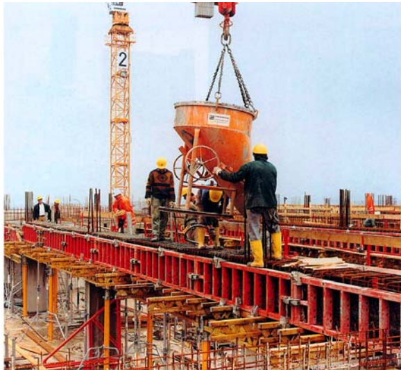
23. ábra. Gerendabetonozás konténerrel – Fal betonozás konténerrel, és vibrálás merülő vibrátorral 27
