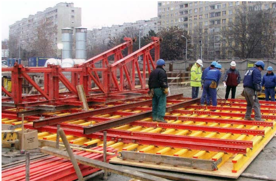
4. ábra. Egyoldali bakok felhelyezése a telephelyen előszerelt falzsaluzatra 4
