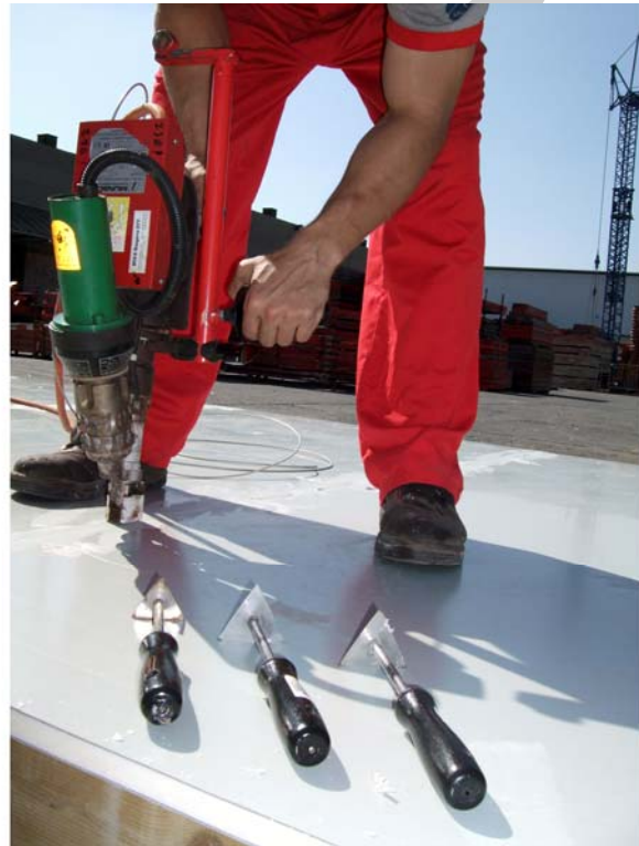
6. ábra. 9,0 m hosszú fatartós falzsalu műanyag zsaluhéjának összedolgozása 6
