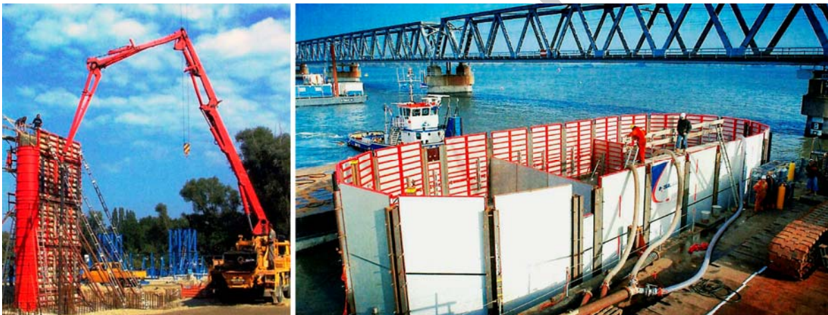
27. ábra. Híd pillér betonozása – Víz alatti betonozás 31
