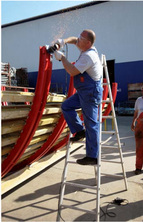
7. ábra. Acélhevederek végeinek végleges kialakítása (sarokcsiszolóval) 7 – Kész pillérzsaluzat és a kiszaluzott betonszerkezet 8
