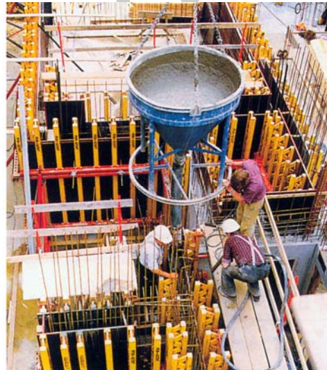
23. ábra. Gerendabetonozás konténerrel – Fal betonozás konténerrel, és vibrálás merülő vibrátorral 27
