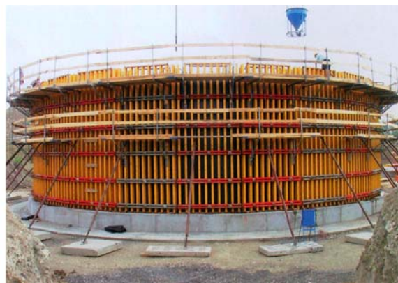
1. ábra. Egyenes és íves falszerkezetek zsaluzása fatartós zsaluzattal 1
