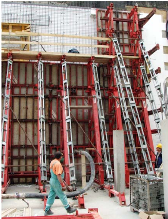
24. ábra. Betonozó nyílásos keretes falzsalu elemhez csatlakoztatott szivattyú. – Betonürítés konténerbe 28
