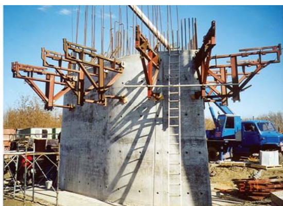
15. ábra. Kúszóállvány konzolelemei szerelés közben – Nyíláskirekesztések falzsalura rögzítve 18
