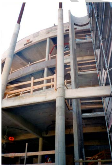
11. ábra. Az oszlopok csatlakozása elcsúszott. – A kész, burkolt felületen ez már nem látszik (Budapest, Nemzeti Színház)
