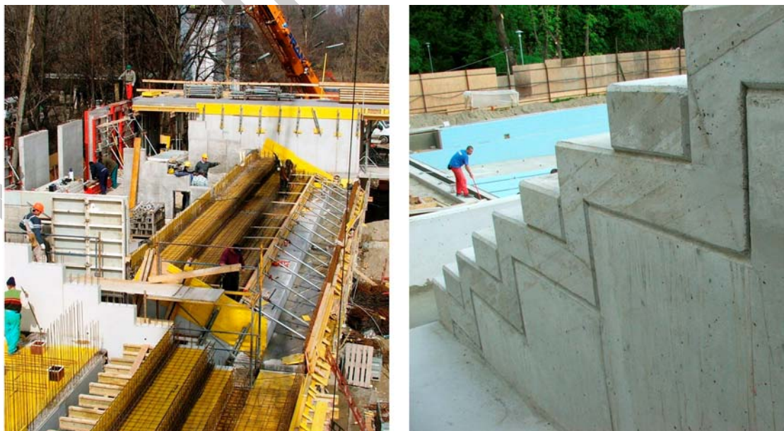
19. ábra. Lelátó zsaluzása és a kész lépcsőszerkezet látszóbeton felülete
