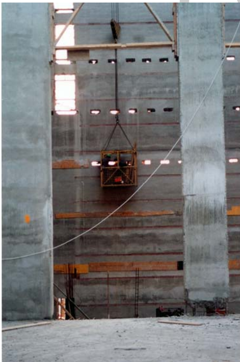
12. ábra. Súlyos hiba, amikor nem kerül beton a pillér aljába. – A végfalnál nincs meg a betontakarás, és a pontatlan zsaluelhelyezés, síktól való eltérést eredményezett
