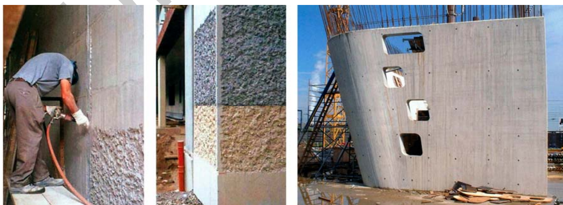
14. ábra. Felületdurvítással kialakított falmintázat és színezése. – Fal áttörések megjelenése, betonkörnyezete, a gondos kivitelezés eredménye
