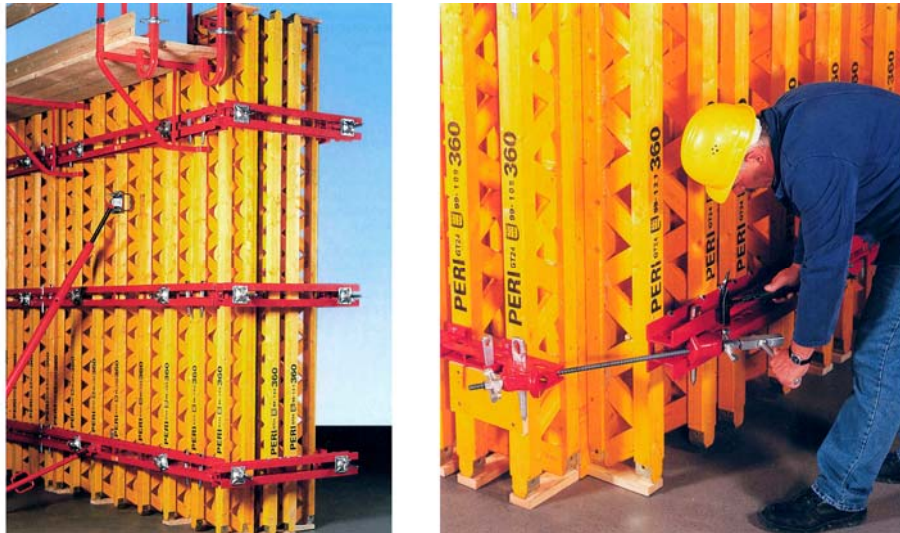
4. ábra. Fatartós falzsályuzat favég lezárása. – Külső sarok megfogása
