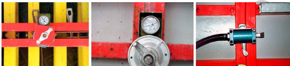
17. ábra. Feszültség mérő az átkötőszáron (a)(b) – Keretes falzsaluzatra ékes kapoccsal rögzített zsaluvibrátor (c)
