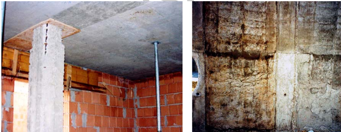
20. ábra. Monolit vasbeton pillér – Íves vasbeton fal kizsaluzott felülete
