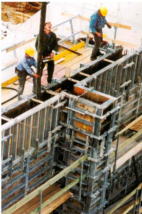
15. ábra. Betonozó pumpa leengedése falzsaluzatba (a) – Pillérbetonozás konténerral (b)
