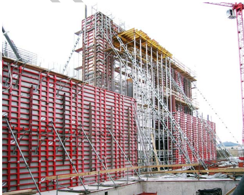
5. ábra. Keretes falzsályuzat különböző magasságú oldaltámaszai
