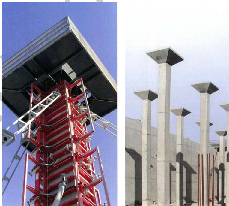
3. ábra. Fémkeretes nyitható pillérzsaluzat, betonozó munkaszinttel
