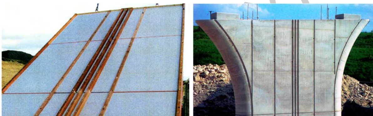
13. ábra. A falzsaluzatra helyezett dísztű bordák a betonfelületen negatív mintázatot adnak
