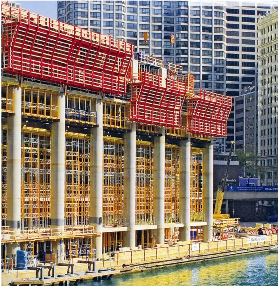
6. ábra. Födémzsaluzatot alátámasztó teherviselő keretes állvány
