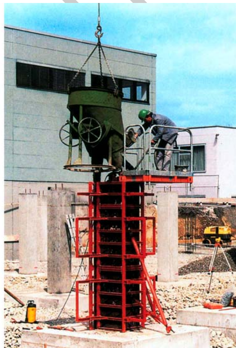
15. ábra. Betonozó pumpa leengedése falzsaluzatba (a) – Pillérbetonozás konténerral (b)
