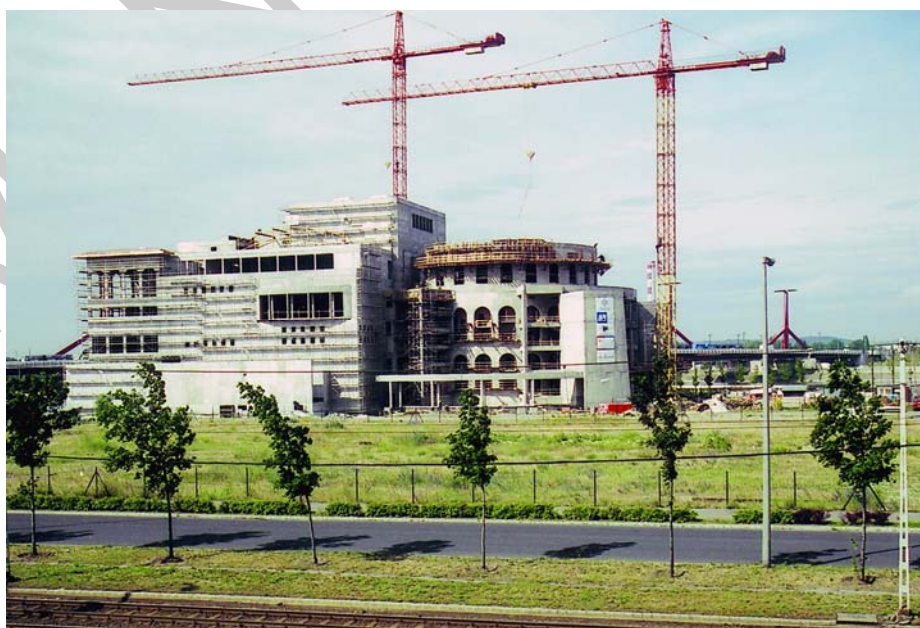
2. ábra. Vasbeton szerkezet felső szintjének zsaluzása (Budapest, Nemzeti Színház)
