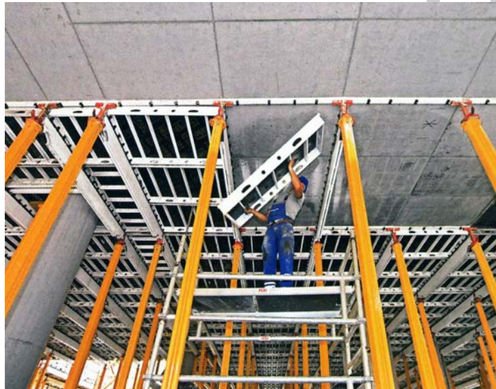
10. ábra. Alumínium szerkezetű ejtőfejes födémzsaluzat kizsaluzásánál a támaszok a födém alatt maradnak
