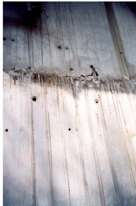
12. ábra. Súlyos hiba, amikor nem kerül beton a pillér aljába. – A végfalnál nincs meg a betontakarás, és a pontatlan zsaluelhelyezés, síktól való eltérést eredményezett
