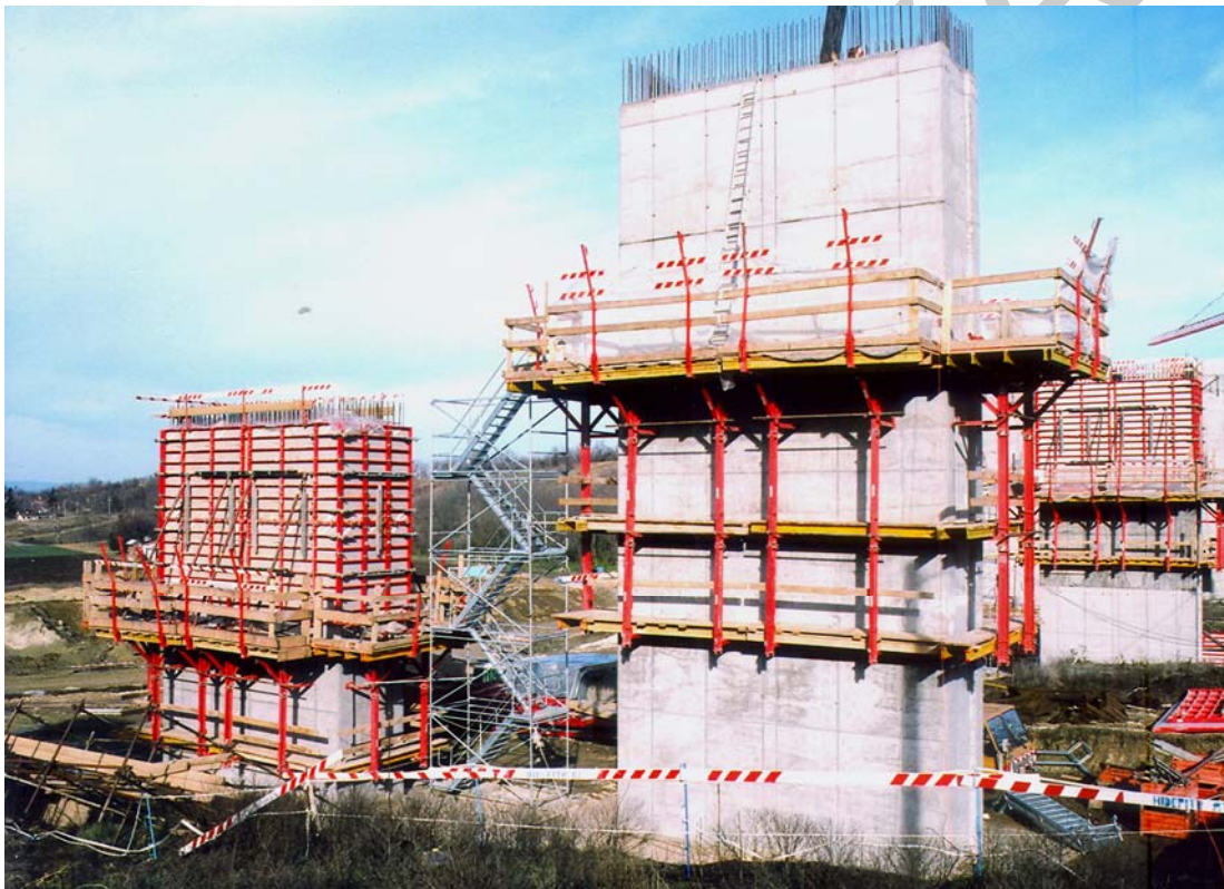
16. ábra. Völgyhíd pilléreinek zsaluzása keretes falzsaluval, az alsó munkaszinttel felszerelt kúszóállványról
