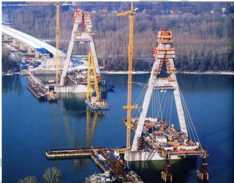
20. ábra. Duna-híd pilonjainak zsaluzása
