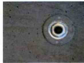
Állványbontást követően a kúszókónusz visszanyerhető és újból beépíthető, de a tárcsás csavar a betonban marad
