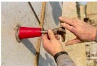
Kúszóállvány lehorgonyzó szerkezetének felhelyezése a falzsaluzatra
