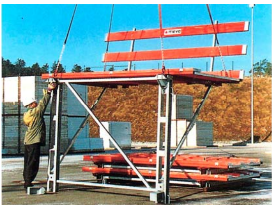
9. ábra. A csuklós kitámasztó biztosítása, az akasztó szerelvény felhelyezése – a kész állvány a fogadószerkezetre felakasztható
