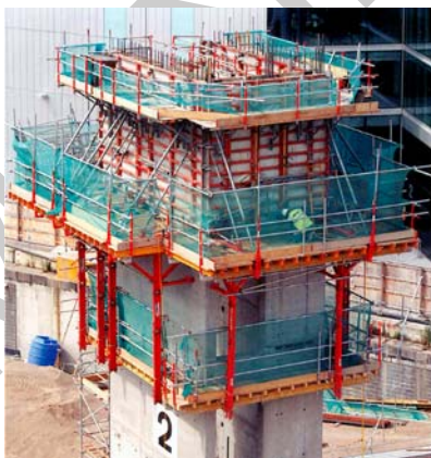
1. ábra. Lépcsőházi és liftakna falak zsaluzása kúszó zsaluzattal – homlokzati falak építése konzolos munkaállványról 1
