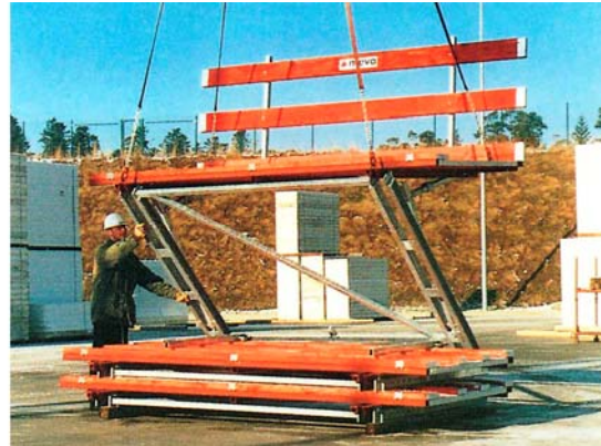
8. ábra. Korlátrész felnyitása, rögzítése – négyágú darukötéssel az állvány megemelése
