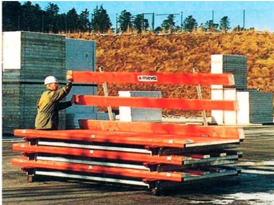
8. ábra. Korlátrész felnyitása, rögzítése – négyágú darukötéssel az állvány megemelése
