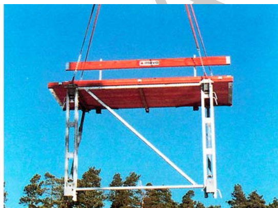
9. ábra. A csuklós kitámasztó biztosítása, az akasztó szerelvény felhelyezése – a kész állvány a fogadószerkezetre felakasztható
