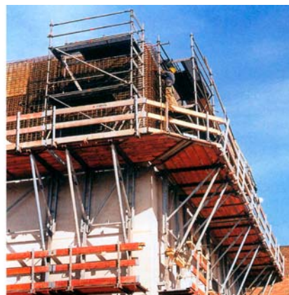
1. ábra. Lépcsőházi és liftakna falak zsaluzása kúszó zsaluzattal – homlokzati falak építése konzolos munkaállványról 1
