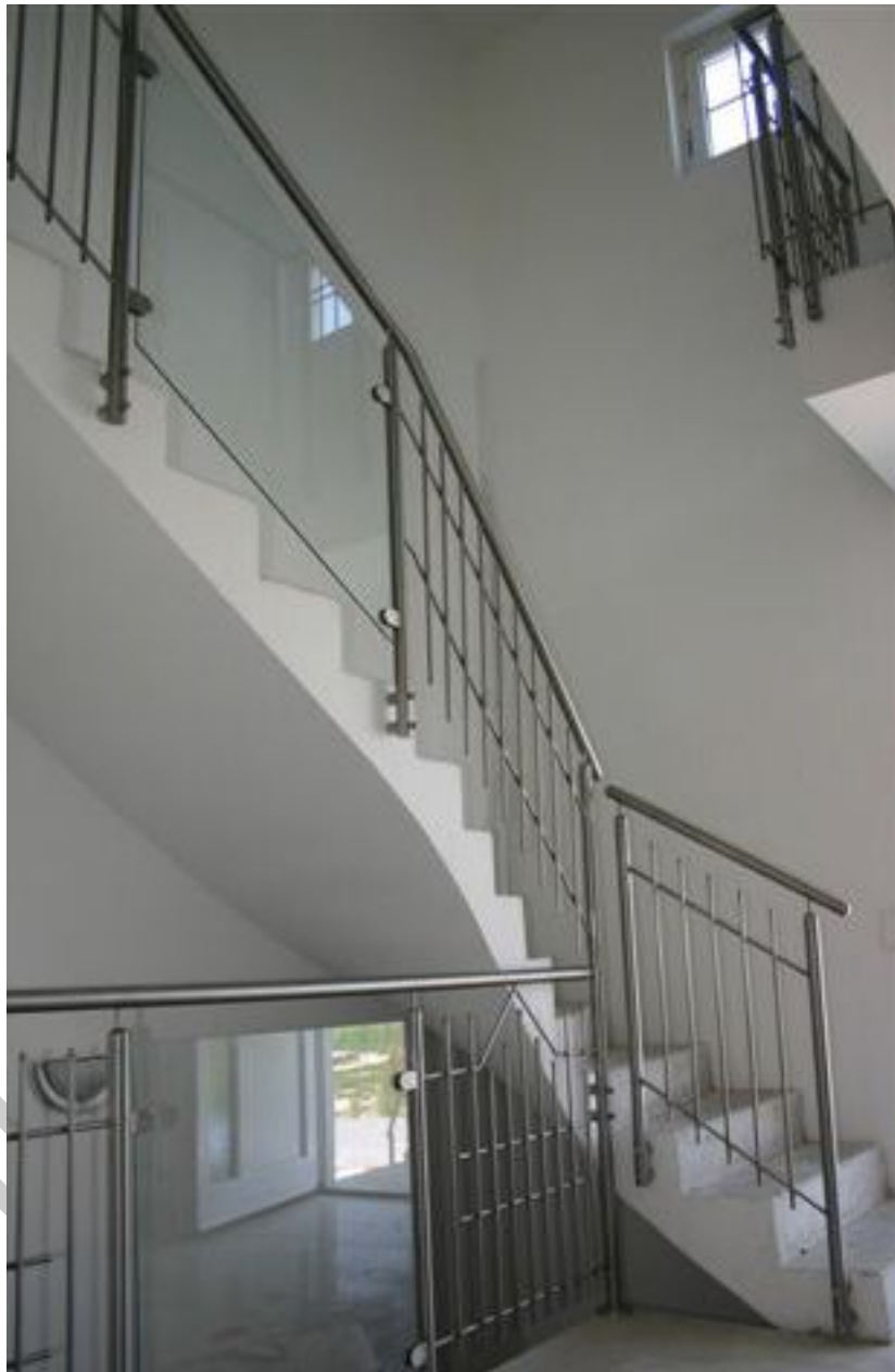
9. ábra. Lemezgyámoltású vasbeton lépcső
