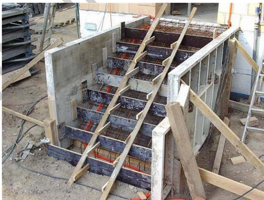
7. ábra. "Épülő" előlépcső
